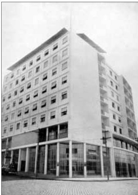
Figura 4 – Vista do edifício Sahão depois de pronto, uma construção imponente no centro de Londrina
