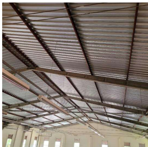
Galpão Setorial Cascavel:
