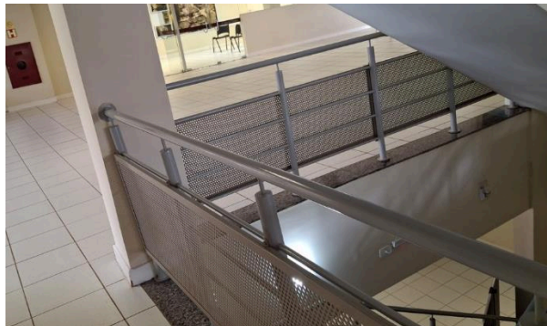
Garda-corpos de fechamento do perímetro do fosso da escada central, serão parcialmente reaproveitados
