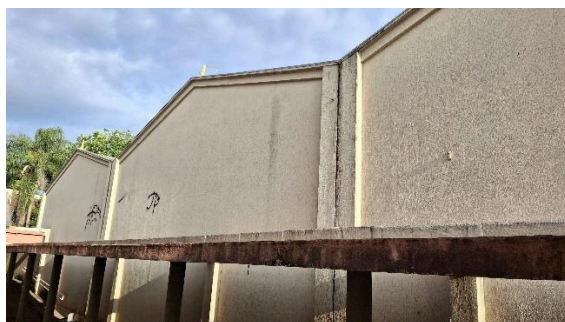
Juntas de dilatação entre os pórticos
