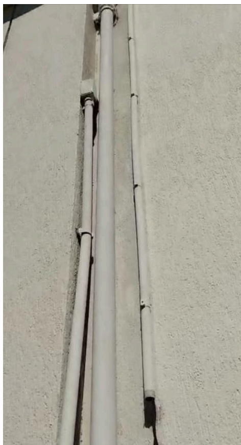
Trecho de cabo de SPDA a ser substituído
