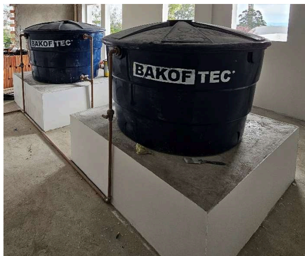
Base de caixa d'água em alvenaria com laje de piso
