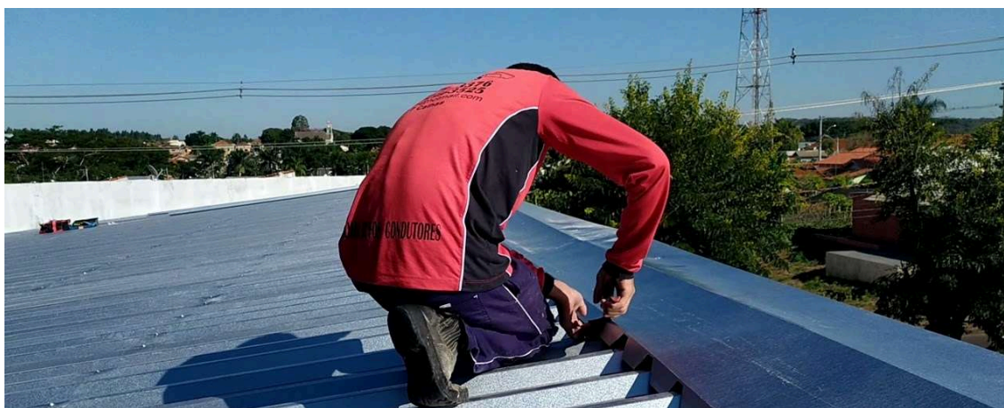
Recorte correto de rufo transversal à telha
