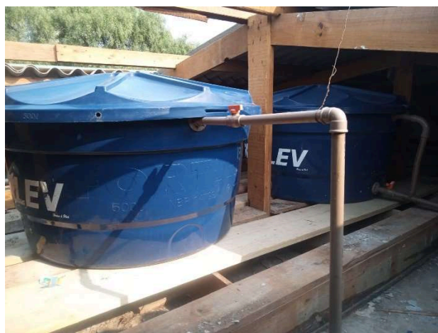
Base de caixa d'água em estrutura de madeira
