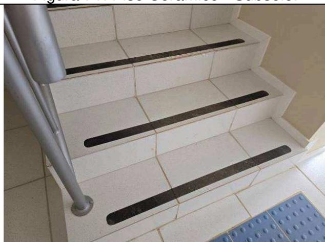
Figura 73: Fitas antiderrapantes nas escadas.
