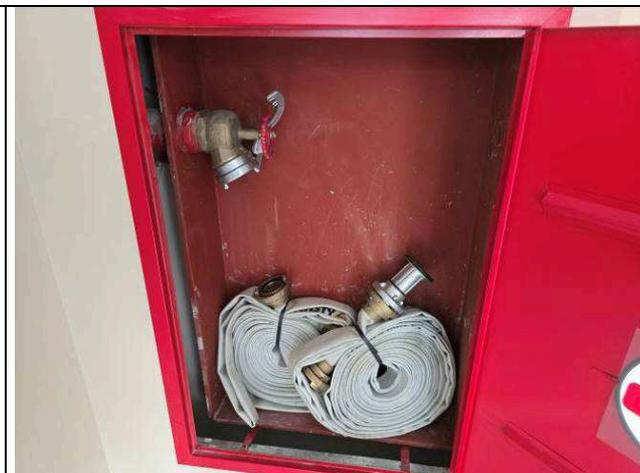
Figura 90: Hidrante – Subsolo.
