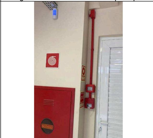
Figura 44E: SDAI e acionamento bombas
