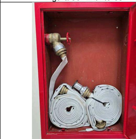
Figura 88: Hidrante – 1º Pavimento.
