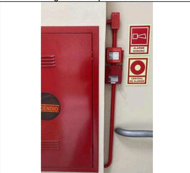
Figura 43E: SDAI e acionamento bombas
