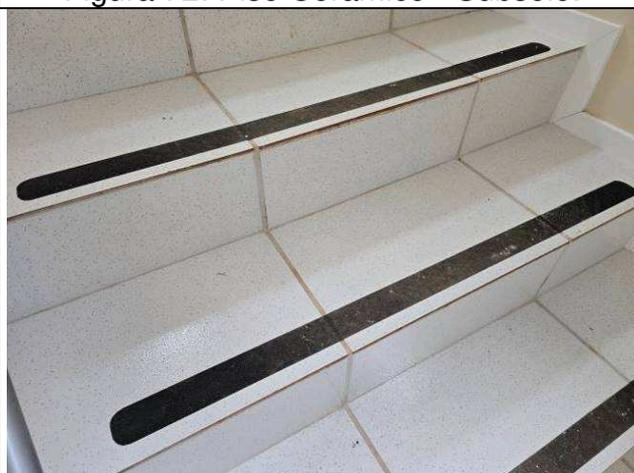
Figura 74: Fitas antiderrapantes nas escadas.
