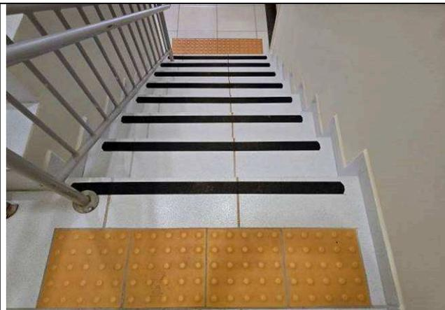
Figura 130: Fitas antiderrapantes – escada central.
