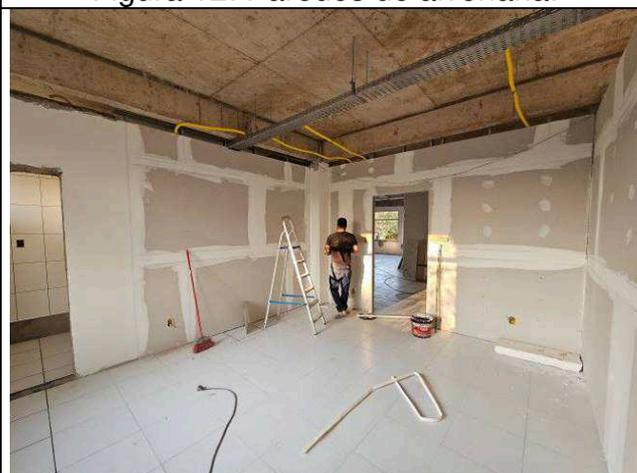
Figura 14: Paredes de gesso acartonado.
