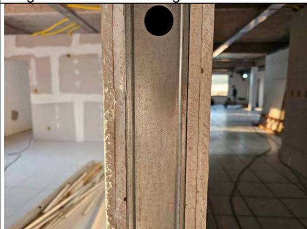
Figura 18: Paredes de gesso acartonado.
