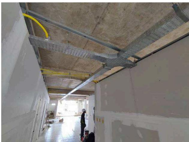
Figura 03E: infraestrutura eletrocalhas, perfilados, acessórios, eletrodutos 4ª VT
