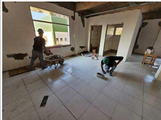
Figura 36: Piso cerâmico - 1º Pavimento.
