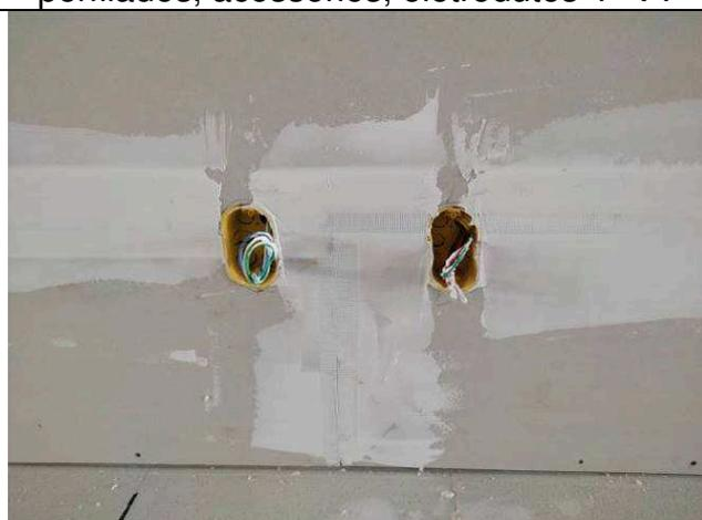
Figura 09E: infraestrutura, caixas 2x4" e cabeamento elétrico 4ª VT
