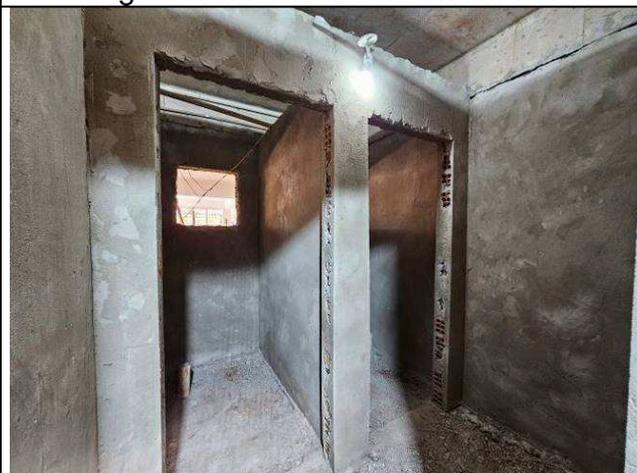
Figura 12: Paredes de alvenaria.
