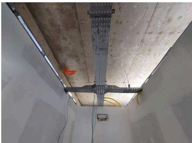
Figura 01E: infraestrutura eletrocalhas, perfilados, acessórios, eletrodutos 4ª VT
