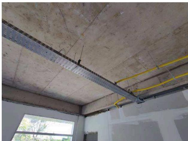
Figura 02E: infraestrutura eletrocalhas, perfilados, acessórios, eletrodutos 4ª VT
