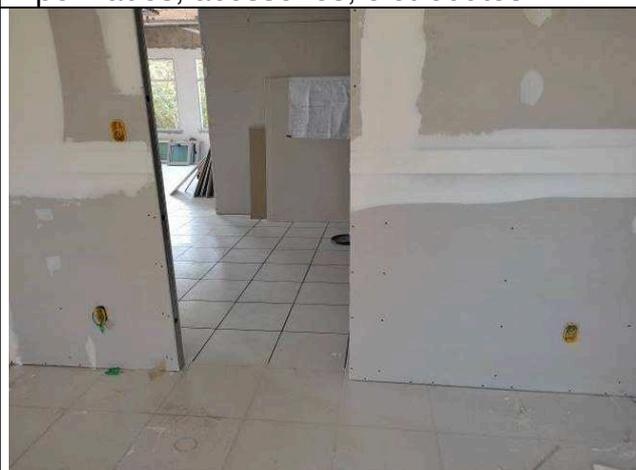
Figura 08E: infraestrutura, caixas 2x4" e cabeamento elétrico 4ª VT
