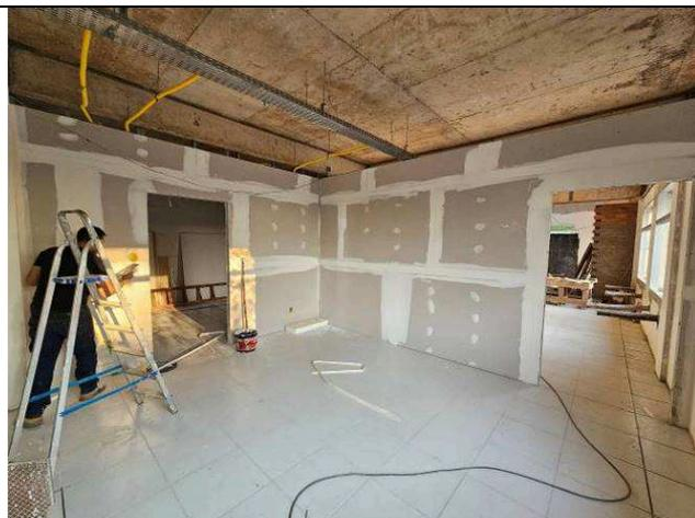
Figura 15: Paredes de gesso acartonado.
