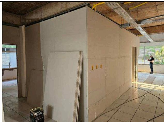
Figura 16: Paredes de gesso acartonado.
