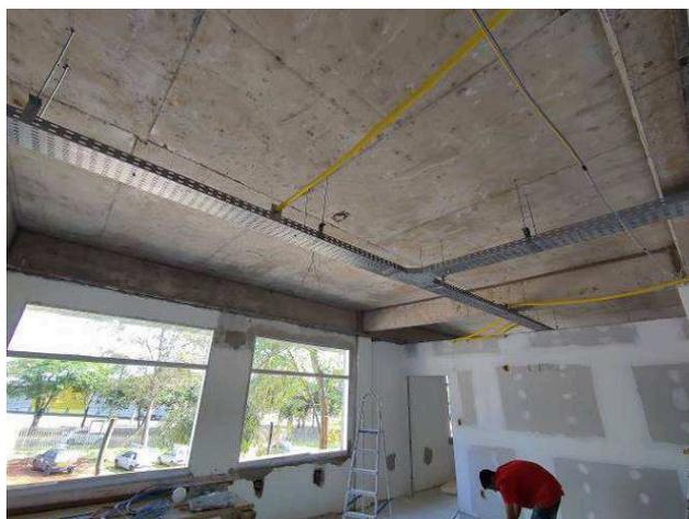
Figura 04E: infraestrutura eletrocalhas, perfilados, acessórios, eletrodutos 4ª VT
