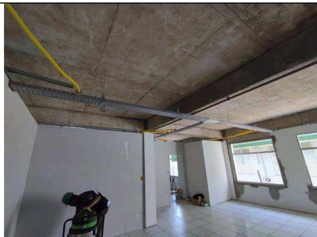
Figura 05E: infraestrutura eletrocalhas, perfilados, acessórios, eletrodutos 4ª VT
