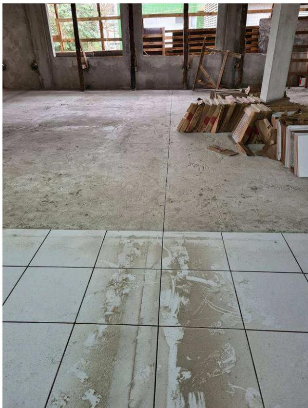
Figura 33: Piso cerâmico - corte das juntas de movimentação - 1º Pavimento.
