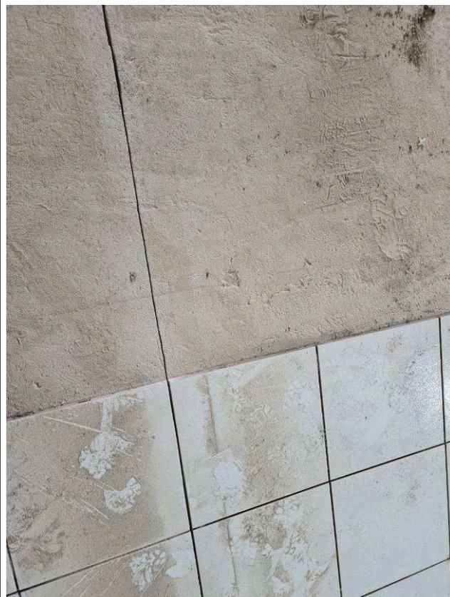
Figura 34: Piso cerâmico - corte das juntas de movimentação - 1º Pavimento.
