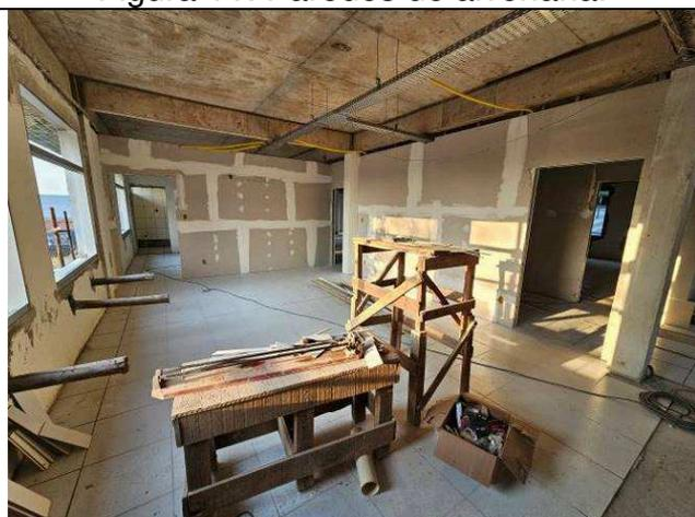
Figura 13: Paredes de gesso acartonado.
