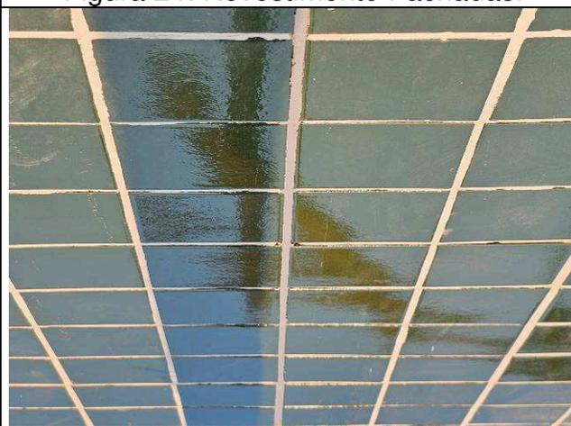
Figura 26: Revestimento Fachadas – junta de dilatação.
