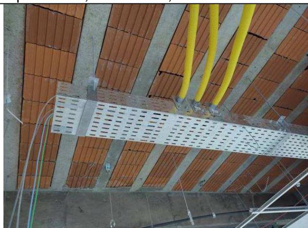
Figura 07E: infraestrutura eletrocalhas, perfilados, acessórios, eletrodutos 4ª VT
