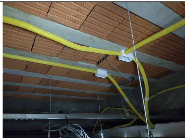
Figura 06E: infraestrutura eletrocalhas, perfilados, acessórios, eletrodutos 4ª VT
