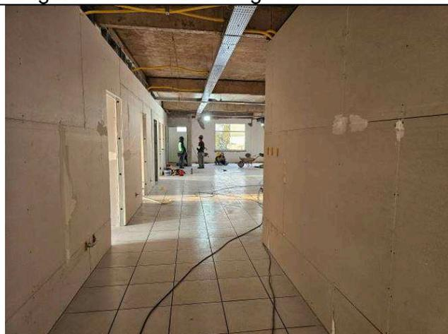
Figura 17: Paredes de gesso acartonado.
