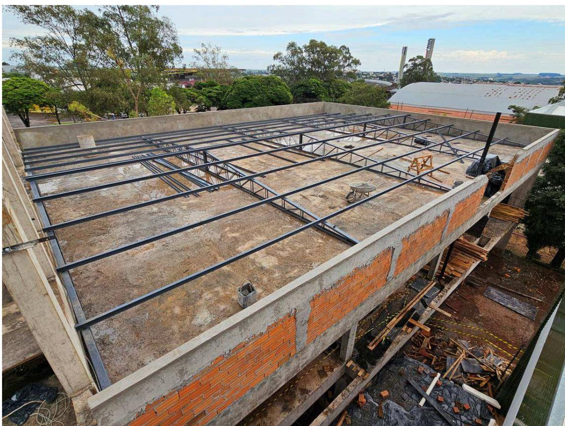
Figura 1 – Vista da laje de cobertura com a montagem da estrutura metálica.
