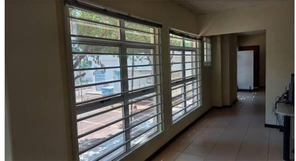
Figura I.5.6C: Gradis metálicos instalados em janelas 180x190cm, na sala dos oficiais de justiça
