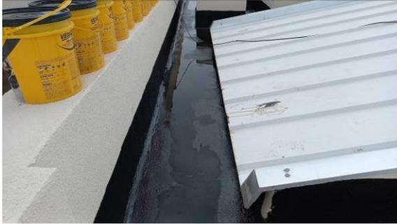
Figura I.8.29C: Aplicação de manta líquida sobre laje na região do saguão
