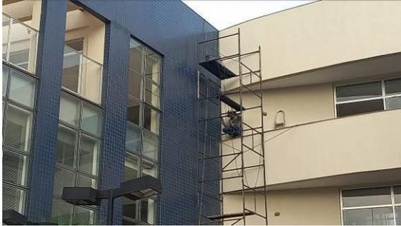
Fixação de pastilhas na fachada frontal do bloco esquerdo
