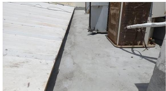
Figura I.8.24C: Proteção mecânica executada sobre a manta, na região da sala osso
