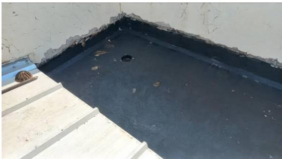
Figura 1.8.9C: Imprimação de trecho de laje, sobre a região da sala osso, para aplicação de manta
