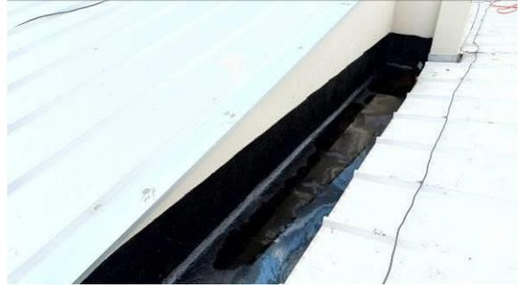
Figura I.8.30C: Aplicação de manta líquida sobre laje na região do restaurante
