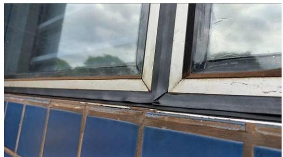
Figura I.3.10C: Detalhe da instalação das gaxetas em EPDM novas, instaladas em peles de vidro
