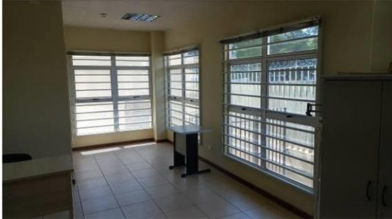
Figura I.5.5C: Gradis metálicos instalados em janelas 180x190cm, no ambulatório
