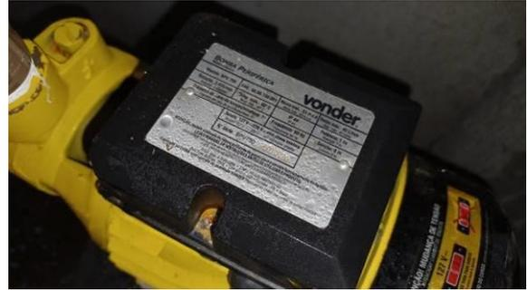
Figura I.6.C: Etiqueta da bomba de reuso, com potência de 1CV
