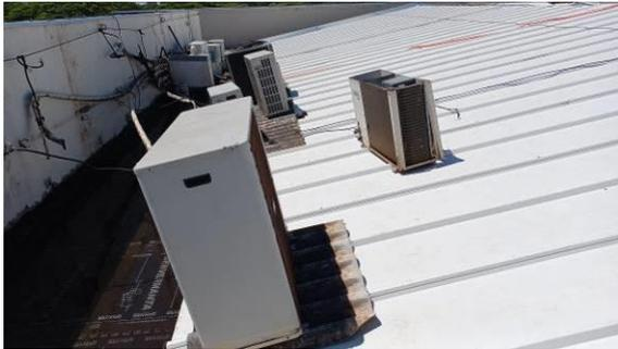
Figura I.8.1C: Desconexão e remoção de aparelhos de ar condicionado na região sobre a sala osso
