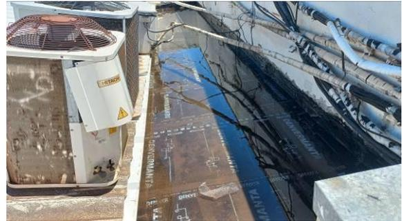
Figura I.8.2C: Desconexão e remoção de aparelhos de ar condicionado na região sobre o arquivo
