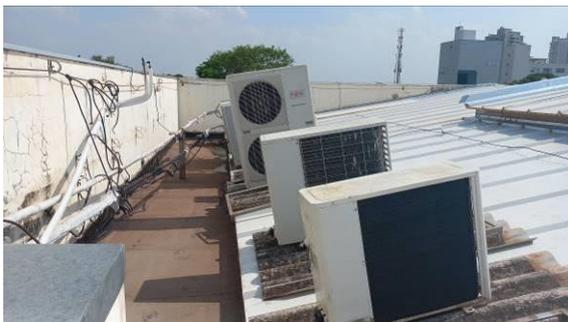
Figura I.8.3C: Desconexão e remoção de aparelhos de ar condicionado na região sobre o Cejusc
