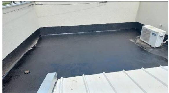
Figura I.8.34C: Aplicação de manta líquida sobre laje na região do auditório
