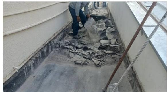
Figura I.8.4C: Início da demolição da proteção mecânica e retirada da manta deteriorada na região sobre o arquivo
