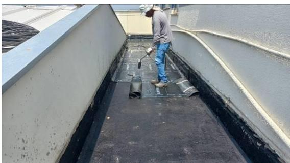
Figura 1.8.11C: Operário realizando a aplicação da manta asfáltica em área de laje sobre o arquivo
