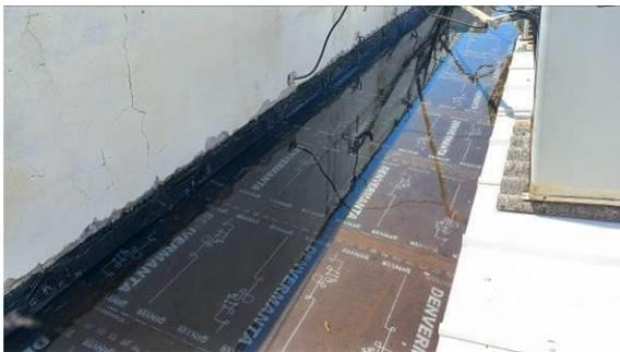
Figura I.8.15C: Teste de estanqueidade (72h), sendo realizado em laje já impermeabilizada sobre a sala osso
