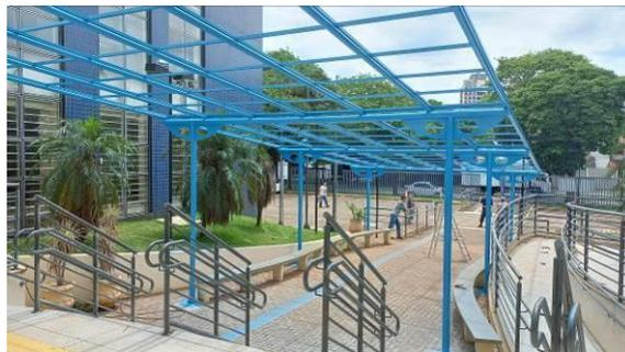
Estrutura metálica finalizada, aguardando a cobertura em policarbonato
