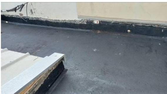
Figura 1.8.7C: Imprimação de trecho de laje, sobre a região do arquivo, para aplicação de manta
