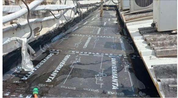
Figura I.8.14C: Mata asfáltica aplicada em laje sobre trecho do Cejusc
