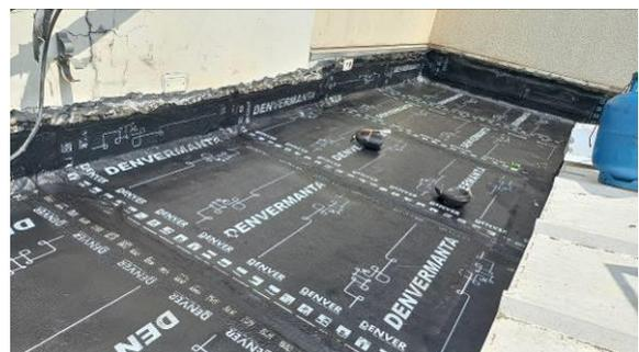
Figura 1.8.12C: Mata asfáltica aplicada em laje sobre trecho do Cejusc
