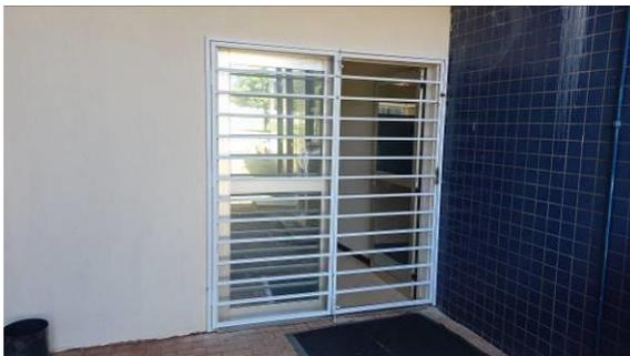
Figura I.5.11C: Gradil metálico de abrir, instalado na porta dupla de acesso ao saguão, pelo lado esquerdo
