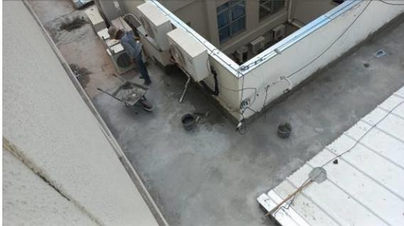
Figura I.8.21C: Início da execução da proteção mecânica sobre a manta aplicada em laje sobre trecho do arquivo
