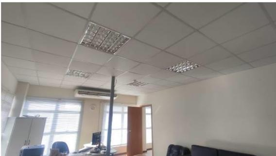
Figura I.6.1E: Iluminação interna modelo embutir LED 4x10W – ambientes com forro modular SEA e STI
