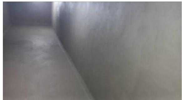
Figura I.8.42C: Reservatório inferior esquerdo, com paredes impermeabilizadas com Sikatop-100
