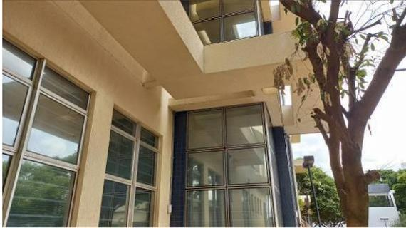
Figura I.3.5C: Substituição das borrachas de vedação (gaxetas) das peles de vidro – Direção do Fórum e Sala de audiência 1, na 4ª Vara
