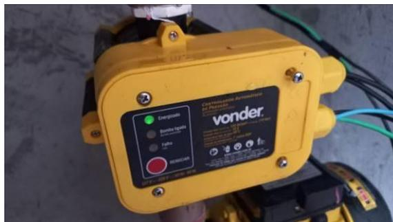
Figura I.6.1C: Pressostato da bomba de reuso
