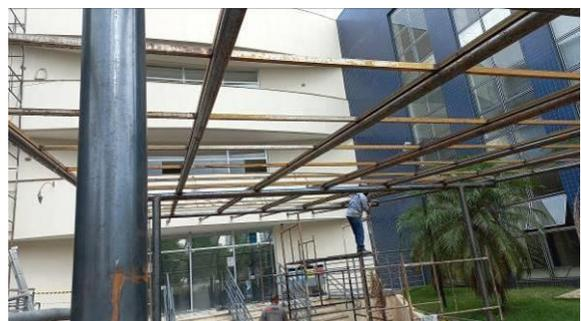
Cobertura metálica da entrada principal - Operário realizando a fixação das terças, com os pórticos já finalizados
