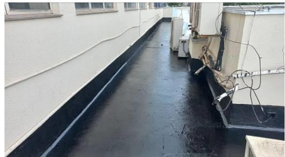
Figura I.8.26C: Aplicação de manta líquida sobre laje na região do arquivo
