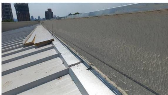
Figura 1.4.5C: Aplicação de textura acrílica em faces internas das platibandas – Região sobre o restaurante
