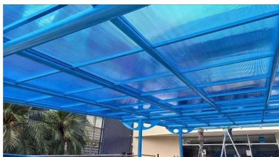
Processo de instalação da cobertura em policarbonato
