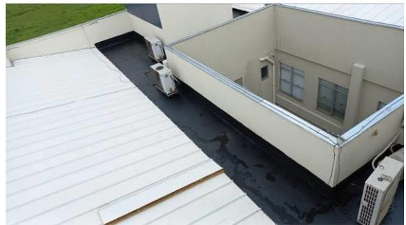
Figura I.8.32C: Aplicação de manta líquida sobre laje na região da 4ª vara
