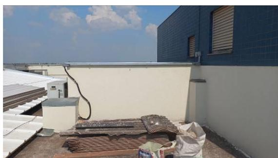
Figura 1.4.4C: Aplicação de textura acrílica em faces internas das platibandas – Região sobre o restaurante
