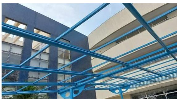
Estrutura metálica finalizada, aguardando a cobertura em policarbonato
