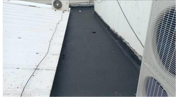
Figura 1.8.6C: Imprimação de trecho de laje, sobre a região do arquivo, para aplicação de manta
