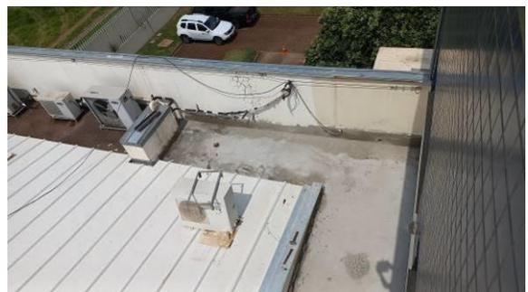
Figura I.8.20C: Início da execução da proteção mecânica sobre a manta aplicada em laje sobre trecho do arquivo
