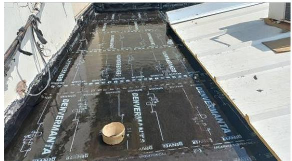
Figura I.8.18C: Teste de estanqueidade (72h), sendo realizado em laje já impermeabilizada sobre o arquivo
