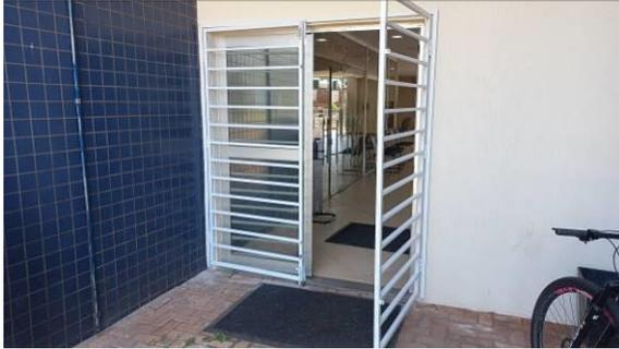
Figura I.5.13C: Gradil metálico de abrir, instalado na porta dupla de acesso ao saguão, pelo lado direito
