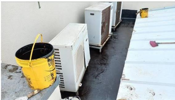
Figura I.8.31C: Aplicação de manta líquida sobre laje na região do restaurante
