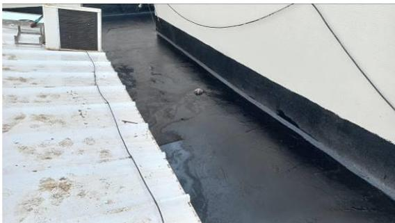
Figura I.8.25C: Aplicação de manta líquida sobre laje na região da 4ª vara
