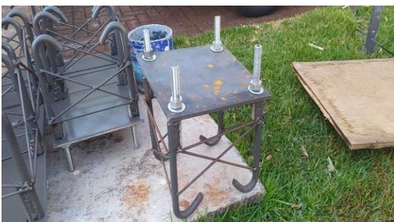
Cobertura metálica da entrada principal - Detalhe dos chumbadores e placas de base, para fixação dos pórticos metálicos nas fundações
