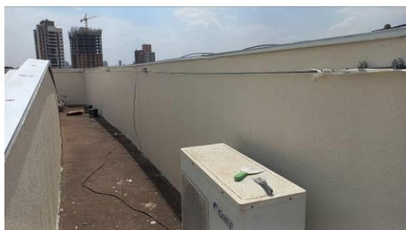
Figura 1.4.6C: Aplicação de textura acrílica em faces internas das platibandas – Região sobre a área osso
