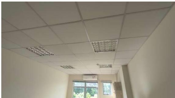
Figura I.6.3E: Iluminação interna modelo embutir LED 4x10W – ambientes com forro modular SEA e STI
