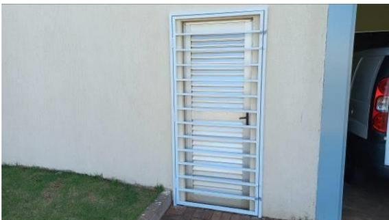
Figura I.5.3C: Gradil metálico de abrir, instalado na porta dos fundos da Setorial
