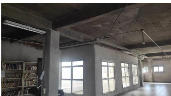
Figura I.6.5E: Iluminação interna modelo sobrepor reaproveitadas da SEA e STI
