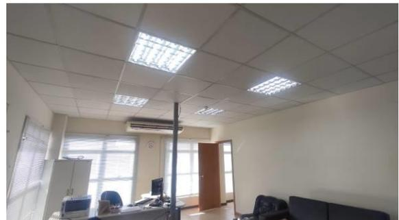
Figura I.6.2E: Iluminação interna modelo embutir LED 4x10W – ambientes com forro modular SEA e STI
