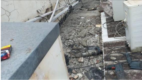
Figura 1.8.5C: Início da demolição da proteção mecânica e retirada da manta deteriorada na região sobre o Cejusc
