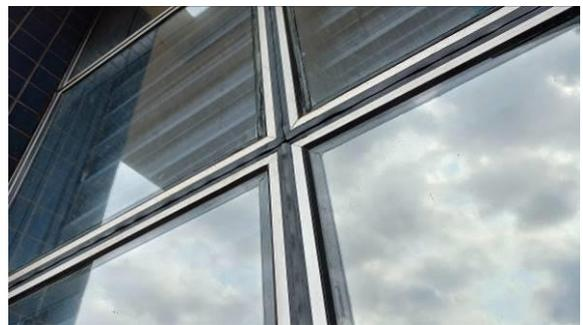
Figura I.3.8C: Detalhe da instalação das gaxetas em EPDM novas, instaladas em peles de vidro
