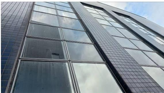
Figura I.3.7C: Substituição das borrachas de vedação (gaxetas) das peles de vidro – Sala de audiência 1 e pré-acordo 1, na 2ª Vara. Arquivo no 1º Pavimento e Restaurante, no 2º Pavimento
