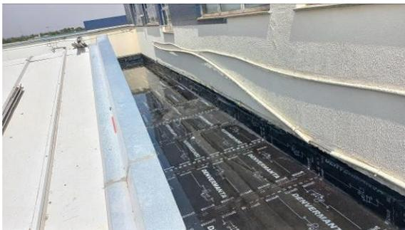
Figura I.8.17C: Teste de estanqueidade (72h), sendo realizado em laje já impermeabilizada sobre o arquivo
