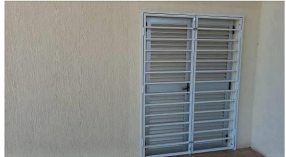
Figura I.5.2C: Gradil metálico de abrir, instalado na porta dupla de acesso ao arquivo
