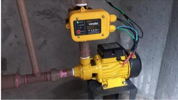
Figura I.6.2C: Detalhe da bomba de reuso com pressostato acoplada
