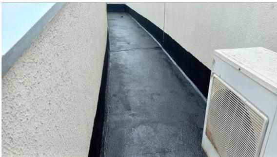
Figura I.8.35C: Aplicação de manta líquida sobre laje na região da sala osso
