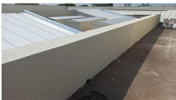
Figura 1.4.3C: Aplicação de textura acrílica em faces internas das platibandas – Região sobre o saguão do Fórum
