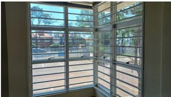
Figura I.5.9C: Gradis metálicos instalados em janela 2x165x260cm, na Direção do Fórum
