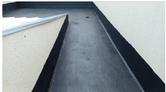
Figura I.8.36C: Aplicação de manta líquida sobre laje na região da sala osso
