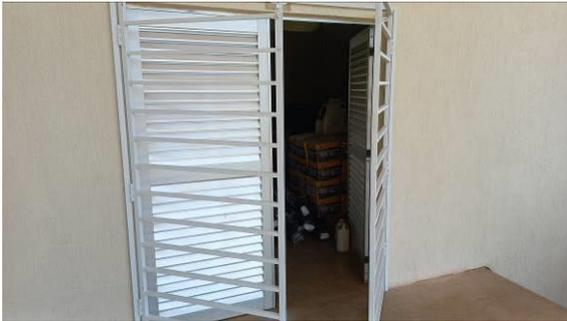
Figura I.5.1C: Gradil metálico de abrir, instalado na porta dupla de acesso à Setorial
