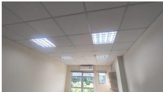
Figura I.6.4E: Iluminação interna modelo embutir LED 4x10W – ambientes com forro modular SEA e STI
