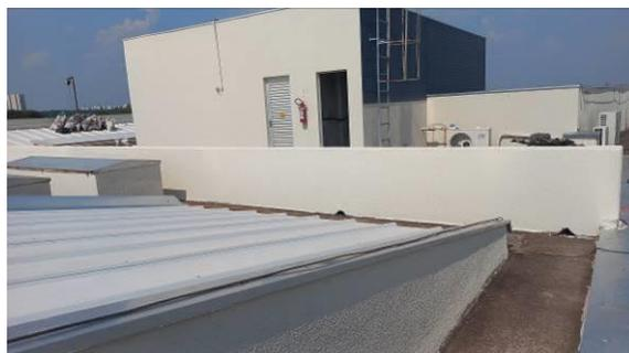
Figura 1.4.2C: Aplicação de textura acrílica em faces internas das platibandas – Região sobre o saguão do Fórum
