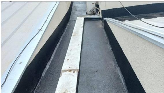
Figura I.8.33C: Aplicação de manta líquida sobre laje na região da junta de dilatação
