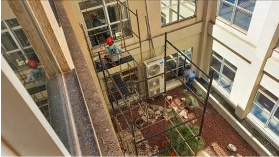
Figura I.1.3C: Andaime montado no fosso de luz do bloco da direita
