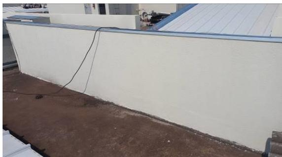
Figura 1.4.1C: Aplicação de textura acrílica em faces internas das platibandas – Região sobre a área osso
