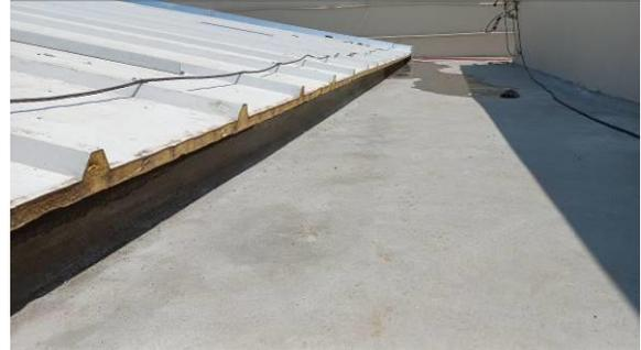
Figura I.8.22C: Detalhe do acabamento da proteção mecânica
