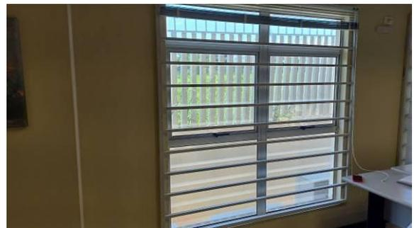
Figura I.5.4C: Gradil metálico instalado em janela 180x190cm, na segunda vara
