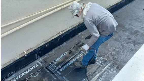
Figura I.8.13C: Operário realizando a aplicação da manta asfáltica em área de laje sobre a sala osso
