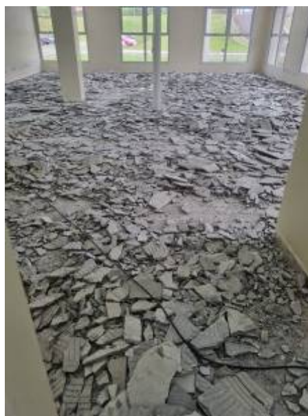
Figura 06 – demolição de contra-piso
