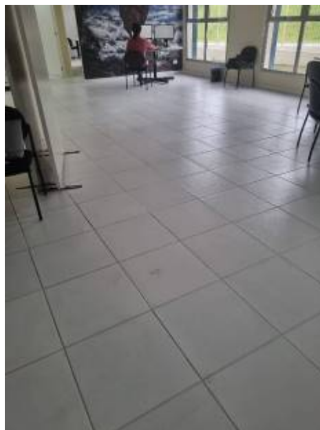
Figura 18 – revestimento cerâmico executado
