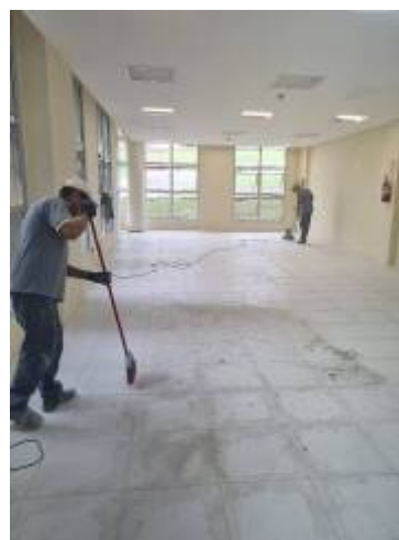
Figura 16 – revestimento cerâmico executado
