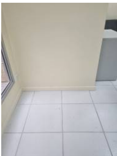
Figura 23 – rodapé reinstalado
