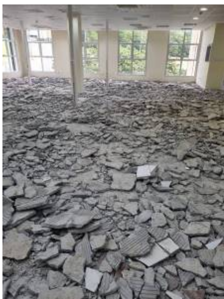
Figura 05 – demolição de contra-piso
