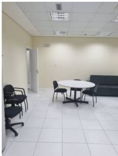
Figura 17 – revestimento cerâmico executado
