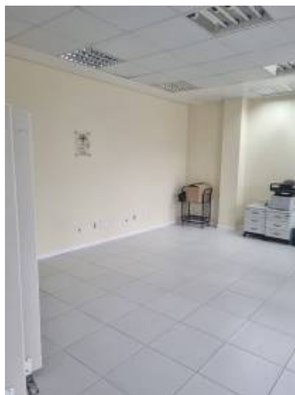
Figura 22 – revestimento cerâmico executado
