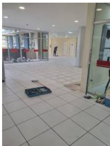
Figura 15 – revestimento cerâmico executado
