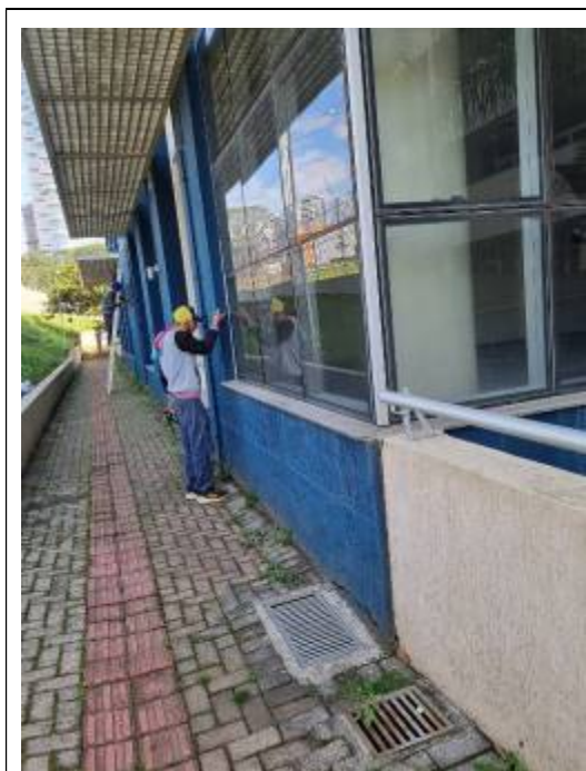
Figura 03 – aplicação de selante
