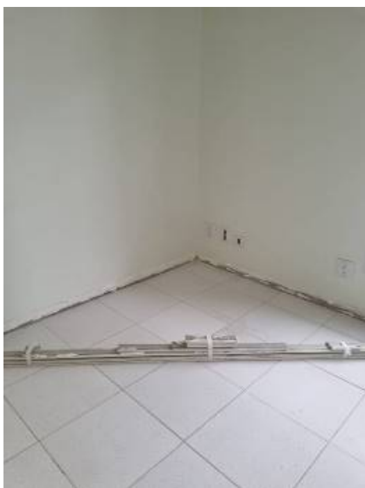
Figura 07 – remoção de rodapés
