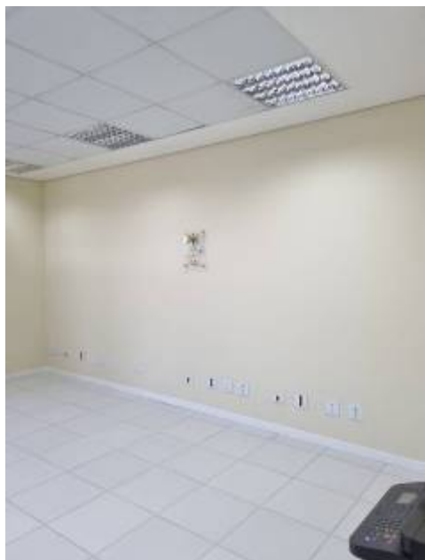
Figura 13 – revestimento cerâmico executado
