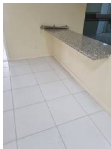
Figura 24 – rodapé reinstalado
