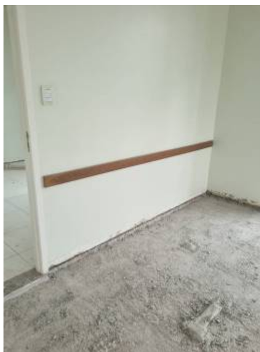
Figura 08 – remoção de rodapés
