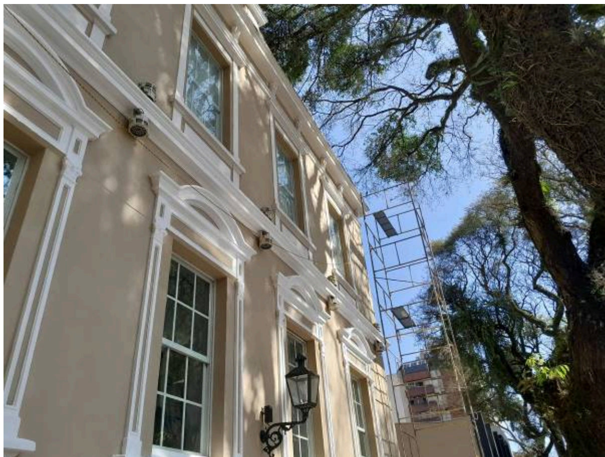
Figura 09 – Andaime tubular tipo torre
