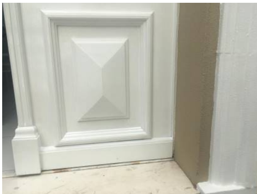
Figura 07 – Pintura esquadrias de madeira
