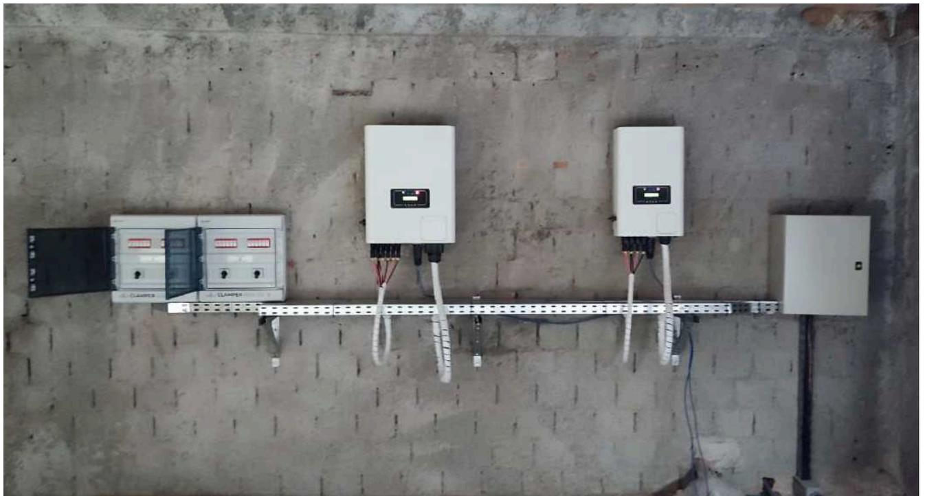
Figuras 02 – Proteções e inversores instalados – Pinhais
