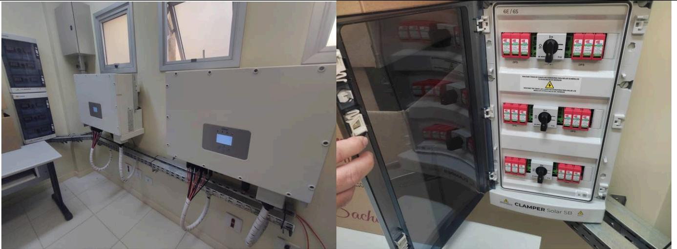
Figuras 04 – Proteções e inversores instalados – Ponta Grossa
