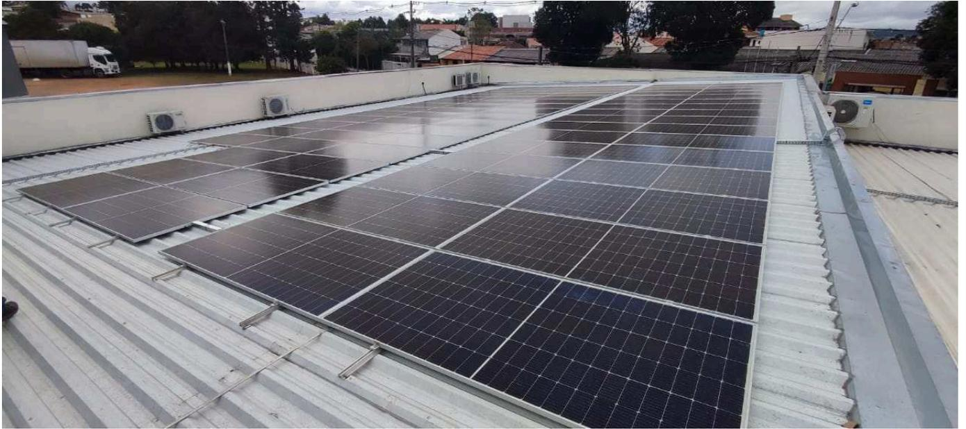
Figuras 01 – Cobertura com placas instaladas - Pinhais
