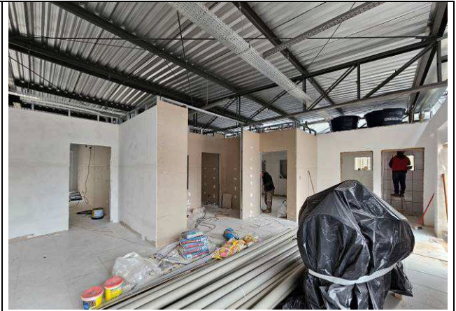
Figura 10: Paredes de gesso acartonado.
