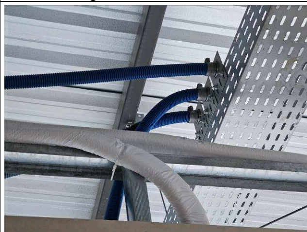
Figura 51: Eletrodutos corrugados 1".
