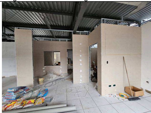
Figura 05: Paredes de gesso acartonado.
