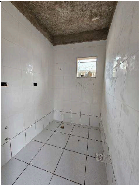
Figura 53: Azulejos – banheiros públicos.
