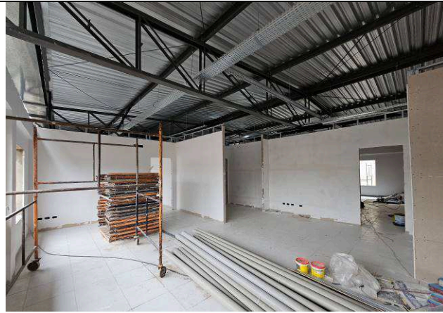
Figura 09: Paredes de gesso acartonado.
