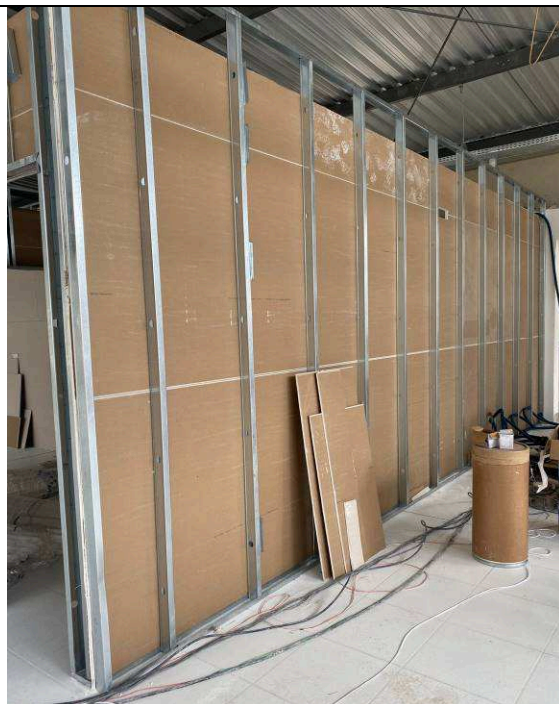
Figura 02: Montagem das chapas de gesso acartonado.
