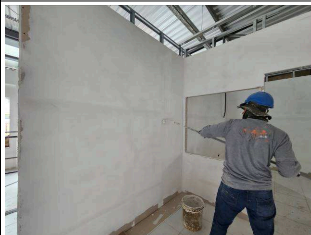
Figura 44: Pintura interna - emassamento.
