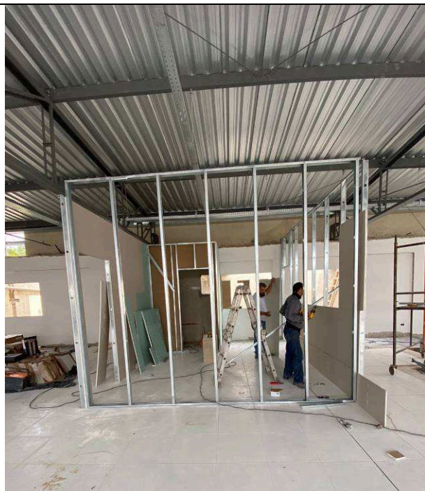
Figura 01: Montagem dos perfis metálicos das paredes de gesso acartonado.
