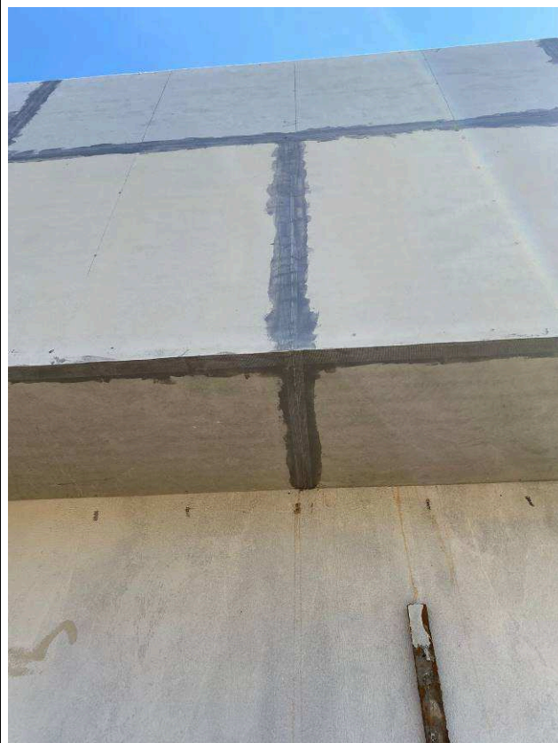
Figura 18: Juntas das placas cimentícias fitadas e emassadas.
