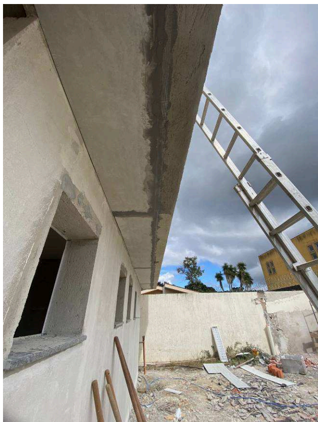
Figura 17: Forro do beiral com placas cimentícias.
