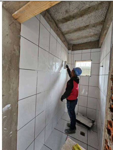
Figura 54: Azulejos – banheiros públicos.
