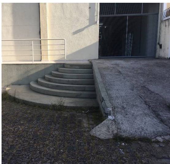
Piso da rampa e escada a ser recuperado
