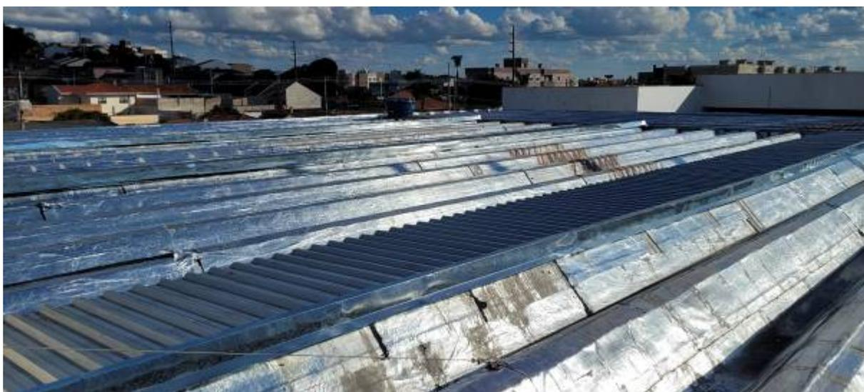
Figura 01 – Vista geral da impermeabilização, execução de nova cobertura e rufos, **incluindo complemento referente ao 1º aditivo**
