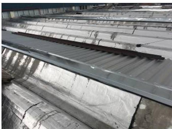
Figura 02 – Rufos instalados na cobertura em telha trapezoidal galvalume e estrutura metálica de apoio
