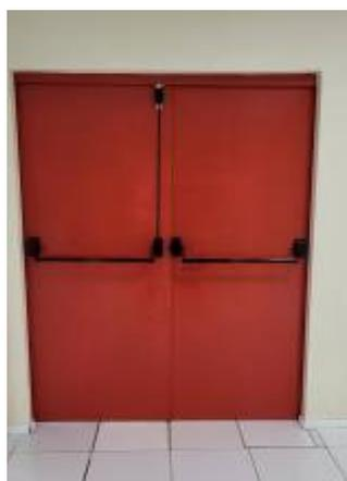
Figura 08 – Barras anti-pânico instaladas nas portas corta fogo duplas
