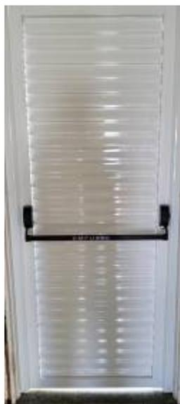
Figura 07 – Barras anti-pânico instaladas nas portas de alumínio
