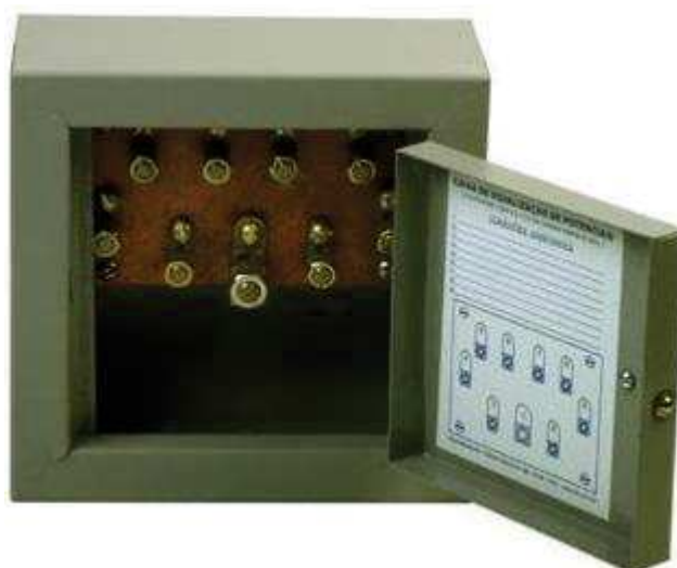
Figura 9 – Caixa de equipotencialização (BEP)
