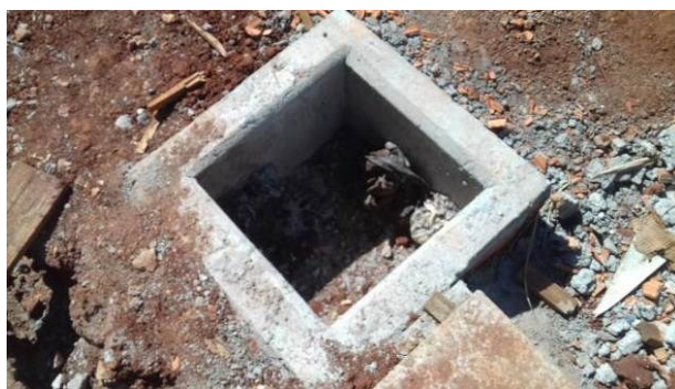
Caixa de inspeção - esgoto
