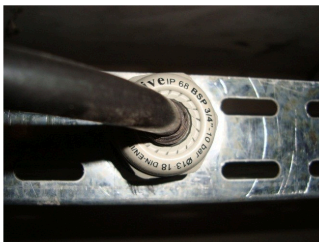
Figura 8: Derivação para luminárias (prensa-cabo)
