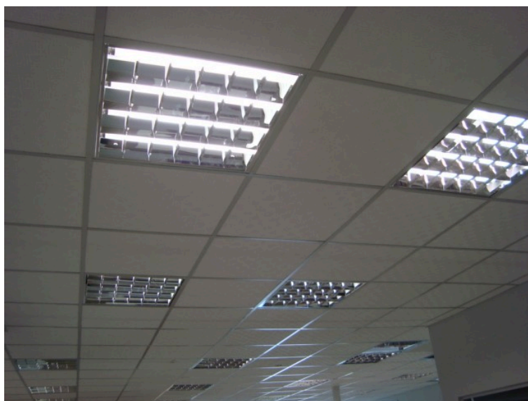
Figura 9: Luminárias embutidas 4x10 W (LED)
