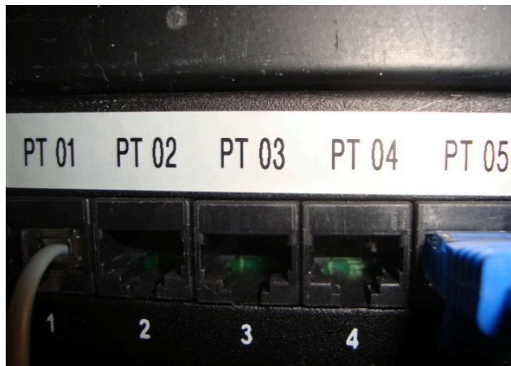
Figura 13: Patch panel com identificação de pontos
