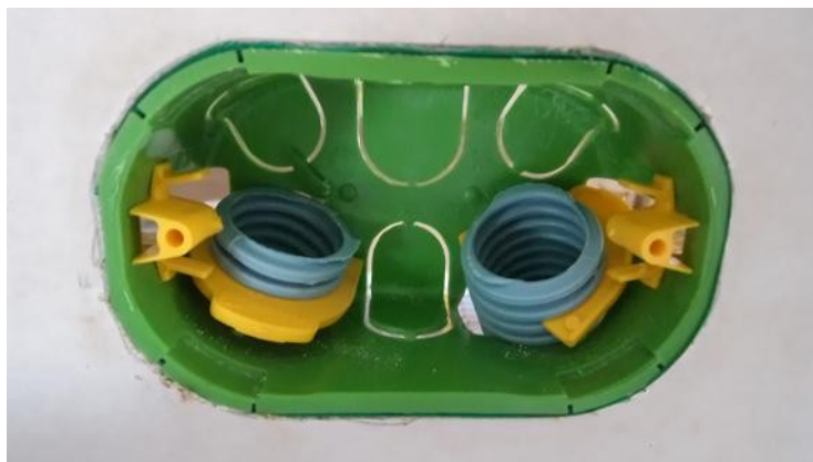
Figura 1: Caixa de ligação em drywall
