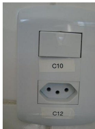
Figura 4: Identificação de condutores, tomadas e interruptores
