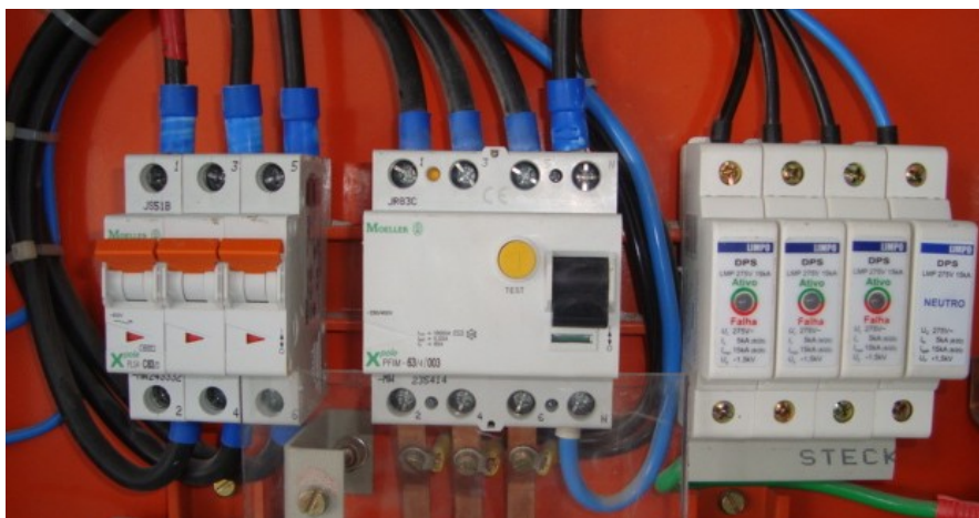
Figura 3: Disjuntor, dispositivo DR e DPS em quadro
