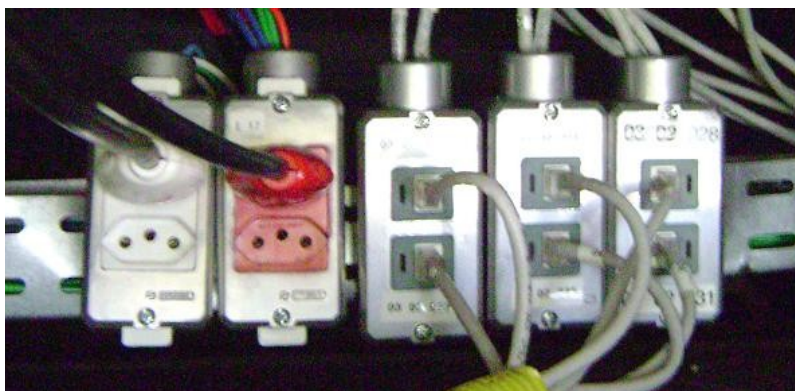
Figura 6: Padrão genérico (tomadas sobre o forro)
