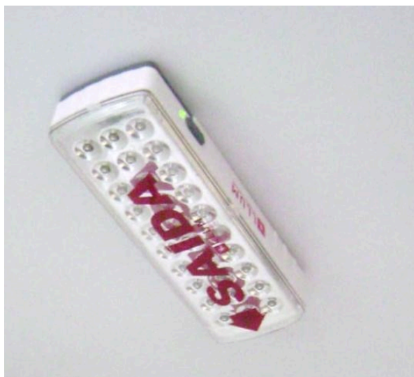
Figura 12: Luminárias de emergência
