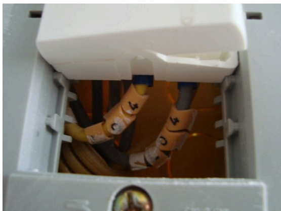
Figura 4: Identificação de condutores, tomadas e interruptores
