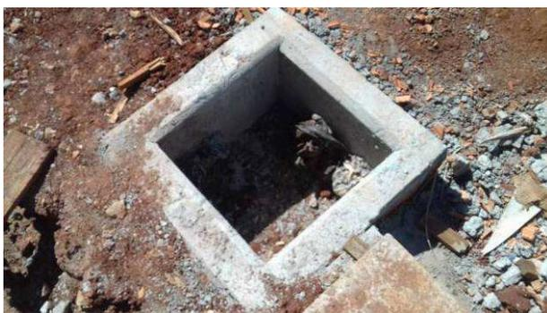
Caixa de inspeção - esgoto
