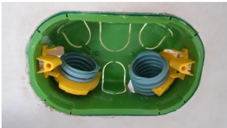
Figura 1: Caixa de ligação em drywall
