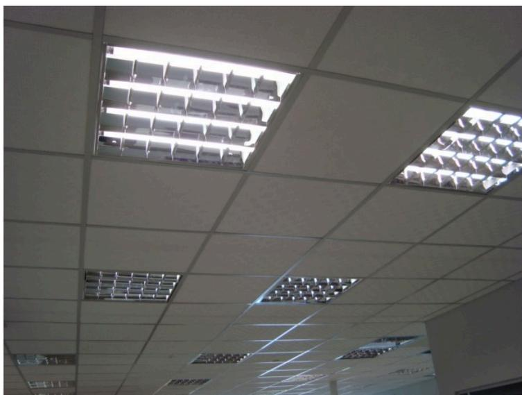
**Figura 9: Luminárias embutidas 4x10 W (LED)**
