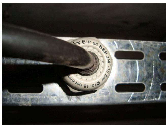
**Figura 8: Derivação para luminárias (prensa-cabo)**
