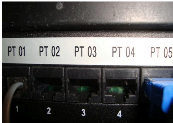
**Figura 13: Patch panel com identificação de pontos**
