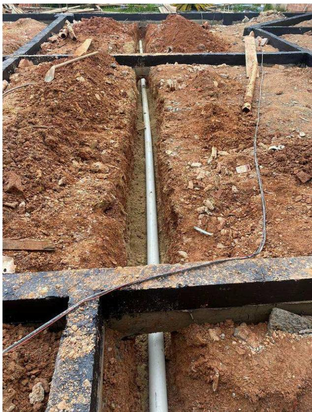
Figura 15: Rede de coleta de esgoto.
