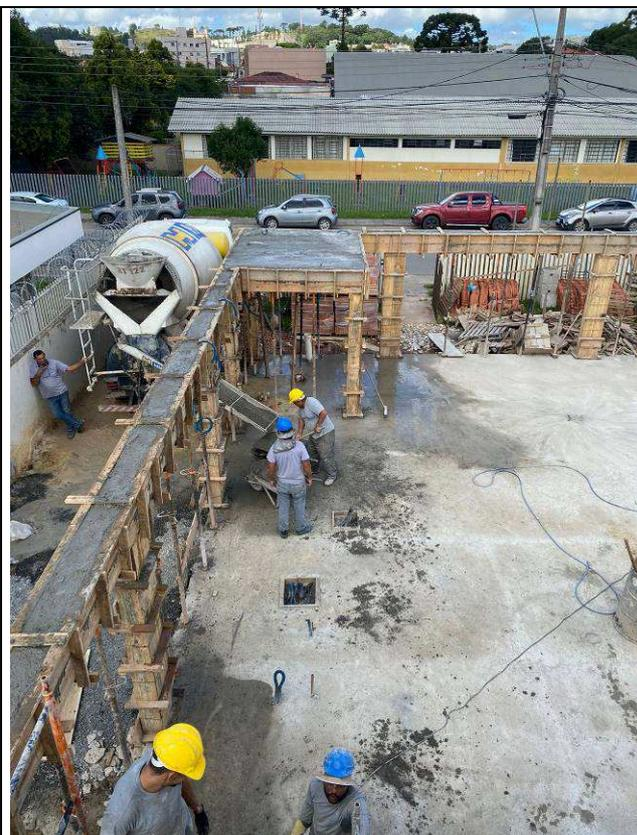
Figura 37: Concretagem vigas e lajes.
