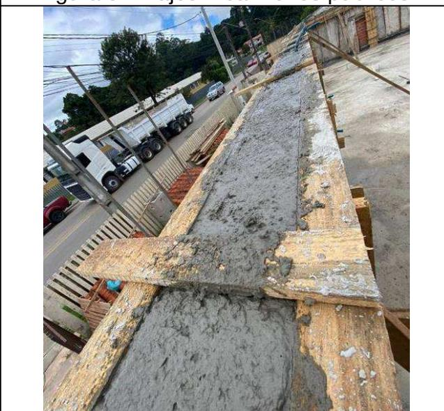
Figura 36: Concretagem vigas e lajes.
