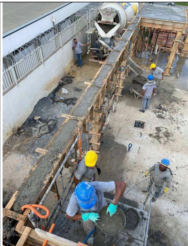
Figura 38: Concretagem vigas e lajes.
