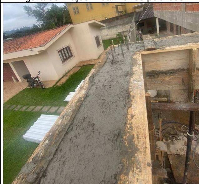
Figura 35: Concretagem vigas e lajes.
