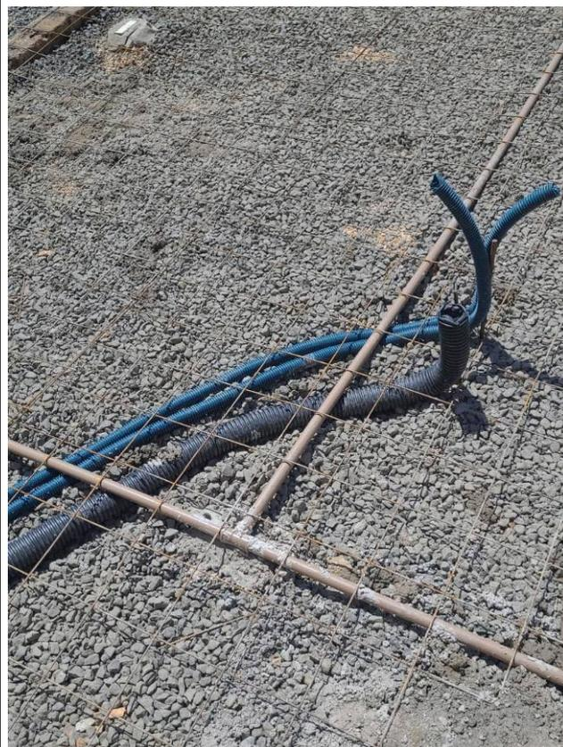
Figura 16: Tubulações da rede de drenos dos equipamentos de ar condicionado.
