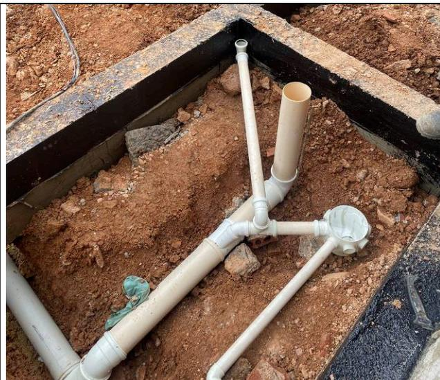
Figura 46: Pontos de esgoto – prédio frontal.
