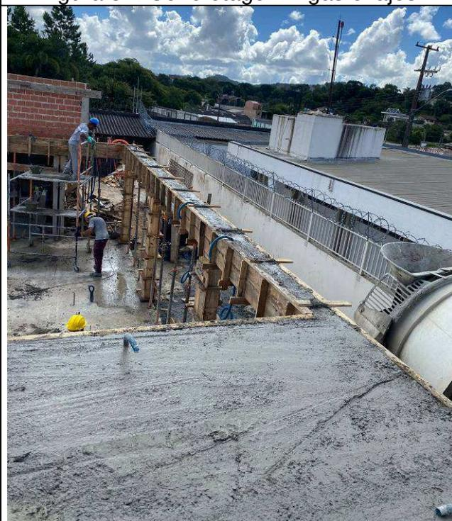
Figura 39: Concretagem vigas e lajes.
