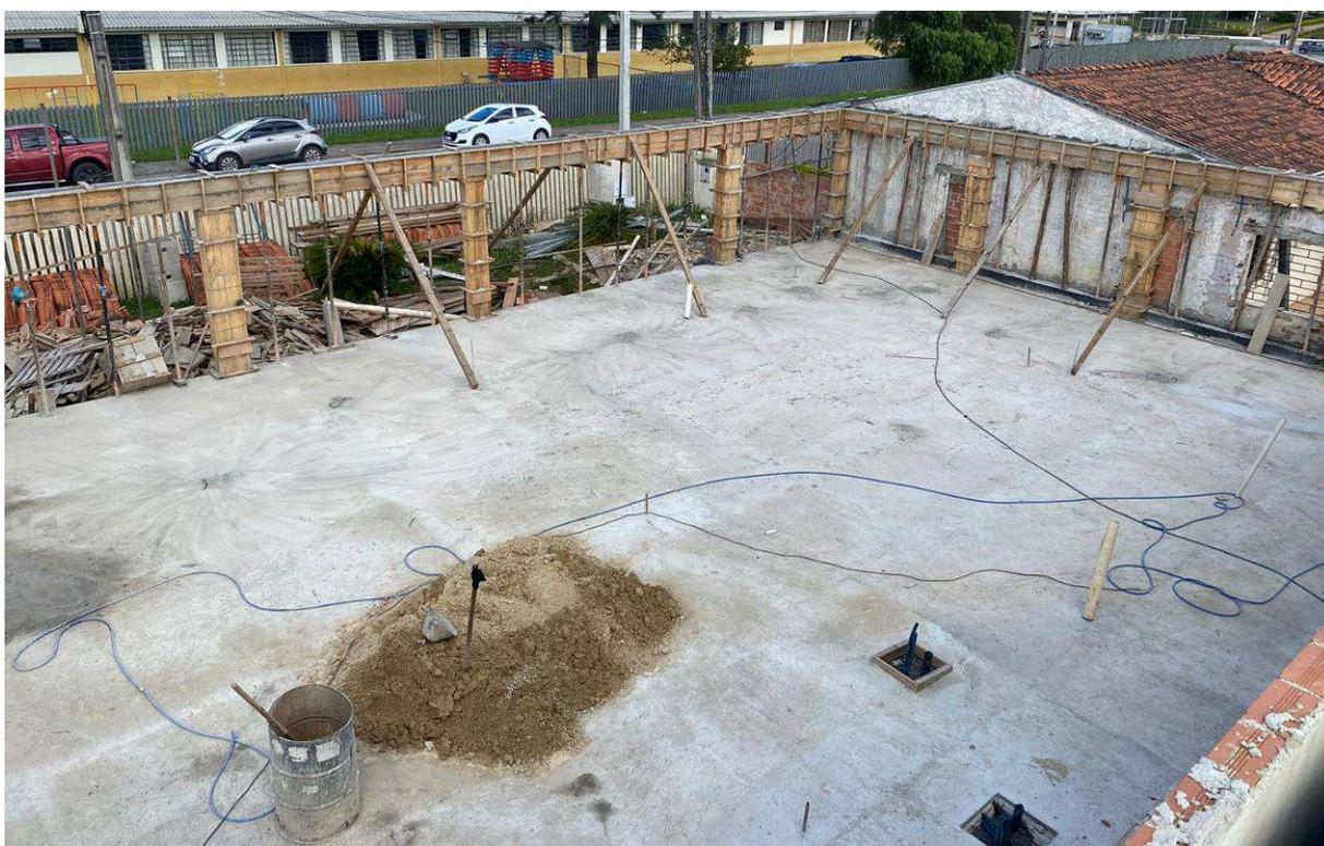
Figura 1 – Contrapiso e Estrutura de Concreto Armado – edifício frontal.
