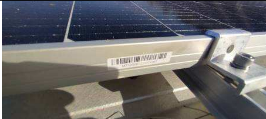
Figuras 02 – Cobertura com placas instaladas
