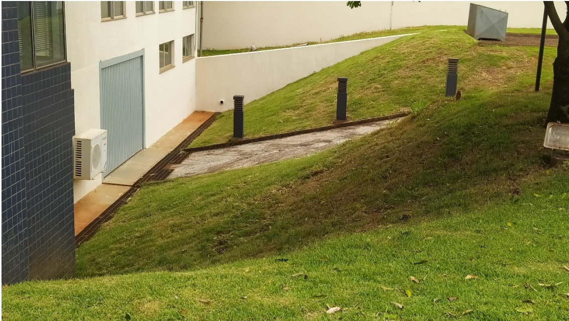
Elaboração de faixas de retenção, em forma de grama preta, nas partes baixas dos taludes, nos acessos aos estacionamentos do subsolo
