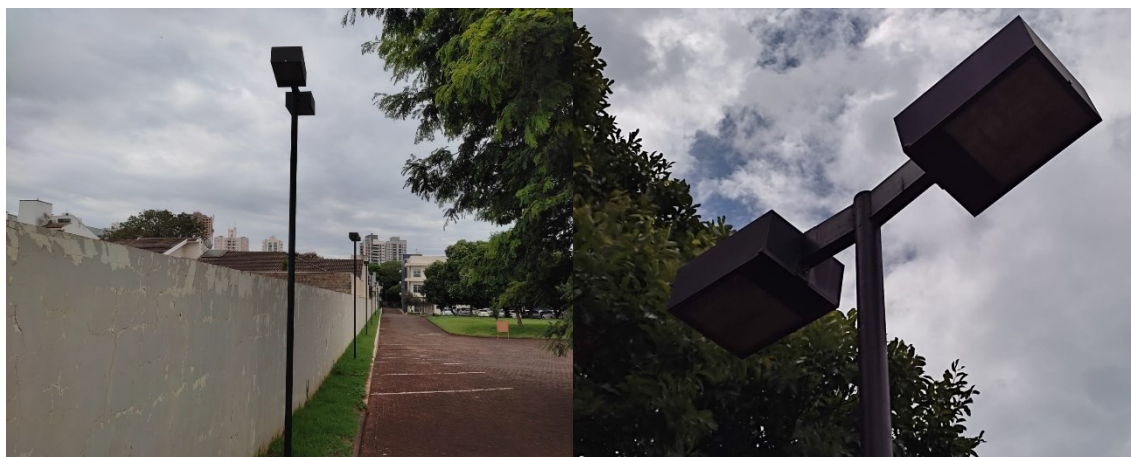
Figuras 9E a 10E – Postes externos para lâmpadas E27 30W
