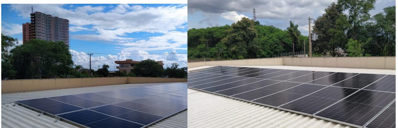
Figuras 05 – Cobertura com placas instaladas – Foz do Iguaçu
