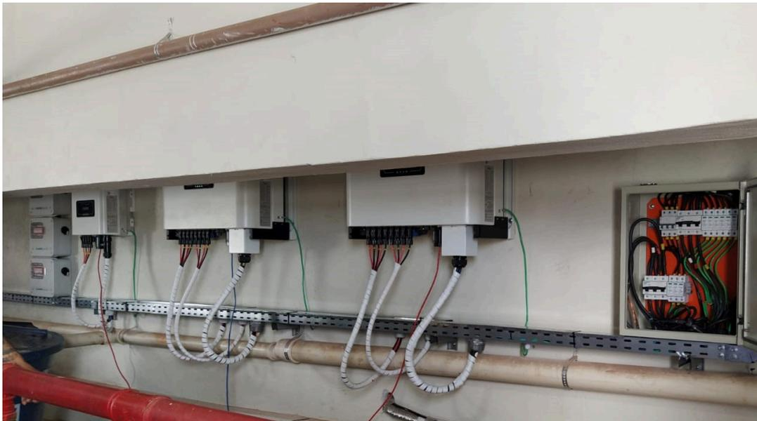
Figura 06 – Inversores e ligação elétrica – Foz do Iguaçu
