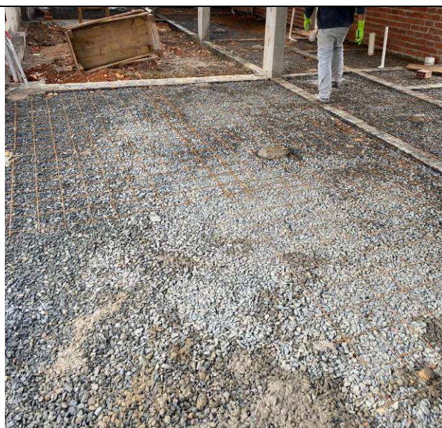
Figura 26: Armação - contrapiso.
