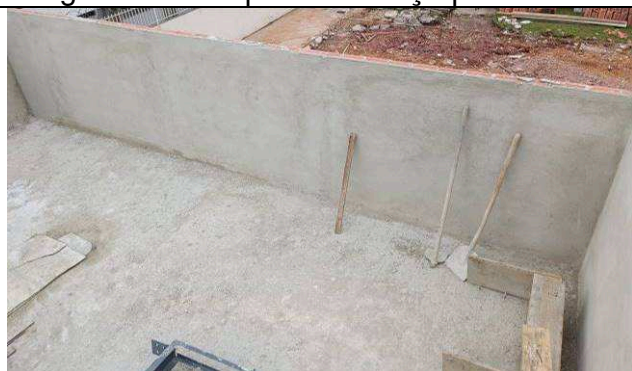
Figura 22: Chapisco/emboço platibanda.
