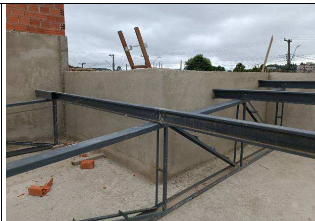
Figura 20: Chapisco/emboço platibanda.
