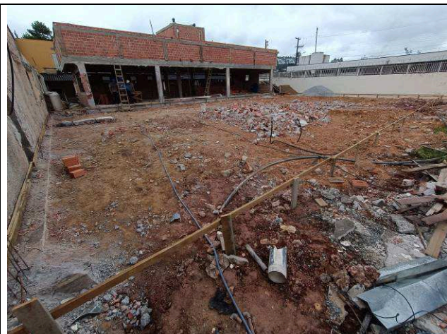
Figura 03: Demolição do prédio existente.
