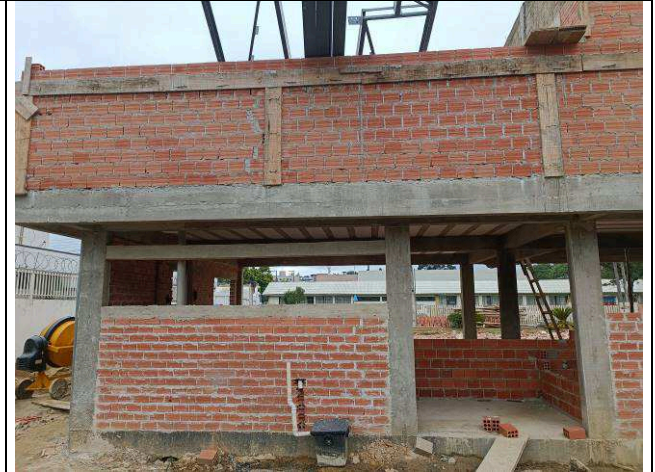
Figura 10: Alvenarias externas.
