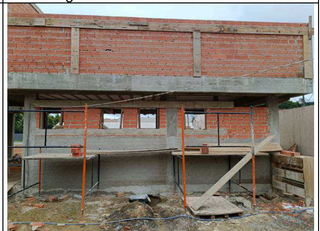
Figura 12: Alvenarias externas.
