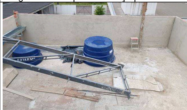
Figura 21: Chapisco/emboço platibanda.
