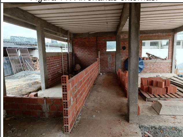
Figura 13: Alvenarias externas.
