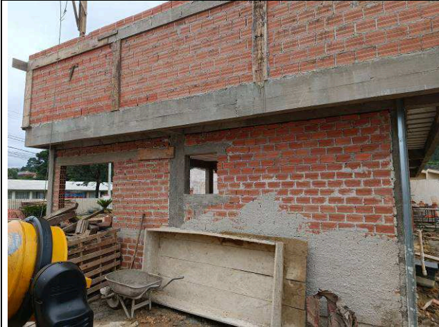
Figura 09: Alvenarias externas.
