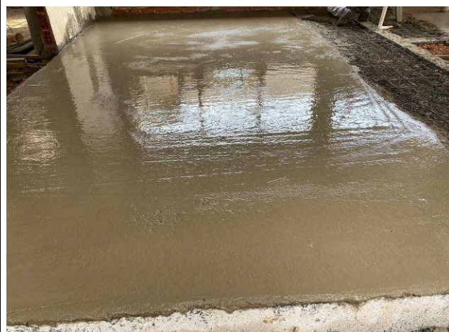
Figura 28: Concretagem contrapiso.
