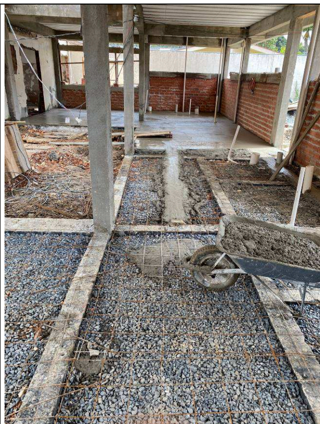
Figura 27: Concretagem contrapiso.
