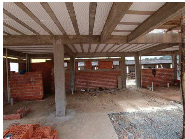
Figura 29: Contrapiso concretado.
