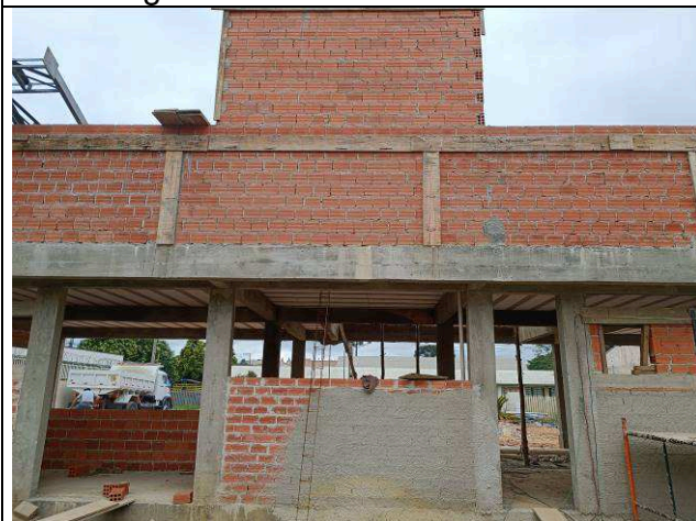
Figura 11: Alvenarias externas.
