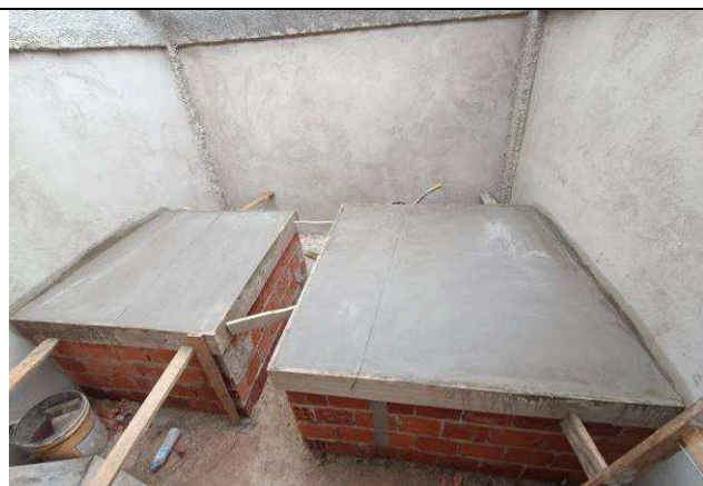
Figura 22: Chapisco/emboço platibanda.
