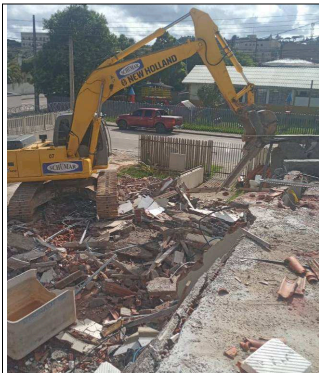
Figura 01: Demolição do prédio existente.
