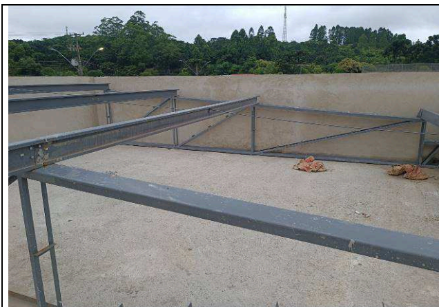
Figura 19: Chapisco/emboço platibanda.
