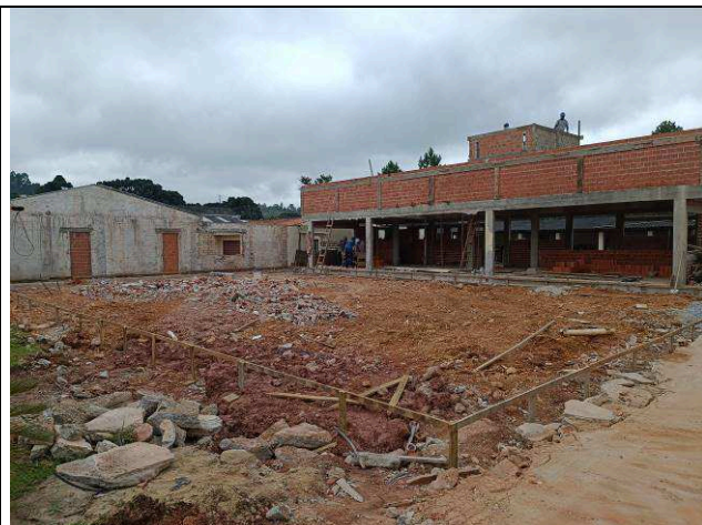
Figura 04: Demolição do prédio existente.
