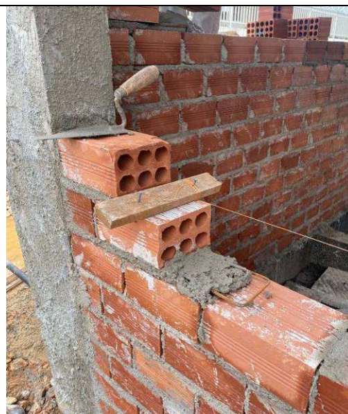
Figura 02: Alvenarias externas – detalhe de amarração com ferro-cabelo.
