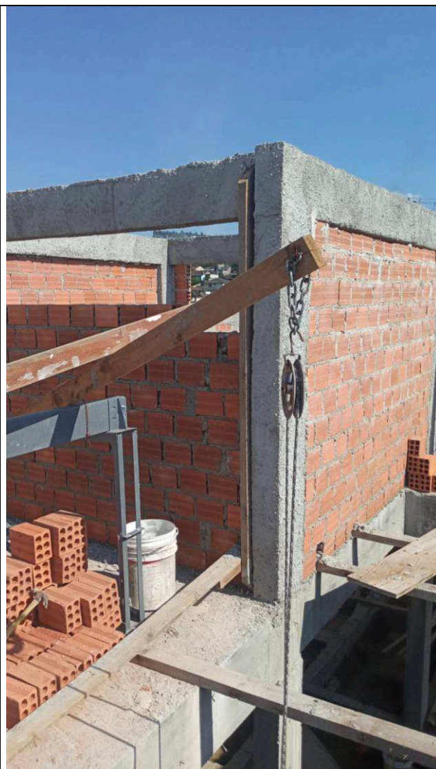
Figura 11: Alvenarias do volume dos reservatórios de água.
