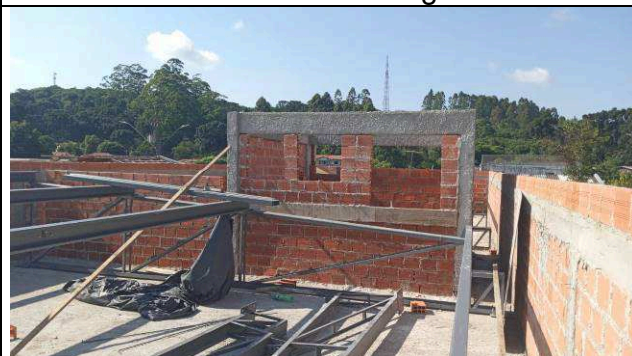
Figura 14: Estrutura metálica de cobertura - ampliação.
