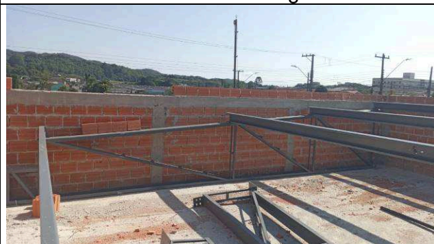
Figura 13: Estrutura metálica de cobertura - ampliação.
