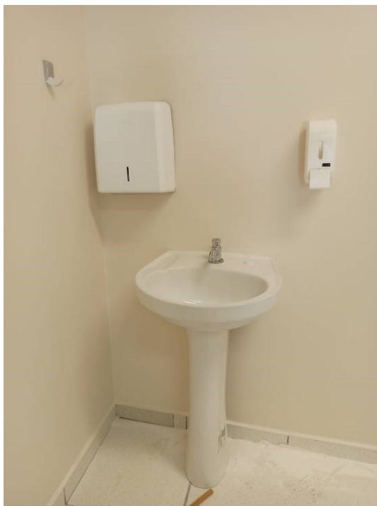
ITEM II.4. Fornecimento e instalação de acessórios para lavatório.
