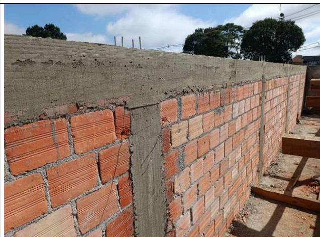
Figura 106: Pilaretes, cinta e parede de alvenaria da cobertura.
