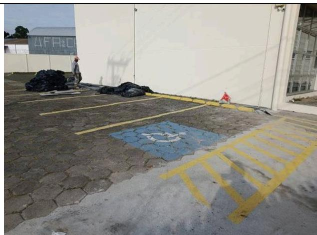
Figura 55: Demarcação das vagas de estacionamento.
