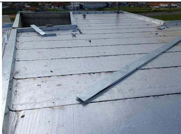
Figura 109: Impermeabilização com manta asfáltica – cobertura superior.
