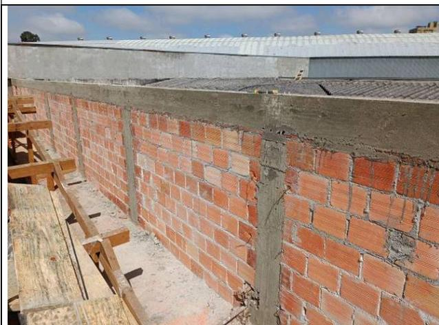
Figura 105: Pilaretes, cinta e parede de alvenaria da cobertura.
