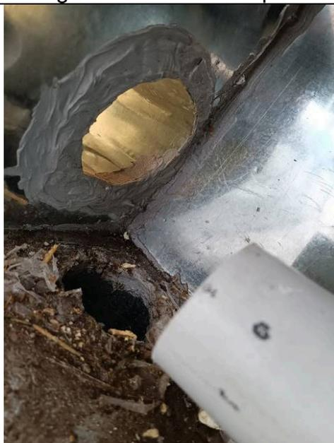
Figura 31: Saída da calha para nova prumada.
