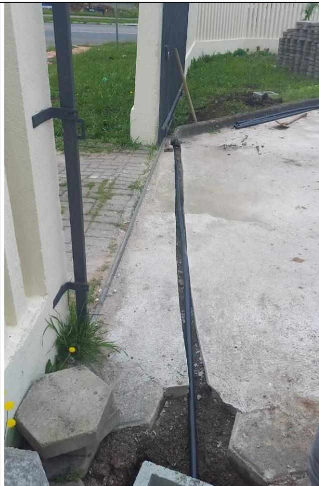
Figura 92: Infraestrutura elétrica – refletores externos.
