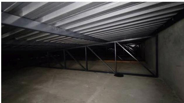
Figura 09: Estrutura metálica de cobertura.
