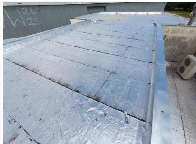
Figura 108: Impermeabilização com manta asfáltica – cobertura superior.
