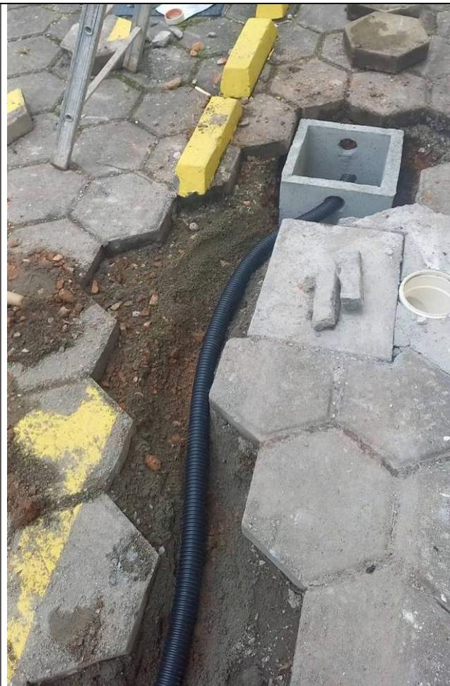
Figura 91: Infraestrutura elétrica – refletores externos.
