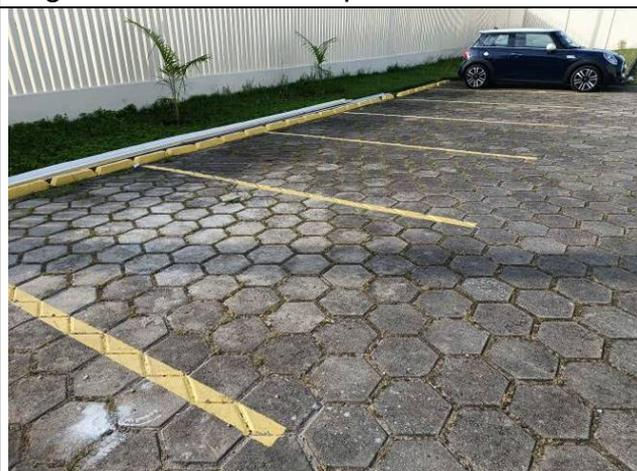
Figura 54: Demarcação das vagas de estacionamento.
