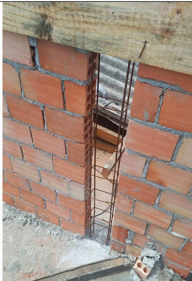
Figura 104: Pilaretes, cinta e parede de alvenaria da cobertura.
