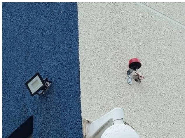
Figura 99: Refletores da fachada e relé fotoelétrico.
