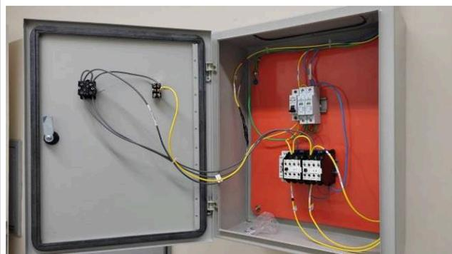
Figura 102: Quadro de iluminação – componentes internos.
