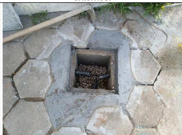
Figura 94: Infraestrutura elétrica – refletores externos.
