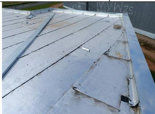
Figura 110: Impermeabilização com manta asfáltica – cobertura superior.
