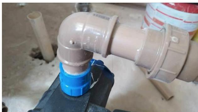
Figura 22C: Detalhe de uma das uniões roscáveis instaladas junto à bomba
