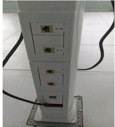
Figura 08E: Totens Dutotec e caixas de piso
