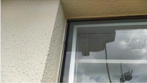
Figura 23C: Detalhe da vedação do perímetro externo das janelas do bloco central
