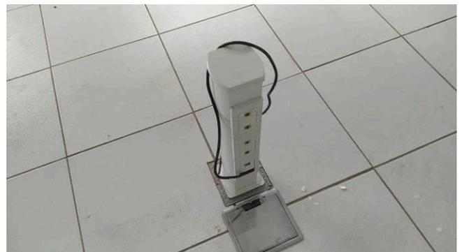
Figura 10E: Totens Dutotec e caixas de piso
