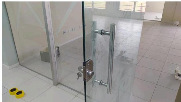
Figura 43C: Instalação de duas portas de vidro tamanho 80x210cm, no acesso principal ao Cejusc
