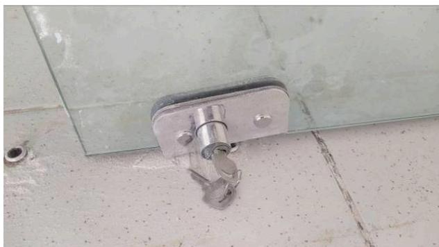
Figura 45C: Detalhe de fechadura de piso, instalada nas portas de vidro do Cejusc
