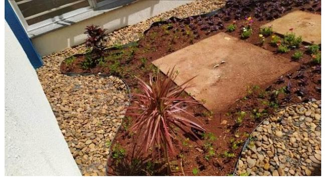
Figura 37C: plantio de grama Amendoim, lançamento de seixo rolado e plantio de arbustos, no bloco direito
