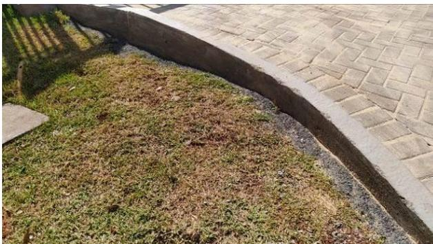
Figura 57C: Detalhe da viga de travamento lateral
