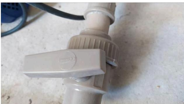
Figura 21C: Detalhe de um dos registros instalados junto à bomba
