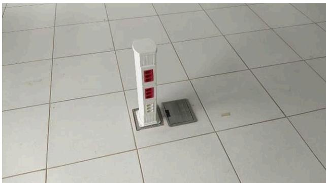
Figura 09E: Totens Dutotec e caixas de piso
