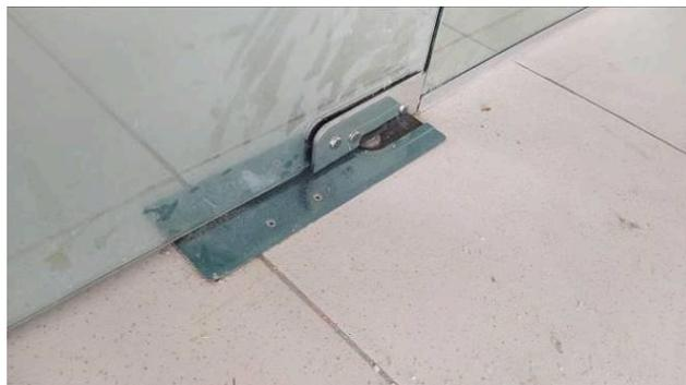
Figura 44C: Detalhe de mola de piso, instalada nas portas de vidro temperado do Cejusc
