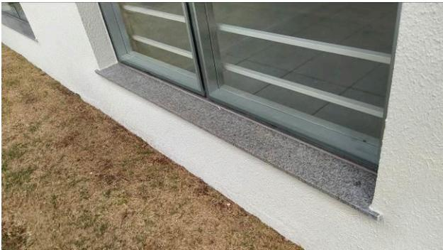
Figura 25C: Detalhe da vedação do perímetro externo das janelas do bloco central
