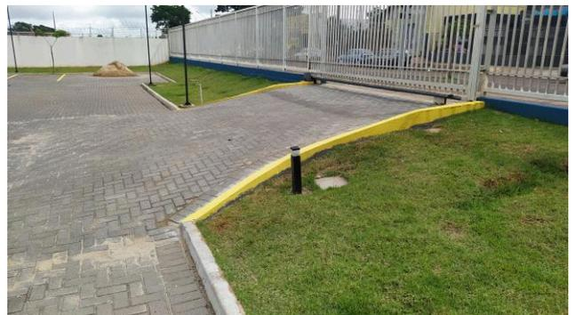
Figura 58C: Detalhe da viga de travamento lateral após pintura
