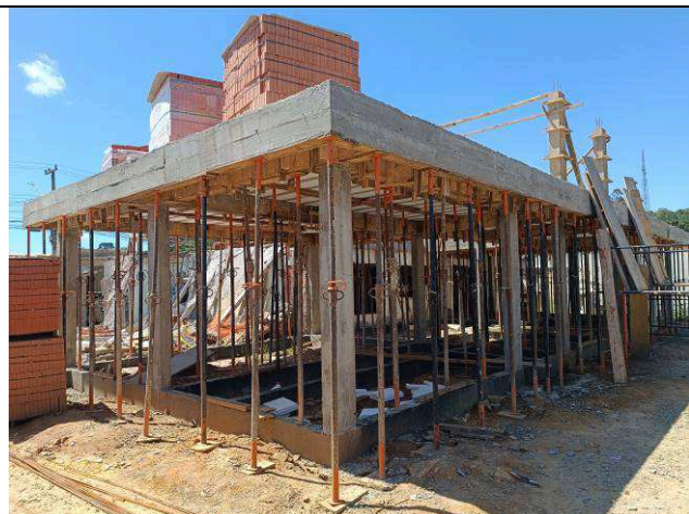
Figura 15: Vigas e laje da cobertura.
