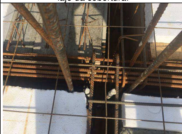
Figura 08: Formas e armações – vigas e laje da cobertura.
