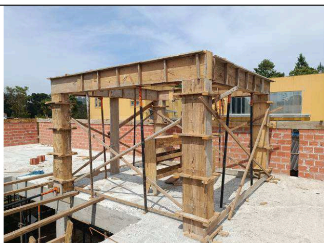
Figura 20: Pilares e vigas do barrilete.
