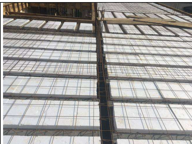
Figura 04: Formas e armações – vigas e laje da cobertura.
