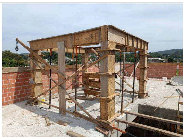
Figura 19: Pilares e vigas do barrilete.
