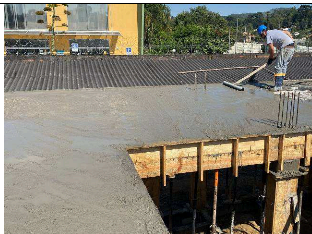
Figura 12: Concretagem – vigas e laje da cobertura.
