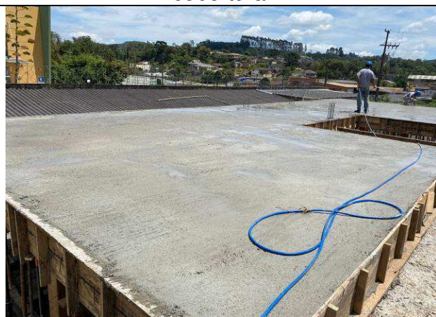
Figura 13: Concretagem – vigas e laje da cobertura.
