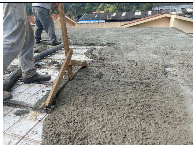
Figura 10: Concretagem – vigas e laje da cobertura.
