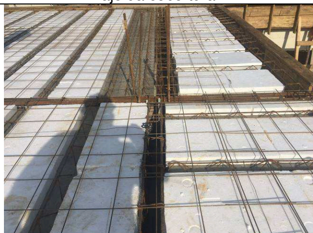
Figura 05: Formas e armações – vigas e laje da cobertura.
