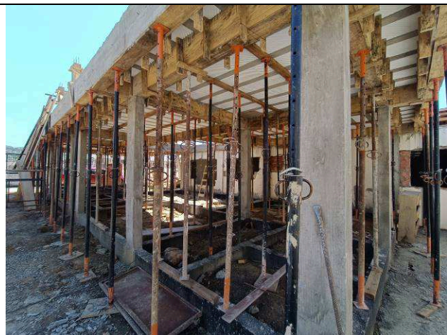
Figura 16: Vigas e laje da cobertura.
