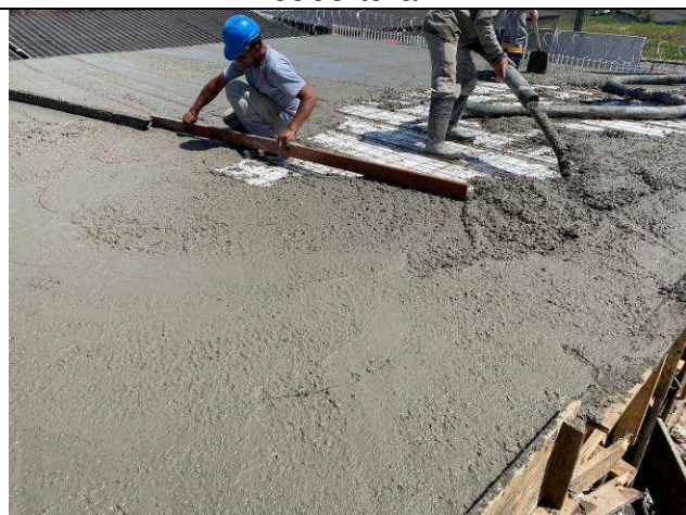
Figura 11: Concretagem – vigas e laje da cobertura.
