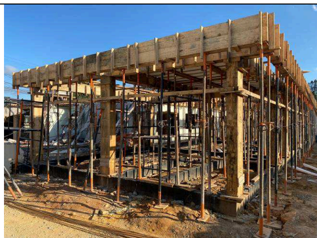
Figura 03: Formas e armações – vigas e laje da cobertura.
