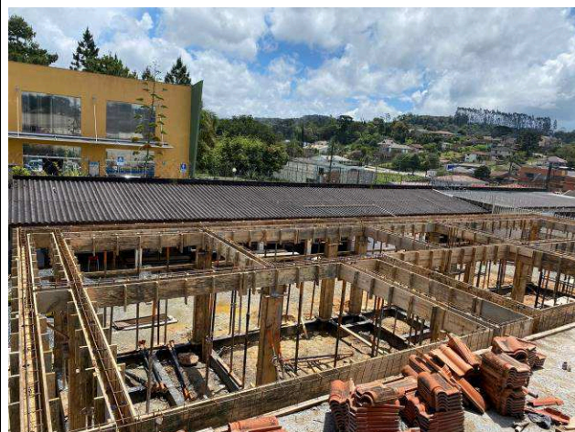
Figura 02: Formas e armações – vigas e laje da cobertura.
