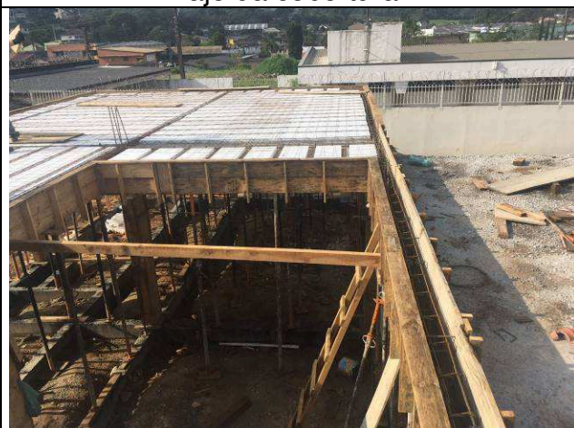
Figura 06: Formas e armações – vigas e laje da cobertura.
