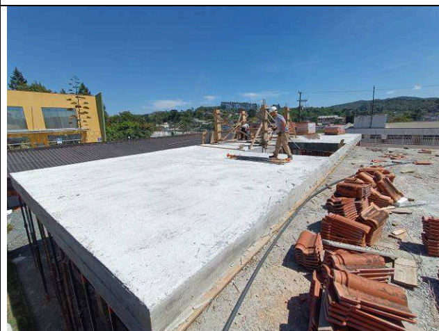
Figura 14: Vigas e laje da cobertura.
