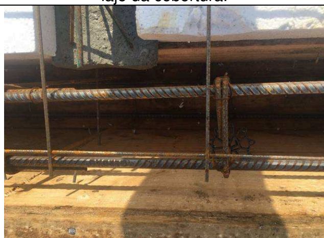
Figura 07: Formas e armações – vigas e laje da cobertura.
