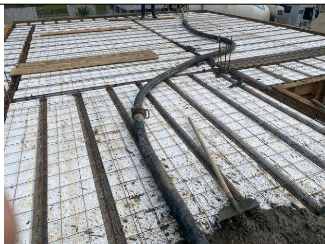
Figura 09: Concretagem – vigas e laje da cobertura.
