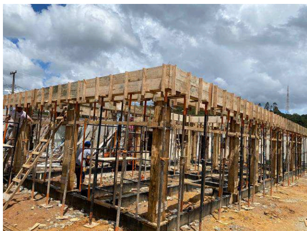
Figura 01: Formas e armações – vigas e laje da cobertura.
