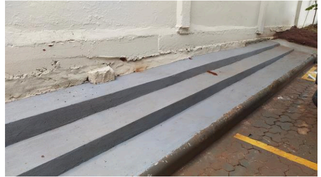
Figura 28C: Execução da contenção escalonada junto à divisa posterior e lateral direita do imóvel
