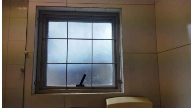
Figura 01C: Aplicação de azulejo no banheiro do juiz titular
