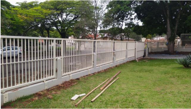
Figura 06C: Gradil metálico instalado na fachada frontal
