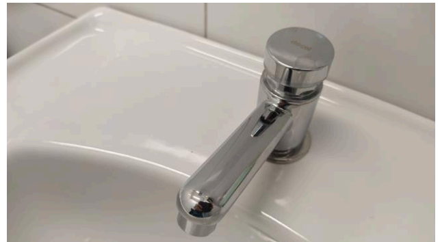
Figura 14C: Torneira instalada no lavatório
