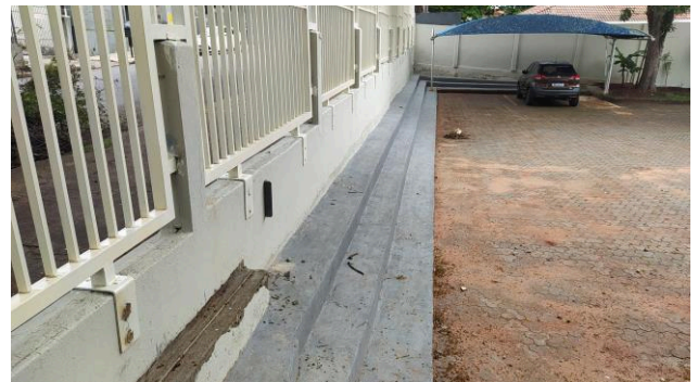
Figura 30C: Execução da contenção escalonada junto à divisa posterior e lateral direita do imóvel
