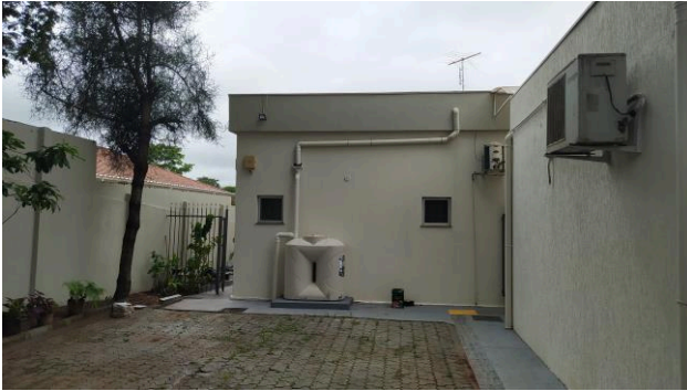
Figura 21C: Pintura da fachada posterior do prédio
