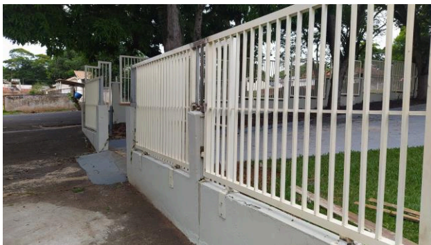
Figura 04C: Gradil metálico instalado na fachada frontal
