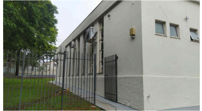
Figura 22C: Pintura da fachada lateral esquerda do prédio
