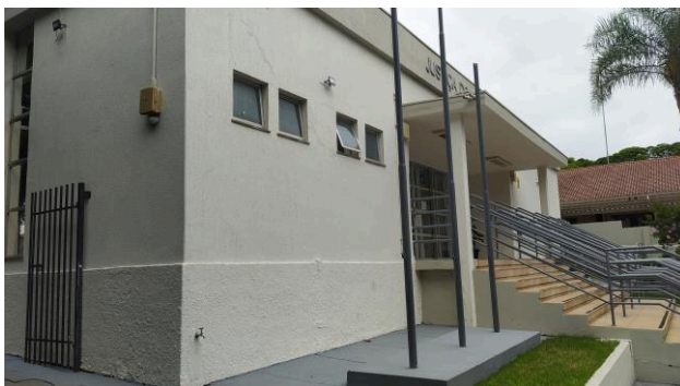
Figura 19C: Pintura da fachada frontal do prédio
