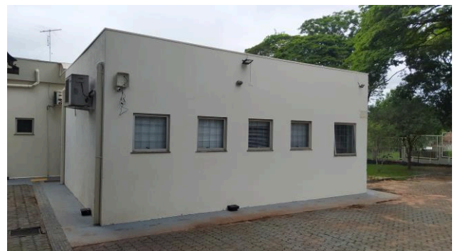
Figura 20C: Pintura da fachada posterior do arquivo
