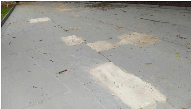
Figura 02C: Reparos no piso cimentado do estacionamento público
