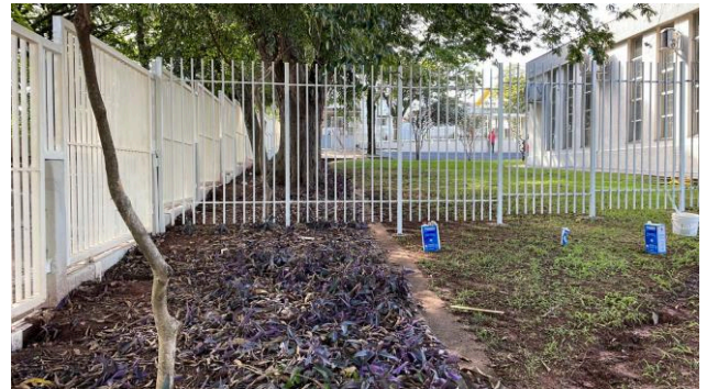
Figura 26C: Pintura do gradil existente
