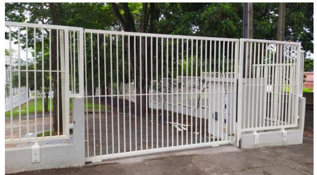
Figura 09C: Portão metálico de correr automatizado. Instalado na entrada do estacionamento privativo
