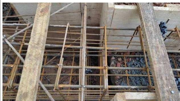
Figura 08: Formas e armações – blocos e vigas baldrames.
