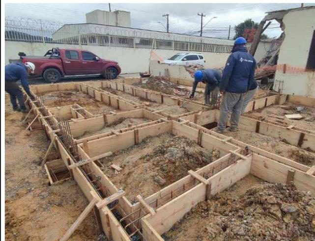
Figura 02: Formas e armações – blocos e vigas baldrames.
