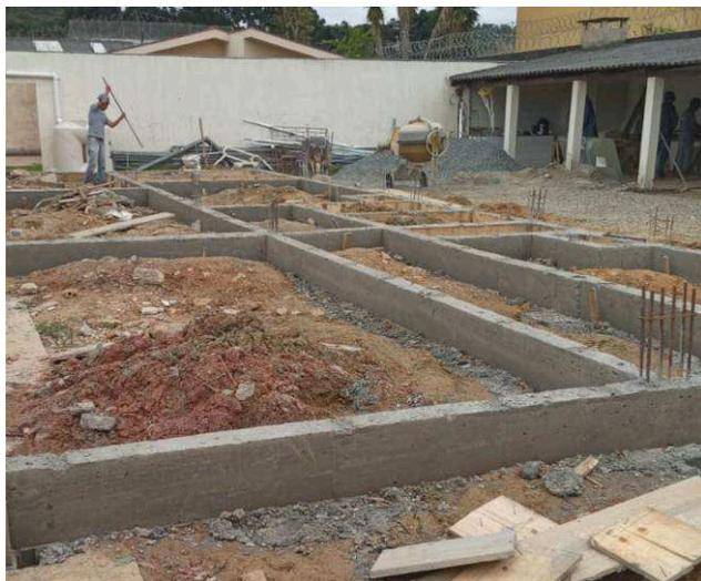
Figura 17: Desforma – blocos e vigas baldrames.
