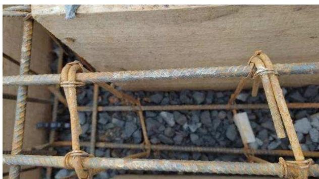
Figura 07: Formas e armações – blocos e vigas baldrames.
