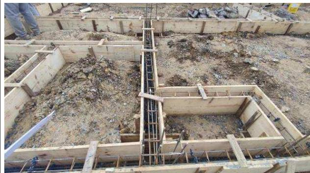
Figura 04: Formas e armações – blocos e vigas baldrames.
