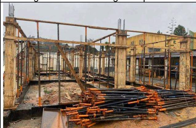
Figura 33: Pilares e vigas baldrame concretados.
