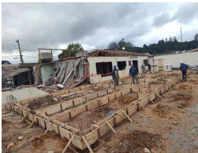
Figura 01: Formas e armações – blocos e vigas baldrames.
