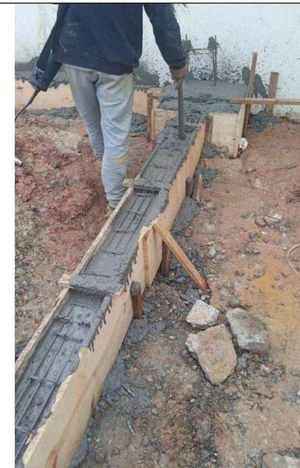
Figura 15: Concretagem – blocos e vigas baldrame.
