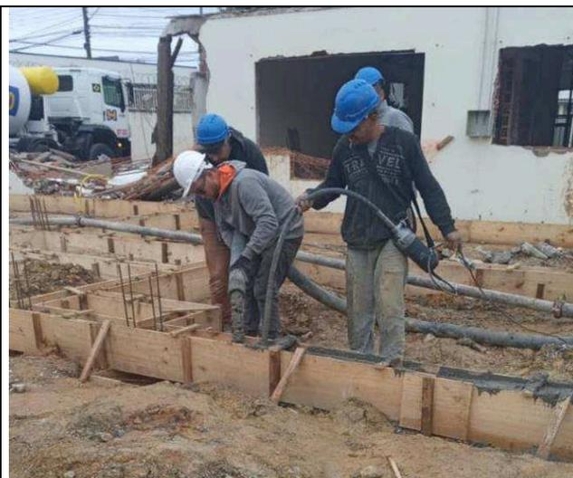
Figura 14: Concretagem – blocos e vigas baldrame.
