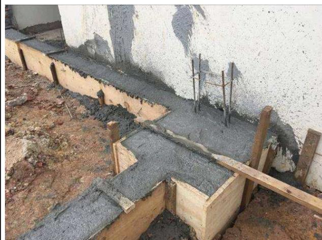
Figura 16: Concretagem – blocos e vigas baldrame.
