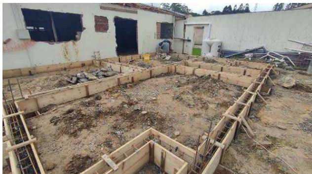
Figura 03: Formas e armações – blocos e vigas baldrames.
