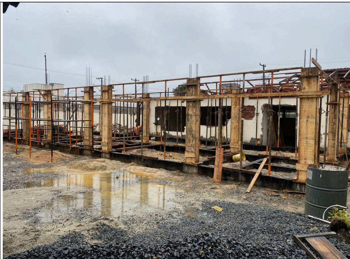
Figura 35: Pilares e vigas baldrames concretados.
