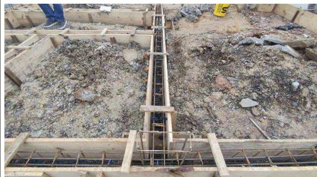
Figura 06: Formas e armações – blocos e vigas baldrames.
