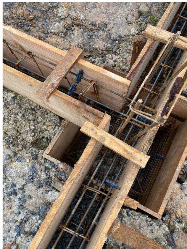
Figura 12: Formas e armações – blocos e vigas baldrames.
