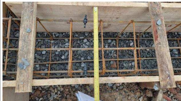
Figura 10: Formas e armações – blocos e vigas baldrames.
