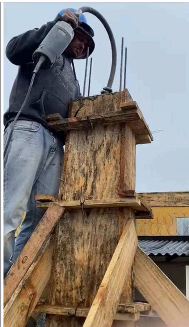
Figura 32: Concretagem – pilares.
