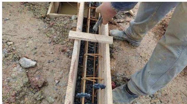
Figura 09: Formas e armações – blocos e vigas baldrames.
