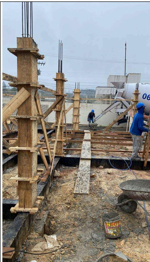
Figura 31: Concretagem – pilares.
