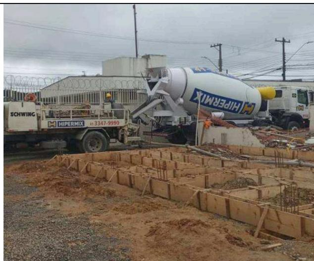
Figura 13: Concretagem – blocos e vigas baldrame.
