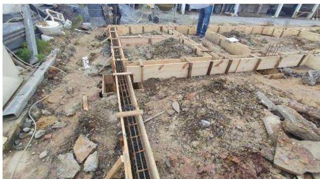
Figura 05: Formas e armações – blocos e vigas baldrames.
