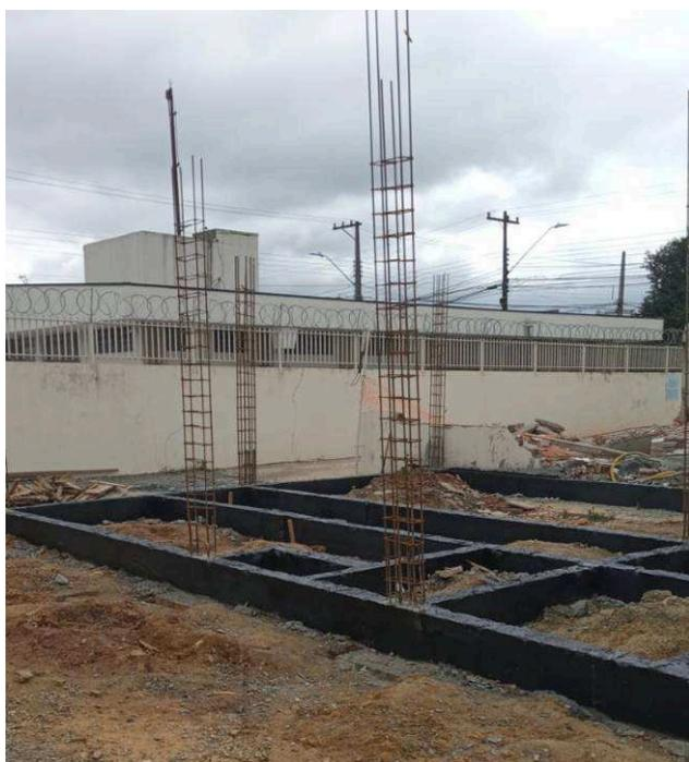
Figura 19: Impermeabilização – blocos e vigas baldrames.
