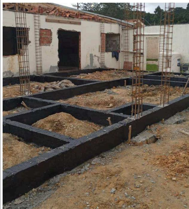
Figura 20: Impermeabilização – blocos e vigas baldrames.
