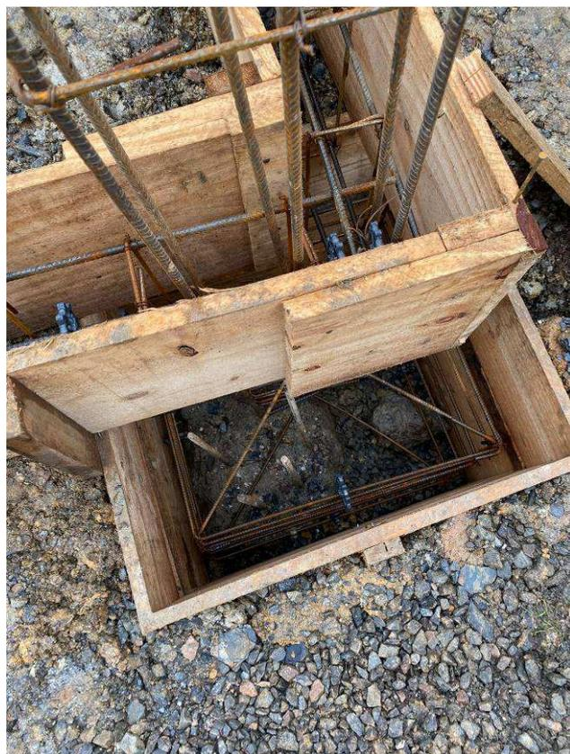
Figura 11: Formas e armações – blocos e vigas baldrames.
