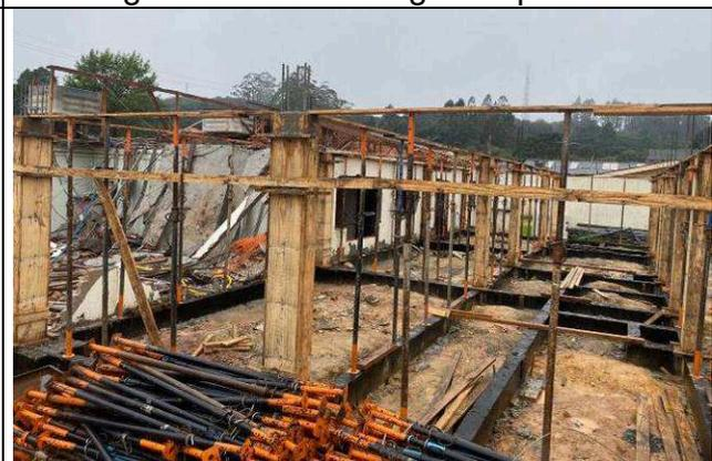
Figura 34: Pilares e vigas baldrame concretados.
