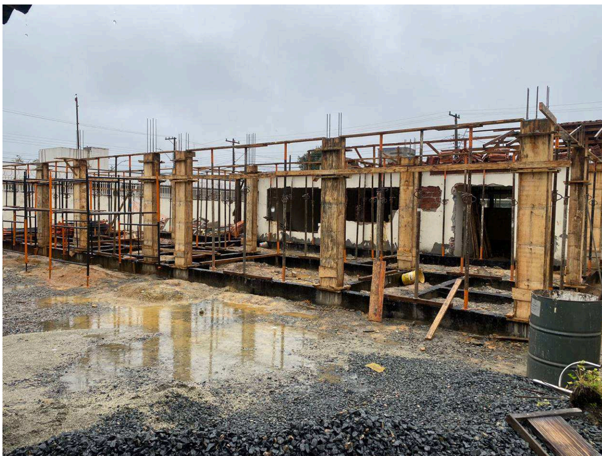
Figura 2 – Vista dos pilares concretados.
