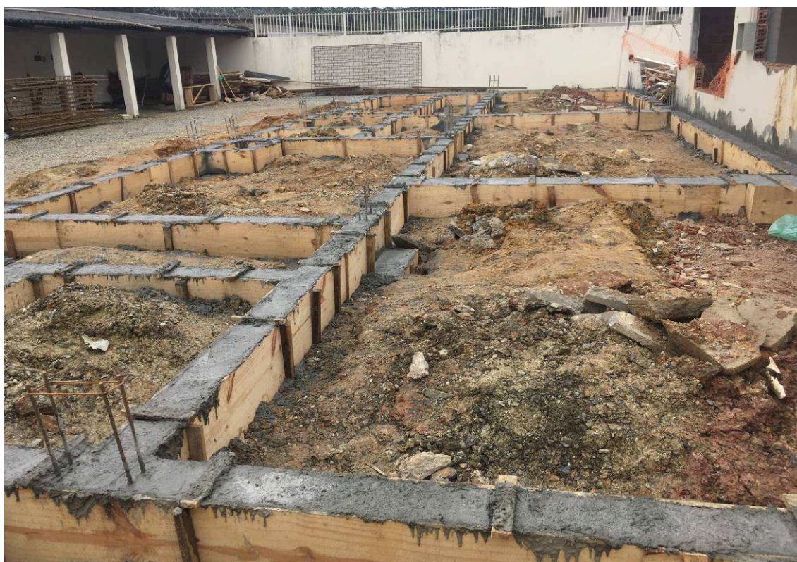
Figura 1 – Vista das vigas baldrame concretadas.
