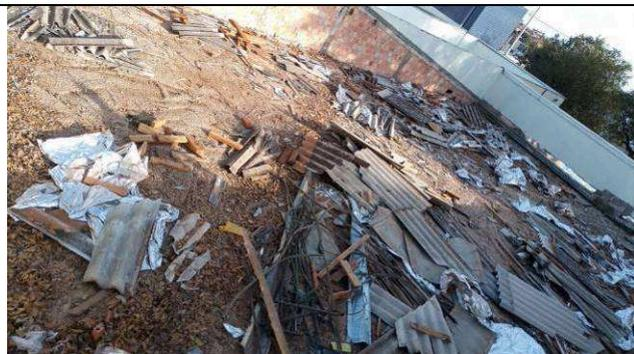
Figura 03: Remoção da estrutura de madeira e telhas de cobertura.
