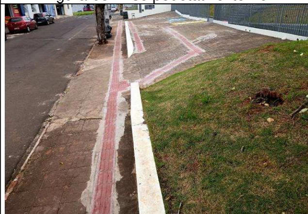
Figura 70: Piso podotátil externo.
