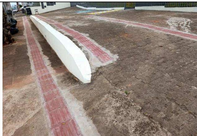
Figura 67: Piso podotátil externo.
