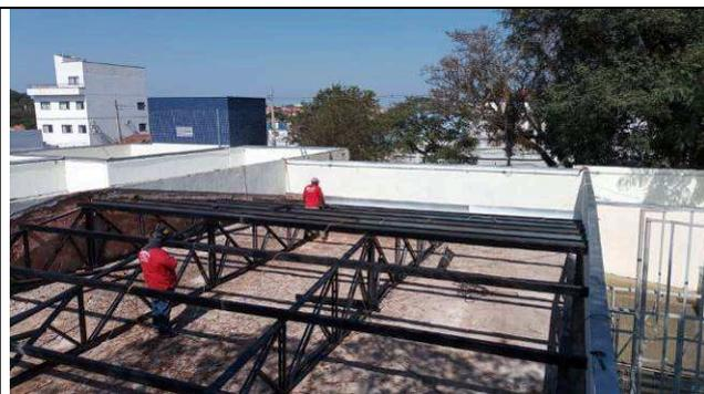
Figura 10: Montagem da estrutura metálica de cobertura.
