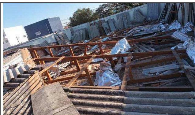
Figura 02: Remoção da estrutura de madeira e telhas de cobertura.
