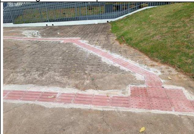
Figura 68: Piso podotátil externo.
