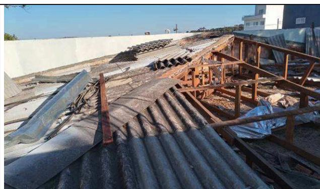
Figura 01: Remoção da estrutura de madeira e telhas de cobertura.
