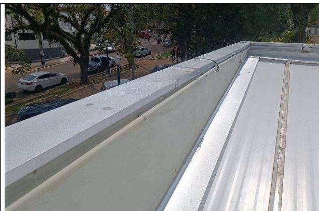
Figura 78: Infraestrutura elétrica platibanda.
