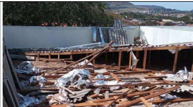
Figura 04: Remoção da estrutura de madeira e telhas de cobertura.
