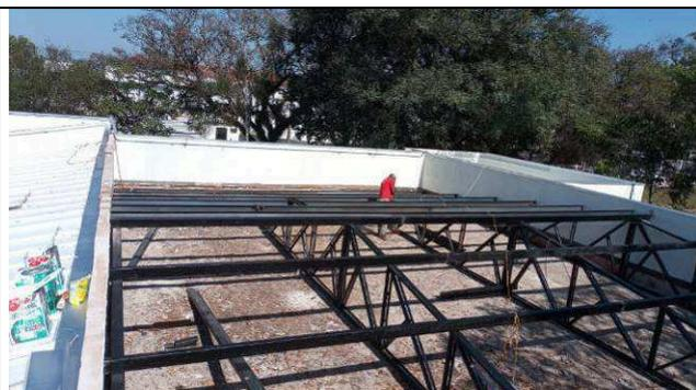
Figura 09: Montagem da estrutura metálica de cobertura.
