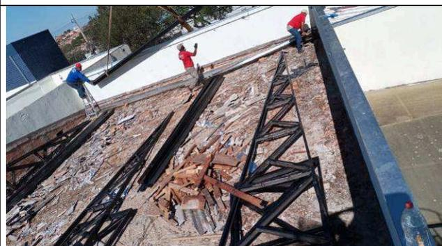
Figura 08: Montagem da estrutura metálica de cobertura.
