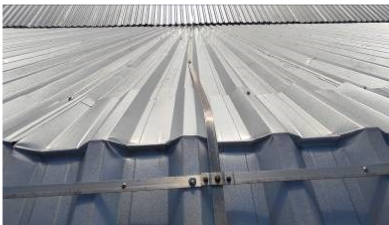
Figura 03: Cumeeiras e Barras chatas de alumínio a reinstalar
