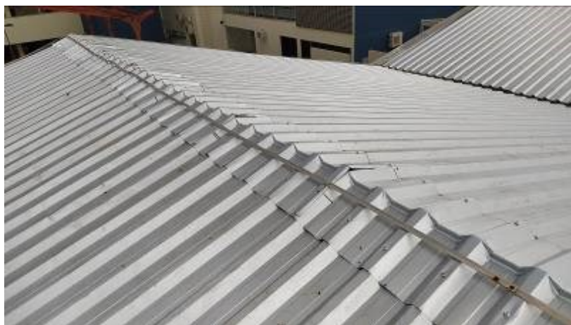
Figura 01: Cumeeiras e barras chatas de aluminio a remover
