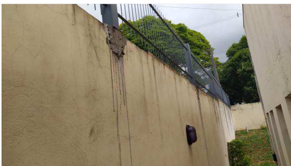
Muro dos fundos: rebocar locais onde foram instalados gradis
