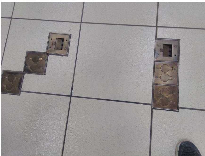
Tomadas e caixas de piso a serem substituídas.
