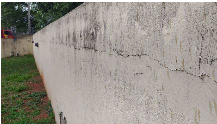
Trecho de muro com trinca
