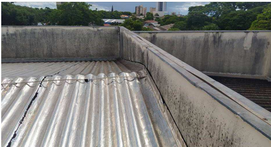
Detalhe de rufos, contrarrufos e rufos chapim – Todos deverão ser removidos para a instalação e rufos e contrarrufos novos
