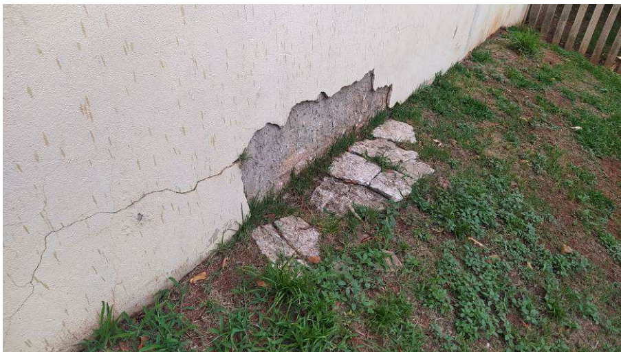
Trecho de muro com trinca e revestimento solto
