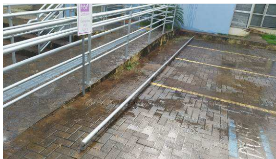
Alvenaria de respaldo dos desníveis existentes nos estacionamentos
