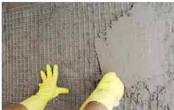
Aplicação da tela soldada de aço
