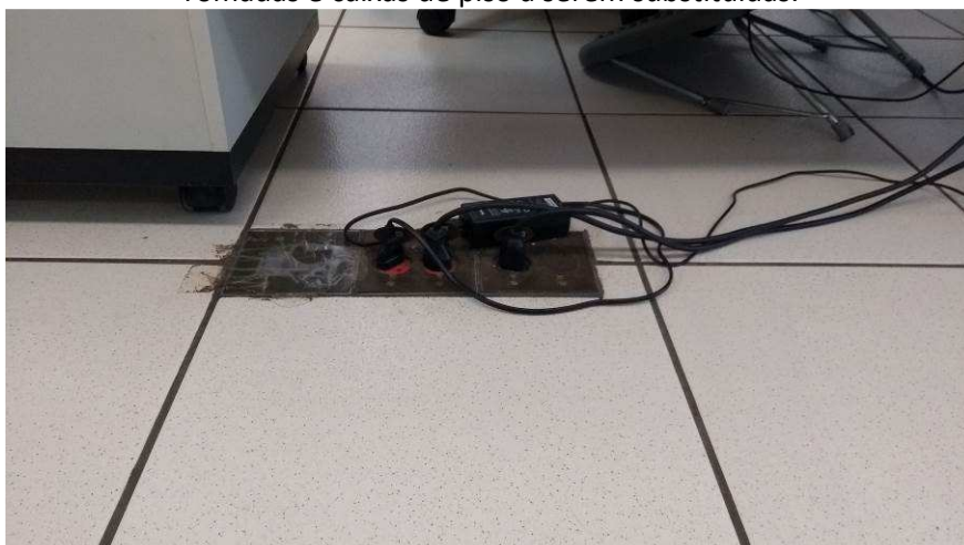
Tomadas e caixas de piso a serem substituídas.
