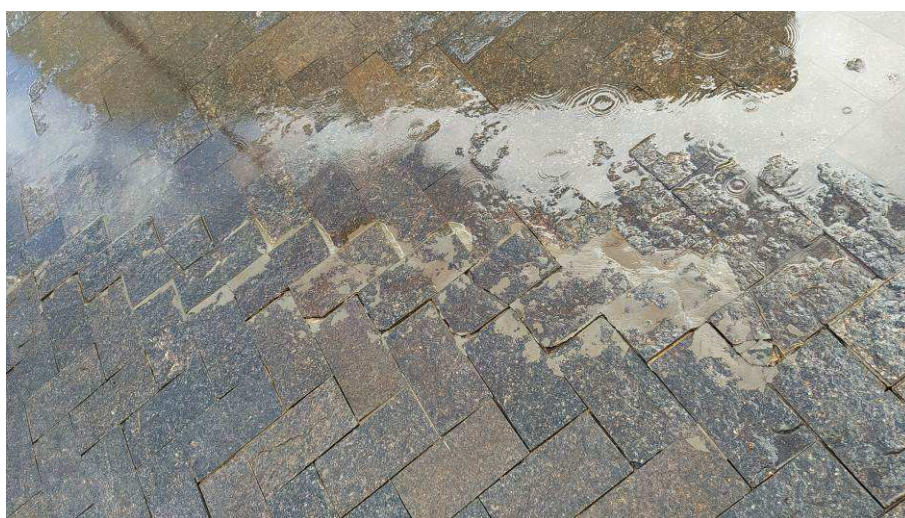
Peças soltas e/ou trincadas
