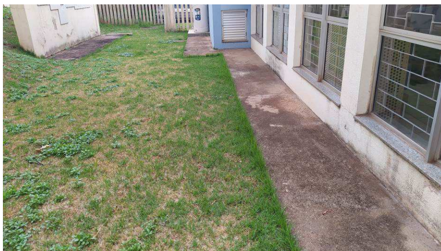
Calçadas em cimento alisado, localizadas no perímetro do imóvel e na mureta da entrada de energia
