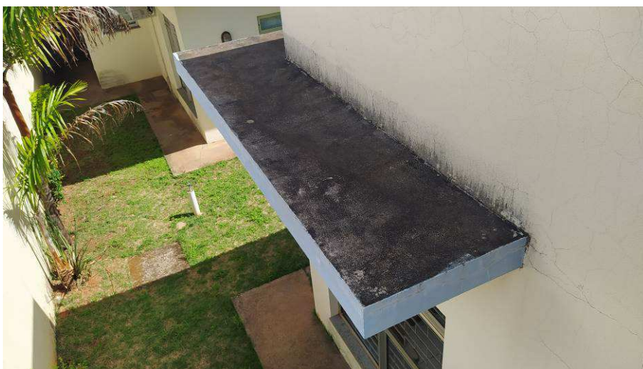
Detalhe de face superior de uma marquise – deverá receber pintura impermeabilizante
