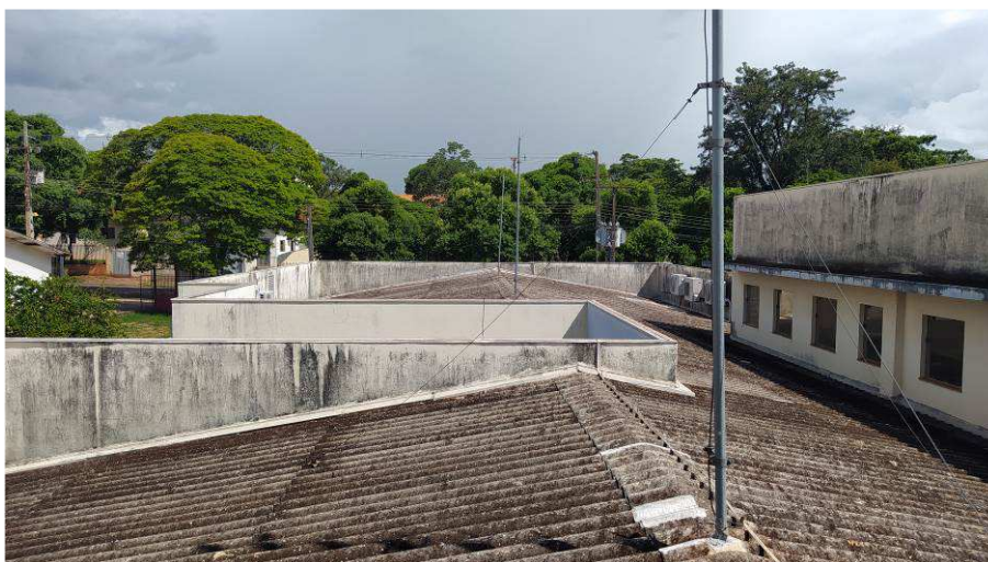
Telhas de fibrocimento 6mm - Deverão ser removidas
