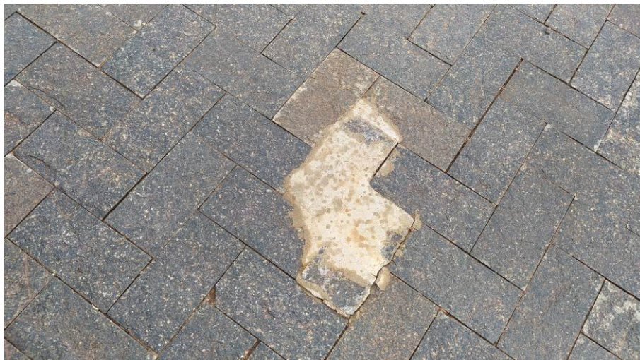
Exemplo de peça de pedra Miracema removida e reparo realizado com argamassa
