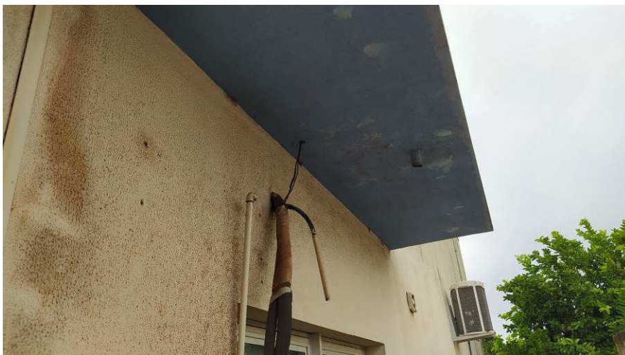
Marquises com textura deteriorada
