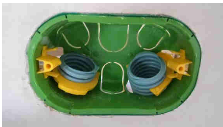
Figura 1 – Caixa de ligação em drywall
