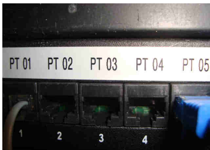
Figura 18 – Patch panel com identificação de pontos
