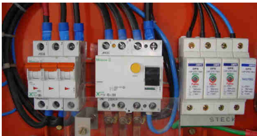
Figura 3 – Disjuntor, dispositivo DR e DPS em quadro
