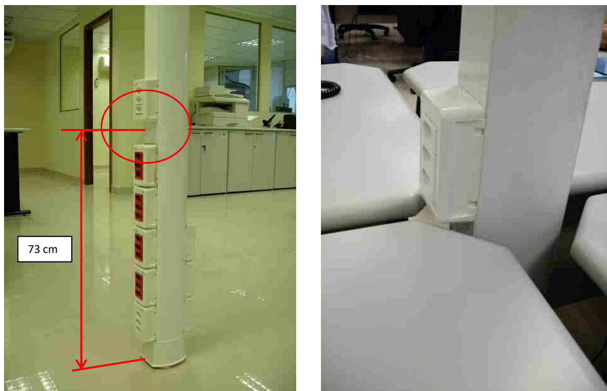
Figura 5 – Poste técnico (Observar interrupção dos porta equipamentos para encaixe da mesa)
