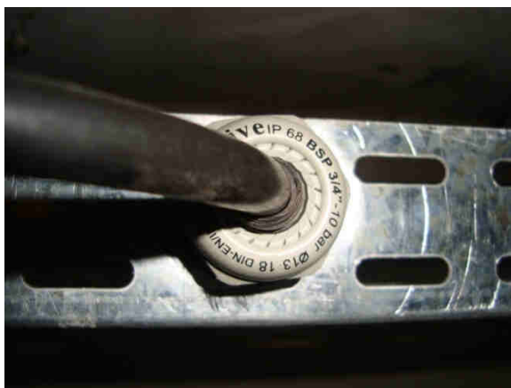
Figura 7 – Derivação para luminárias (prensa-cabo)
