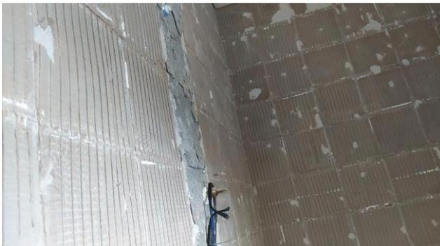
Figura 03C: Demolição do revestimento de azulejo do BWC do juiz titular
