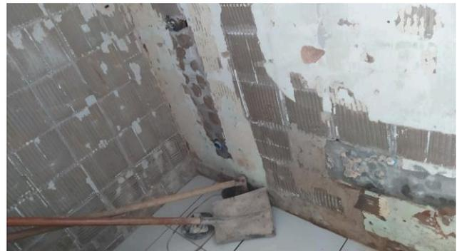
Figura 04C: Demolição do revestimento de azulejo do BWC do juiz titular
