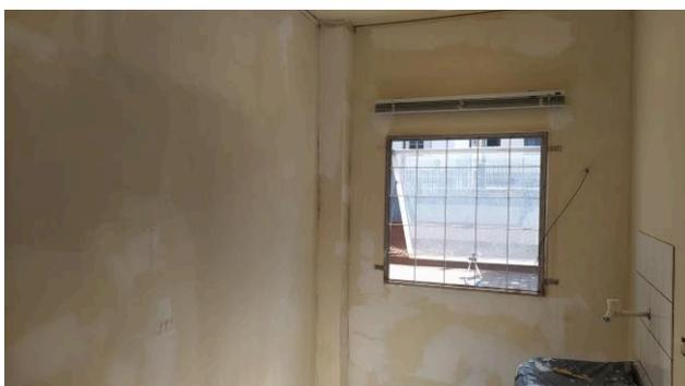
Figura 05C: Aplicação de massa corrida e lixamento de paredes internas – prédio anexo
