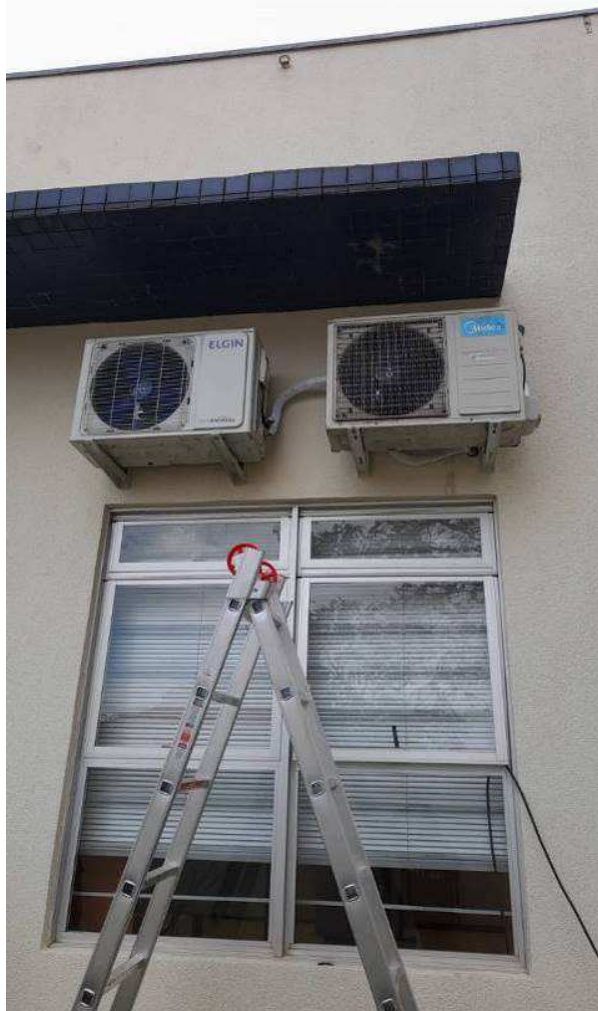
Figura 43: Substituição de linhas e reinstalação dos equipamentos Split.
