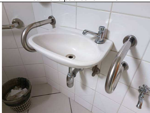
Figura 96: Barras de apoio lavatório – banheiro público masculino.
