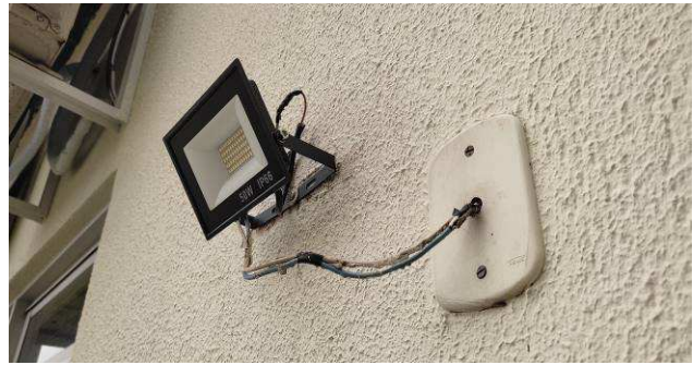
Figura 72: Refletores externos em LED
