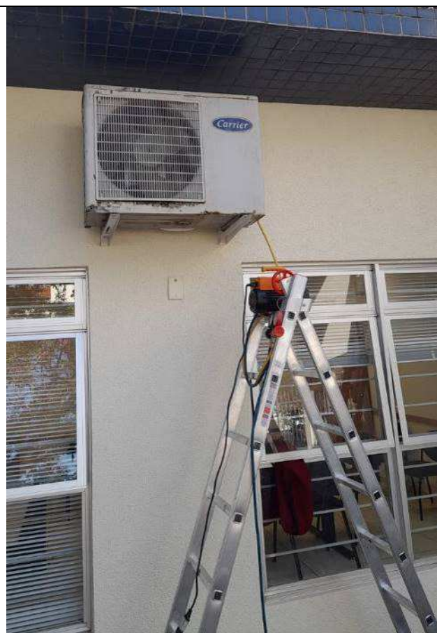
Figura 45: Substituição de linhas e reinstalação dos equipamentos Split.
