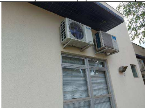
Figura 39: Substituição de linhas e reinstalação dos equipamentos Split.
