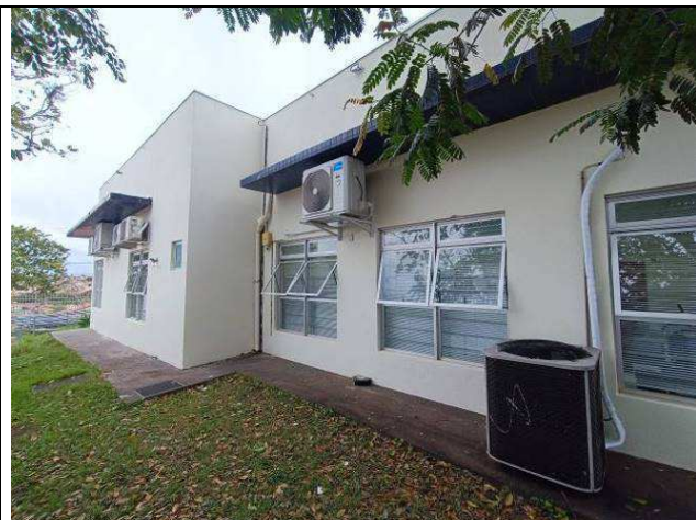
Figura 65: Pintura de paredes externas.
