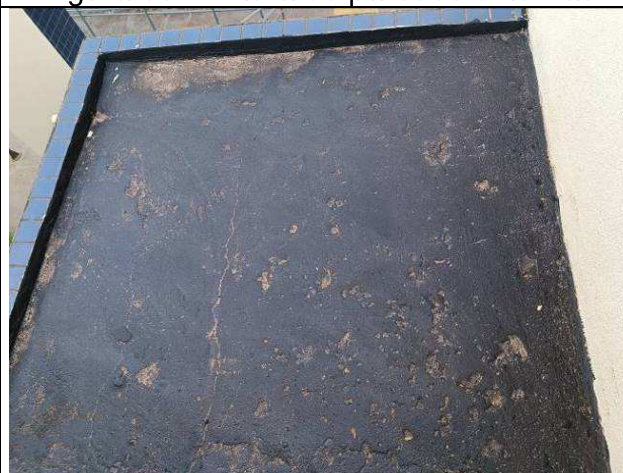
Figura 67: Impermeabilização marquises.
