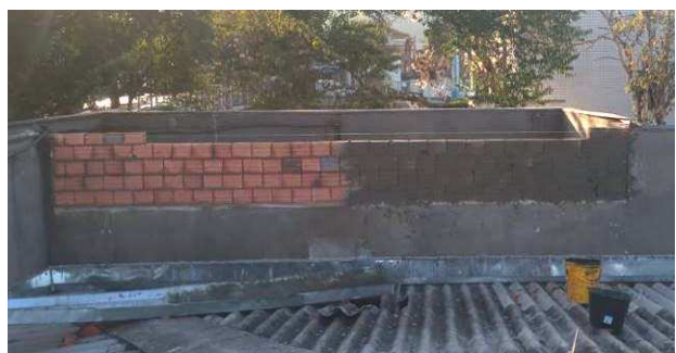
Figura 31: Alvenaria de complementação da platibanda.
