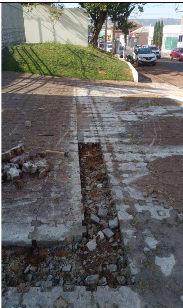
Figura 100: Corte e demolição – piso podotátil externo.
