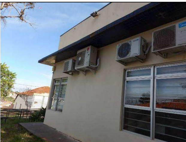
Figura 48: Substituição de linhas e reinstalação dos equipamentos Split.
