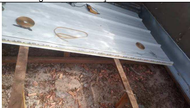
Figura 08: Instalação das telhas – fitas de vedação nas emendas longitudinais.
