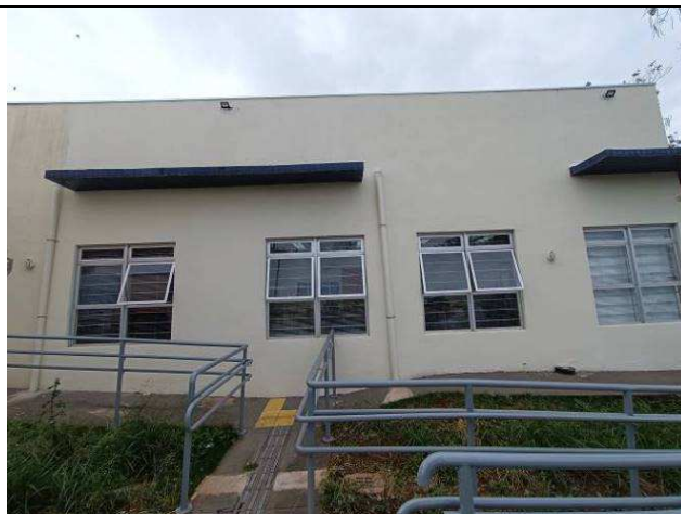
Figura 66: Pintura de paredes externas.
