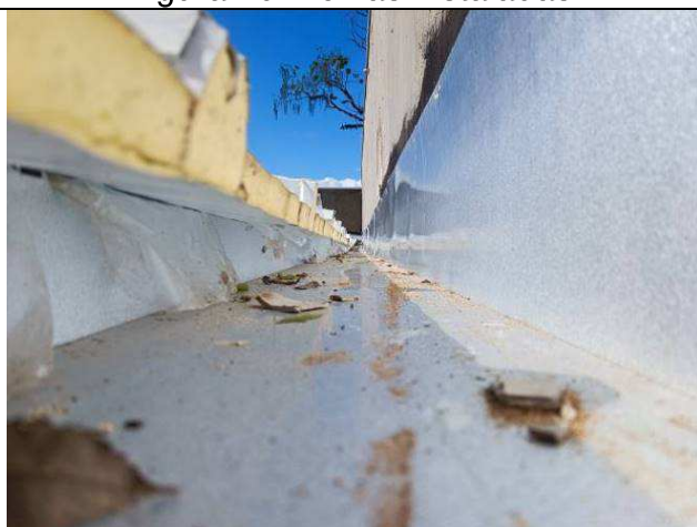
Figura 22: Calhas instaladas.
