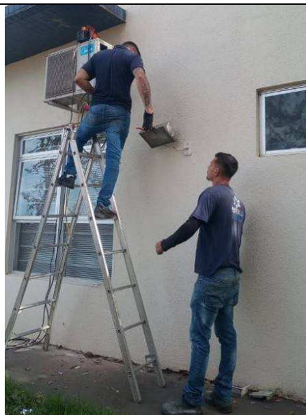
Figura 36: Substituição de linhas e reinstalação dos equipamentos Split.
