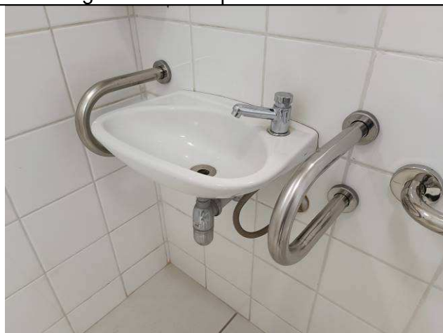
Figura 93: Barras de apoio lavatório – banheiro público feminino.
