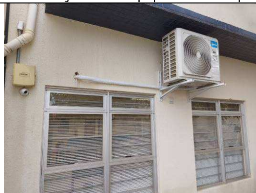
Figura 40: Substituição de linhas e reinstalação dos equipamentos Split.
