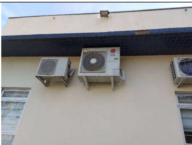
Figura 47: Substituição de linhas e reinstalação dos equipamentos Split.
