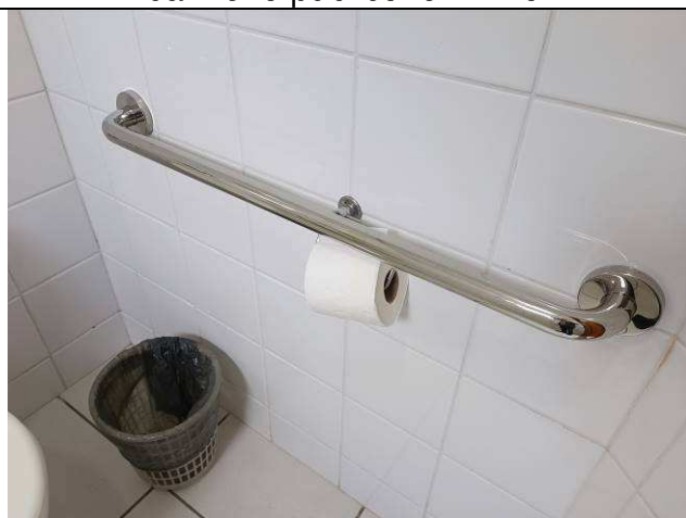
Figura 95: Barras de apoio bacia sanitária – banheiro público feminino.
