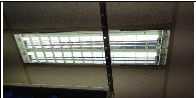
Figura 80: Lâmpadas tubulares em LED
