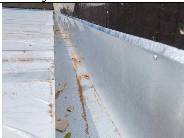
Figura 21: Calhas instaladas.
