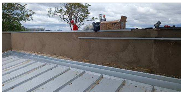
Figura 32: Alvenaria de complementação da platibanda.
