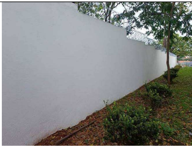
Figura 54: Pintura de muros.
