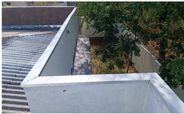
Figura 30: Rufos instalados.
