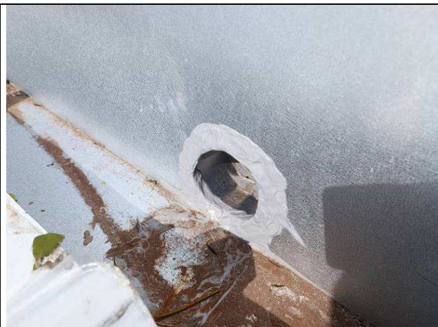
Figura 23: Calhas instaladas-extravasador.
