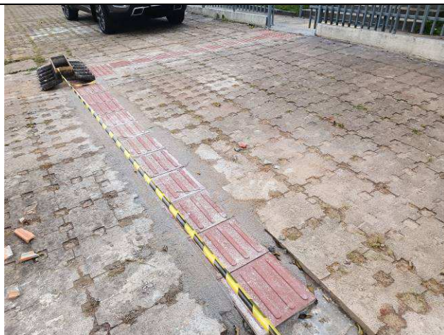
Figura 102: Piso podotátil externo.
