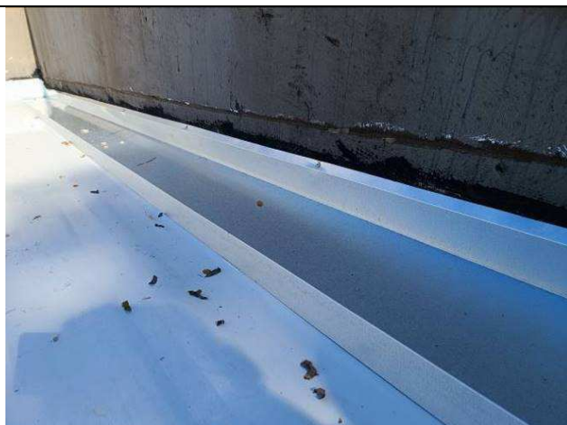
Figura 26: Rufos instalados.
