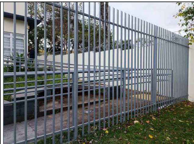
Figura 59: Pintura do gradil.
