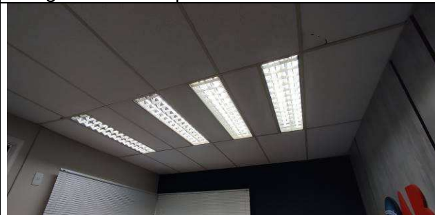
Figura 81: Lâmpadas tubulares em LED
