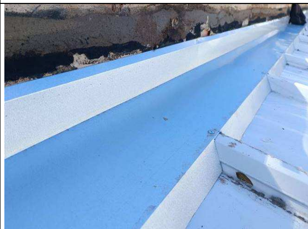
Figura 25: Rufos instalados.
