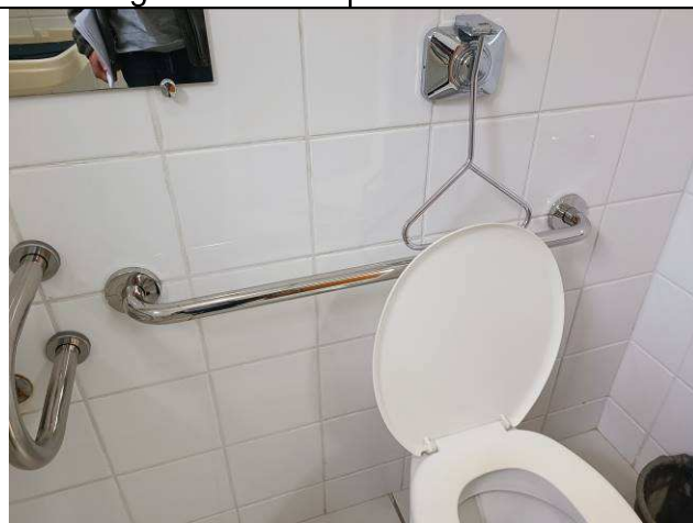
Figura 94: Barras de apoio bacia sanitária – banheiro público feminino.
