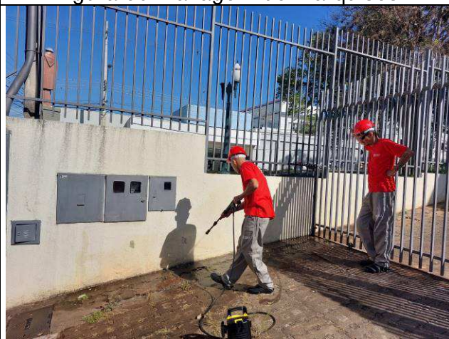
Figura 52: Lavagem de muros.
