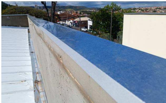
Figura 29: Rufos instalados.
