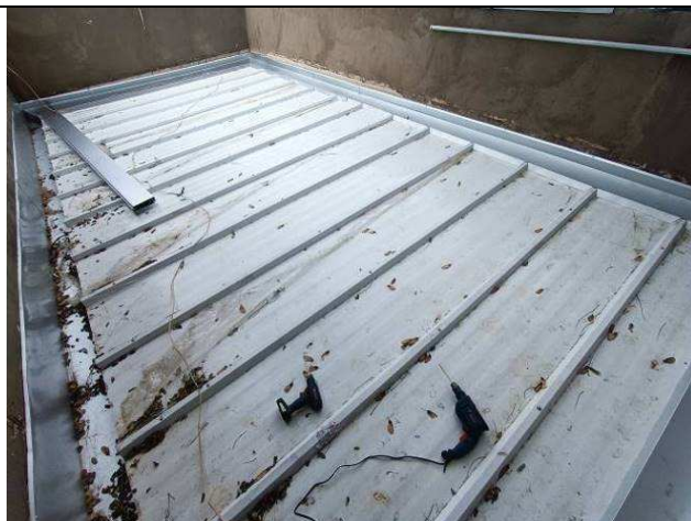
Figura 18: Telhas instaladas.
