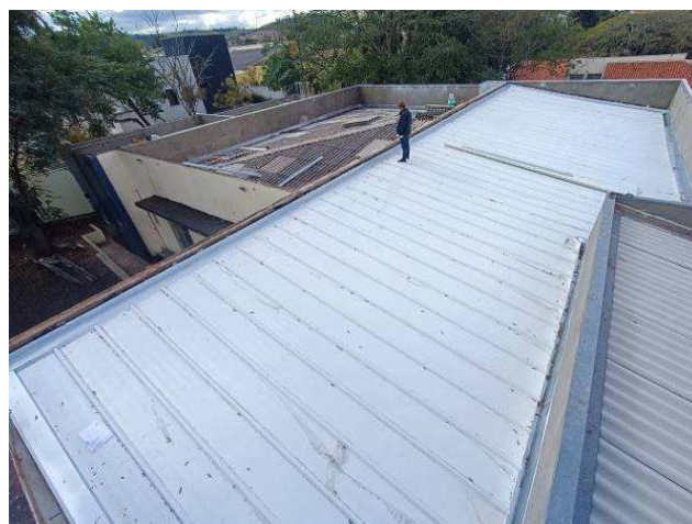
Figura 16: Telhas instaladas.
