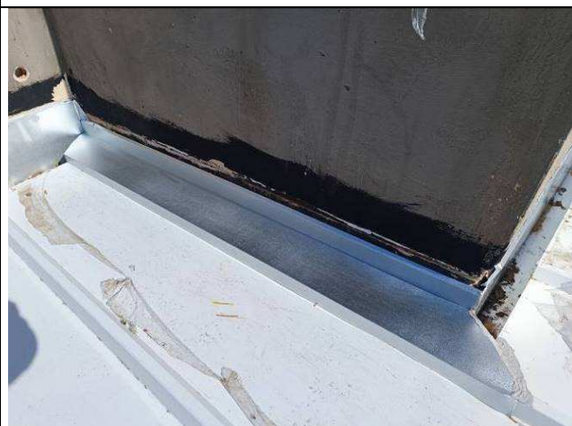
Figura 27: Rufos instalados.
