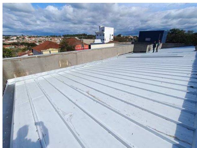
Figura 15: Telhas instaladas.
