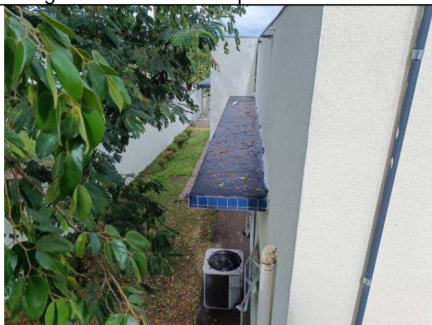
Figura 68: Impermeabilização marquises.
