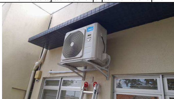
Figura 38: Substituição de linhas e reinstalação dos equipamentos Split.
