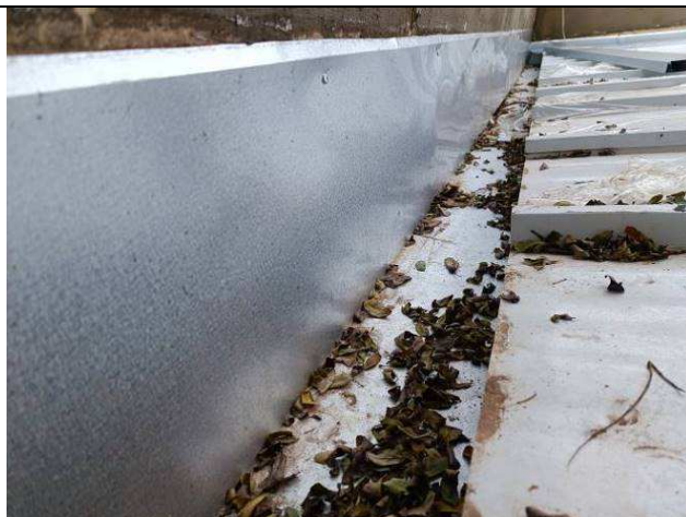
Figura 24: Calhas instaladas.
