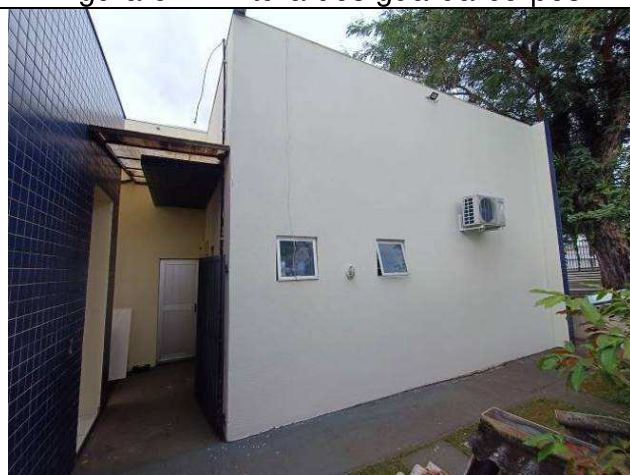
Figura 64: Pintura de paredes externas.
