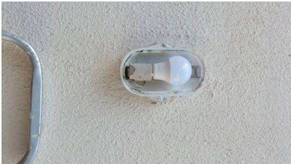
Figura 85: Lâmpadas bulbo em LED
