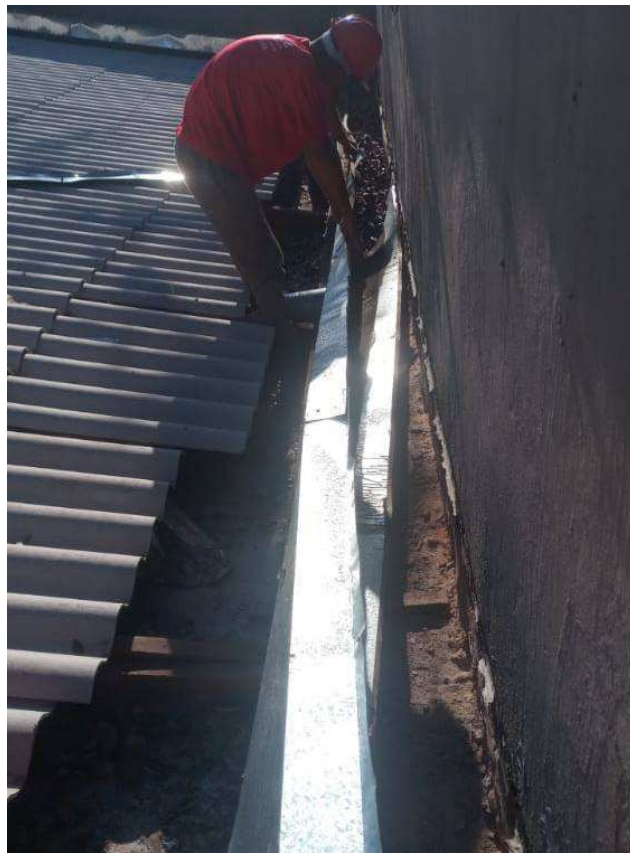
Figura 14: Instalação das calhas.
