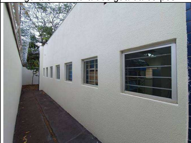
Figura 63: Pintura de paredes externas.
