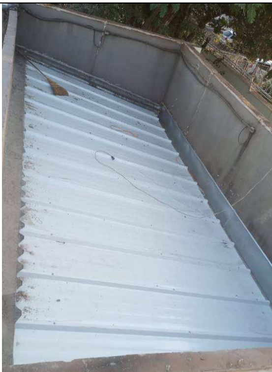
Figura 09: Instalação das telhas.
