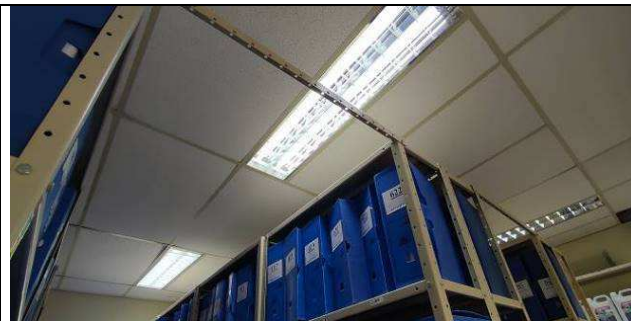
Figura 79: Lâmpadas tubulares em LED
