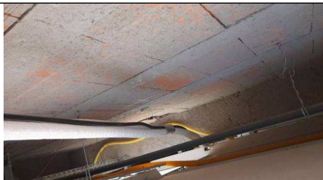
Figura 41: Substituição de linhas e reinstalação dos equipamentos Split.
