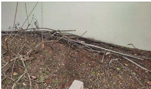
Figura 33: Retirada do SPDA existente.
