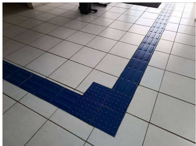
Figura 90: Piso podotátil interno.
