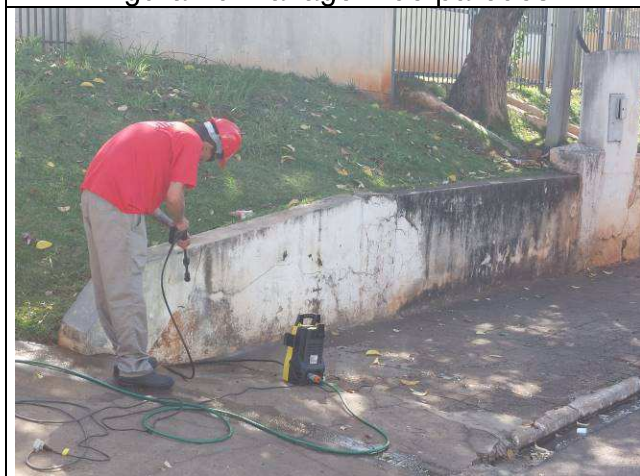
Figura 51: Lavagem de muros.
