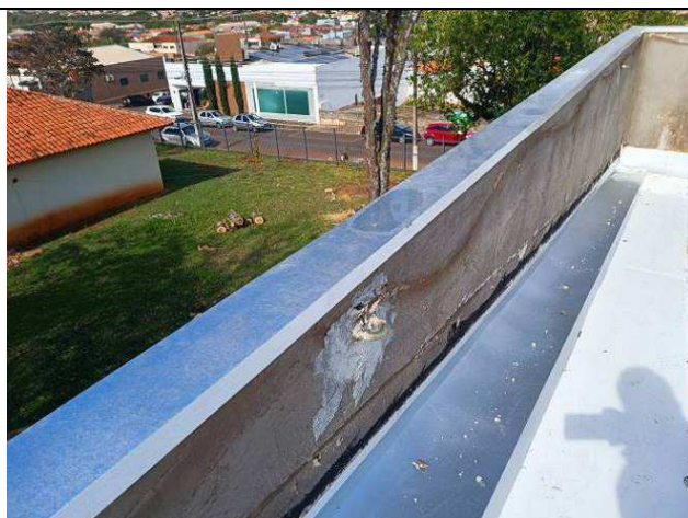
Figura 28: Rufos instalados.
