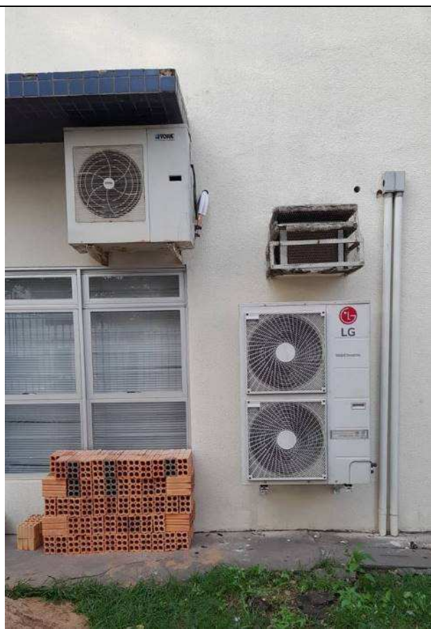
Figura 46: Substituição de linhas e reinstalação dos equipamentos Split.
