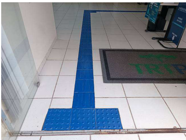
Figura 89: Piso podotátil interno.
