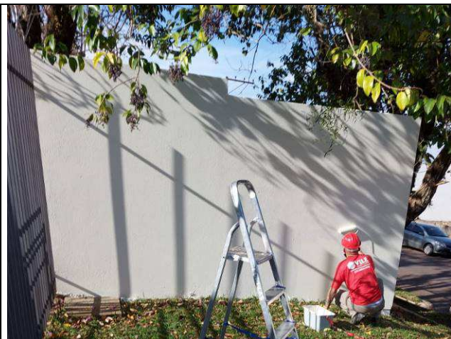
Figura 53: Pintura de muros.
