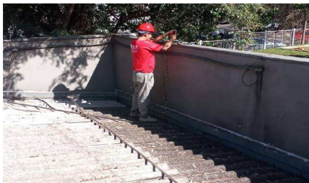
Figura 34: Retirada do SPDA existente.
