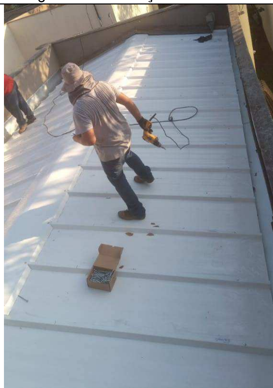
Figura 11: Instalação das telhas.
