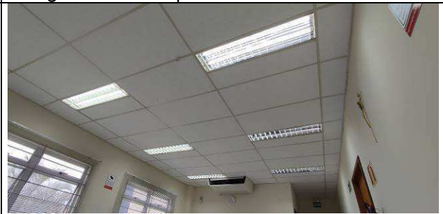
Figura 82: Lâmpadas tubulares em LED
