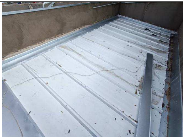
Figura 17: Telhas instaladas.
