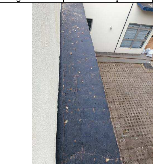
Figura 69: Impermeabilização marquises.
