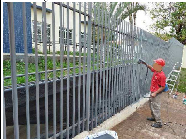
Figura 57: Pintura do gradil frontal.
