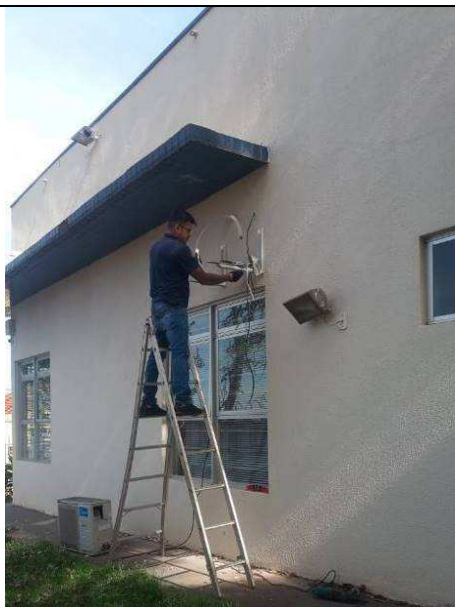
Figura 35: Substituição de linhas e reinstalação dos equipamentos Split.
