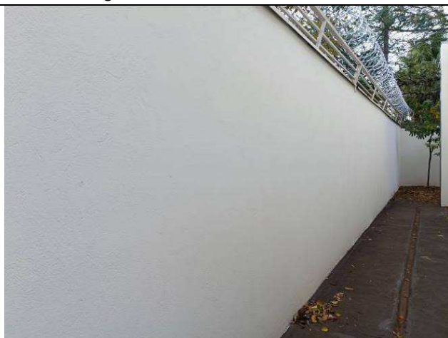
Figura 56: Pintura de muros.
