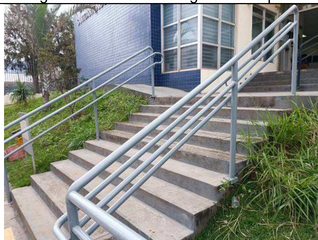
Figura 62: Pintura dos guarda-corpos.
