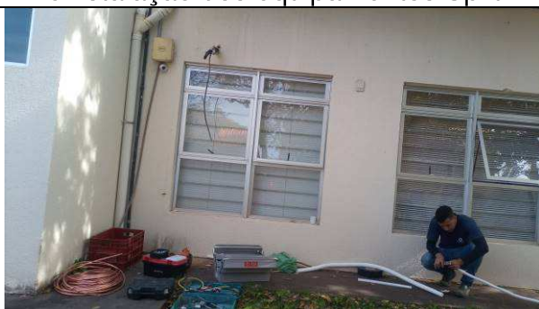
Figura 37: Substituição de linhas e reinstalação dos equipamentos Split.
