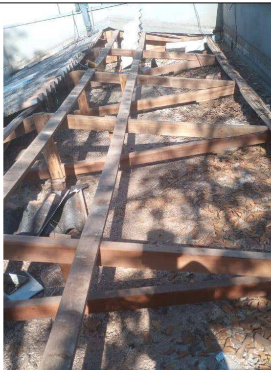
Figura 10: Instalação das telhas.
