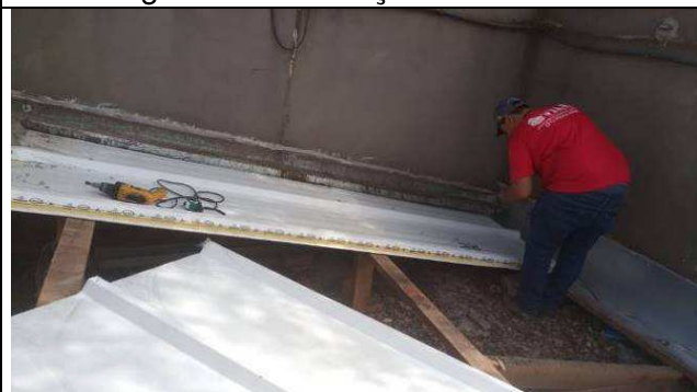
Figura 07: Instalação das telhas.
