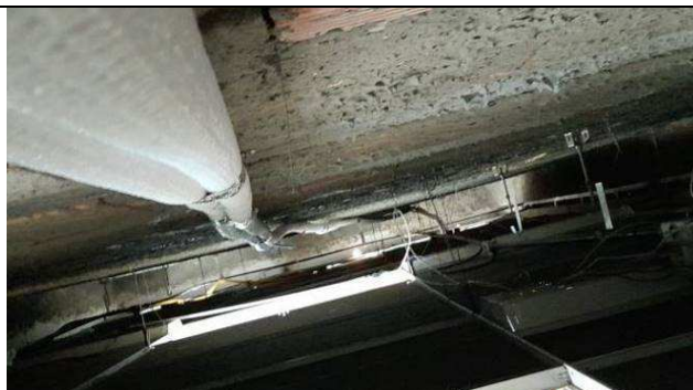
Figura 42: Substituição de linhas e reinstalação dos equipamentos Split.
