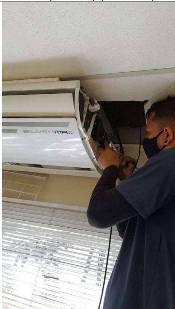
Figura 44: Substituição de linhas e reinstalação dos equipamentos Split.
