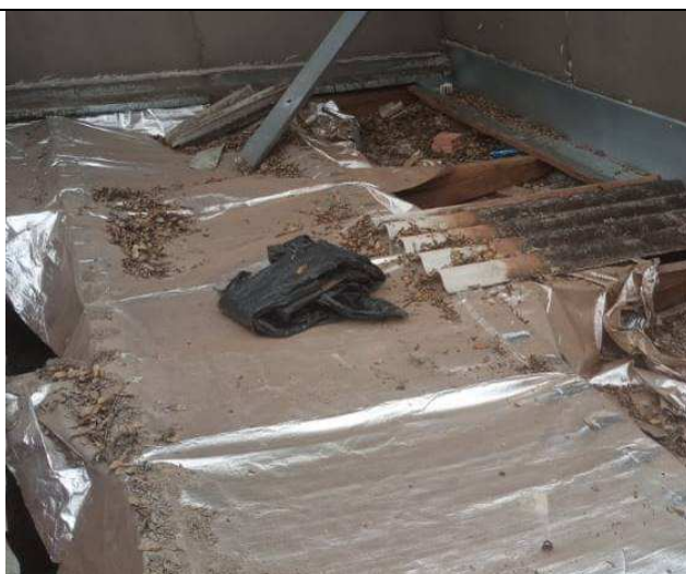
Figura 06: Remoção de telhas.
