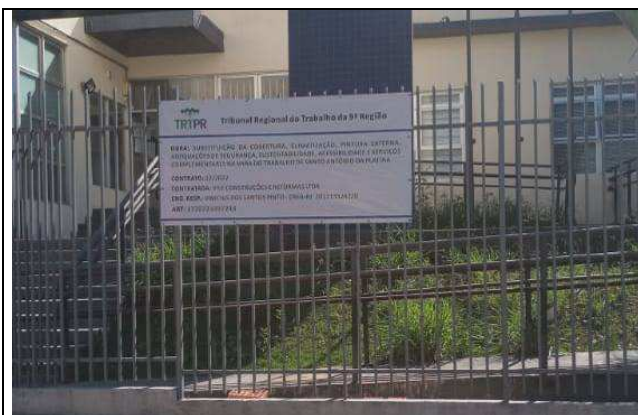
Figura 01: Placa de obra.
