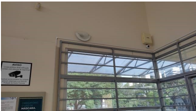
Figura 27E: ponto para futura instalação de cortina de ar
