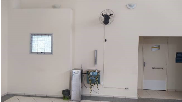
Figura 06C: Recuperação de pano de parede no saguão
