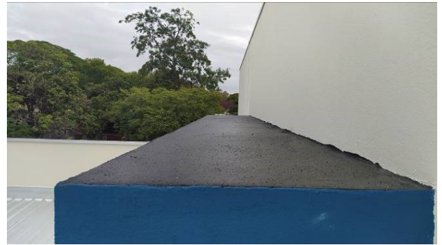
Figura 15C: Pintura asfáltica impermeabilizante na face superior da marquise lateral do saguão
