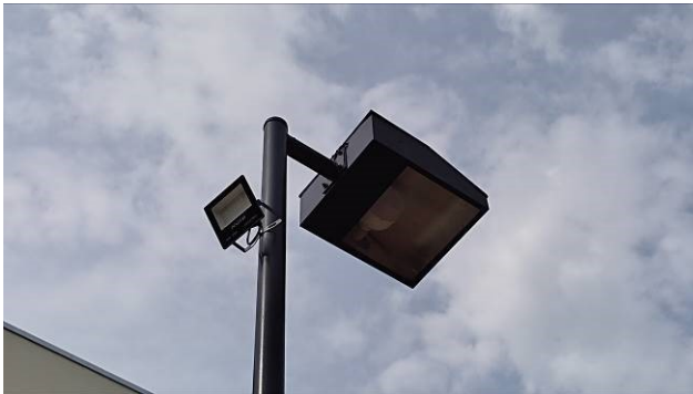
Figura 09E: iluminação externa – refletores e substituição de lâmpadas
