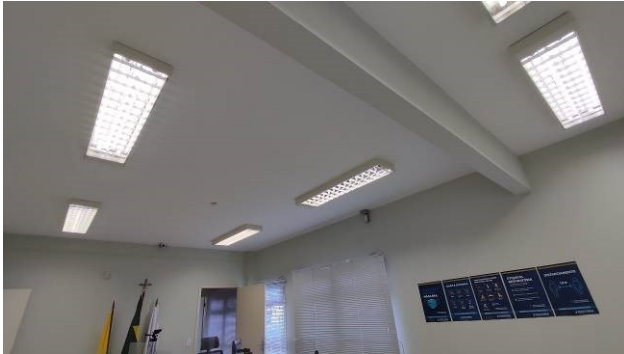
Figura 23E: iluminação interna – substituição de lâmpadas por tecnologia LED
