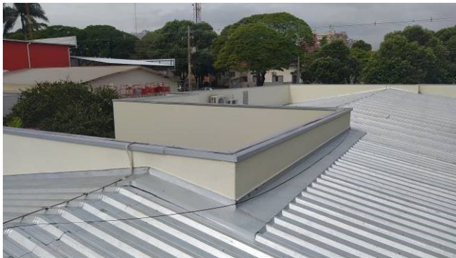
Figura 02C: Rufos/contrarrufos instalados na cobertura – região da sala de audiência 2 e secretaria
