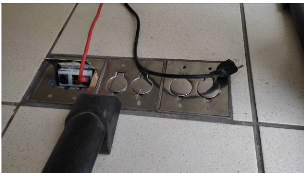
Figura 31E: substituição de tomadas de piso
