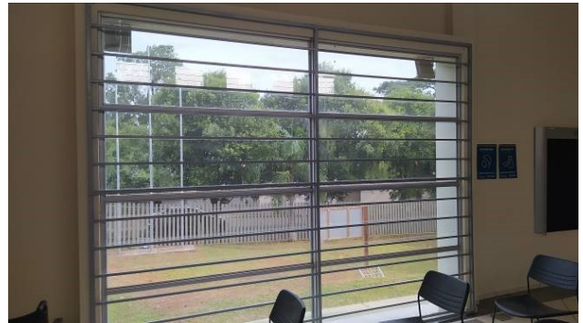
Figura 21C: Grade de proteção da janela em vidro fixo, no saguão
