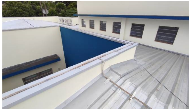
Figura 06E: Reinstalação do SPDA
