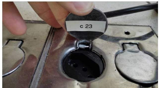
Figura 32E: substituição de tomadas de piso
