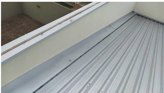
Figura 04C: Rufos/contrarrufos instalados na cobertura – região dos PABs
