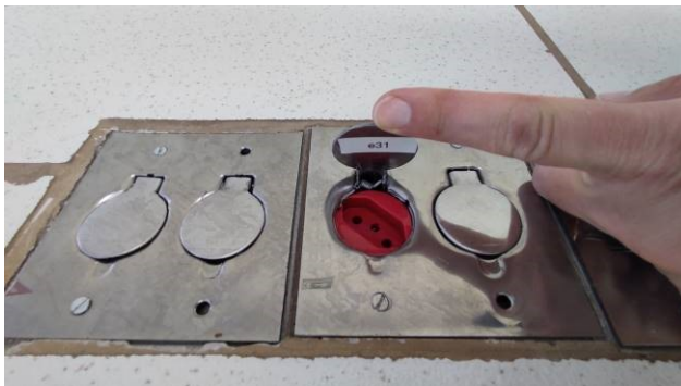
Figura 29E: substituição de tomadas de piso
