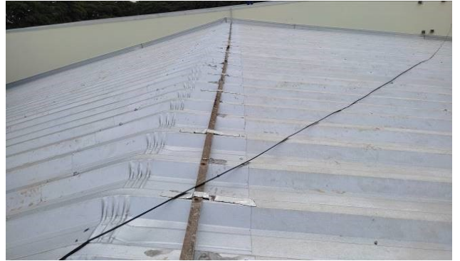
Figura 02E: Reinstalação do SPDA
