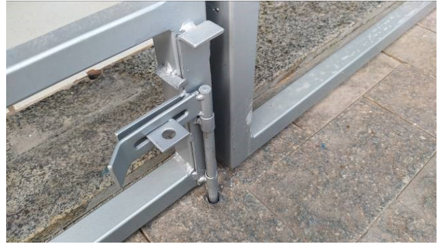
Figura 25C: Detalhe do trinco de fechamento inferior
