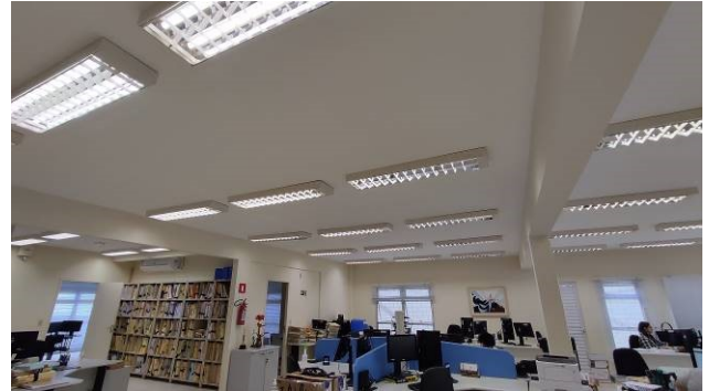
Figura 24E: iluminação interna – substituição de lâmpadas por tecnologia LED
