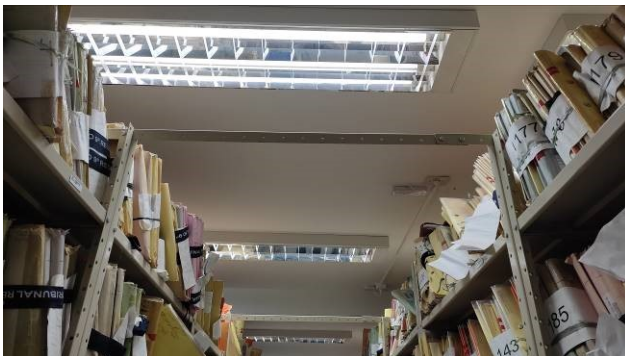
Figura 21E: iluminação interna – substituição de lâmpadas por tecnologia LED
