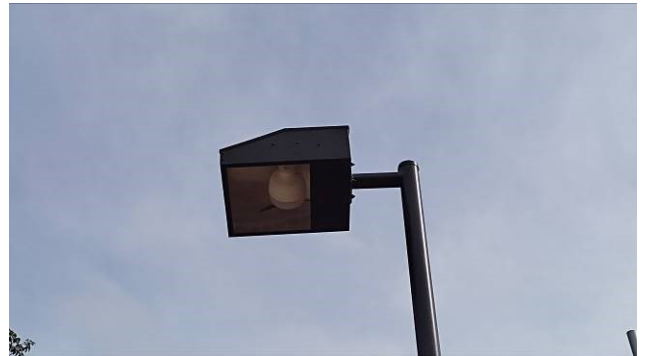
Figura 10E: iluminação externa – substituição de lâmpadas
