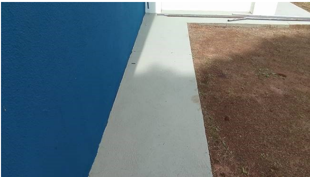
Figura 16C: Pintura das calçadas no perímetro do prédio – região do saguão
