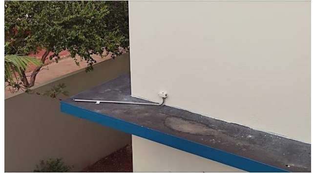
Figura 26E: infraestrutura sobre as marquises
