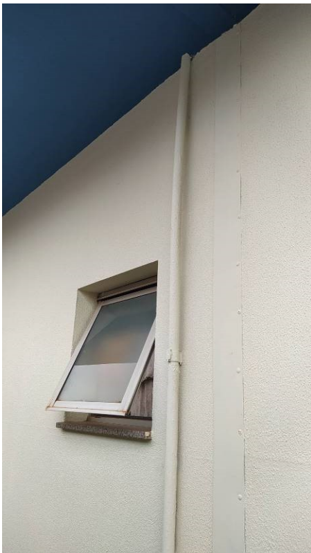
Figura 26C: Instalação de chapa metálica na junta de dilatação
