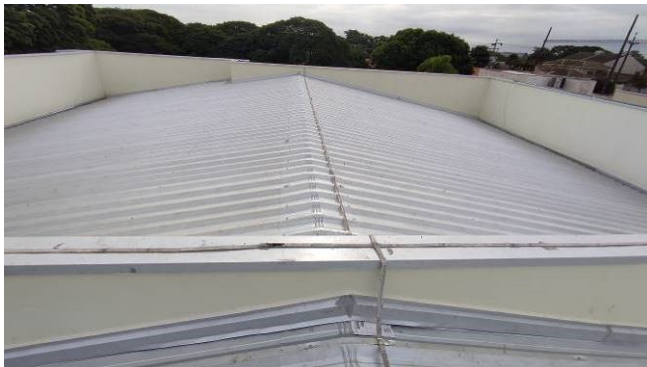
Figura 05E: Reinstalação do SPDA
