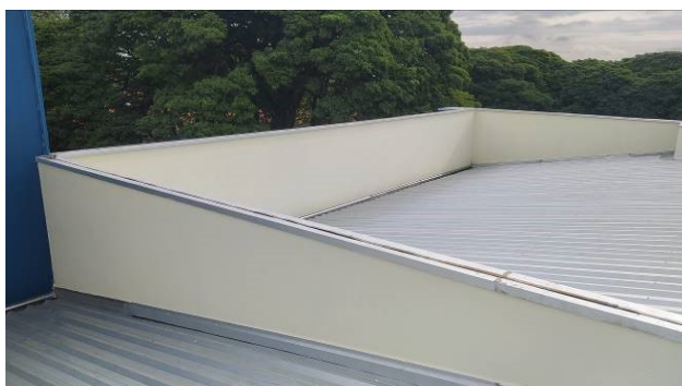
Figura 10C: Pintura das faces internas das platibandas – região do saguão dos PABs
