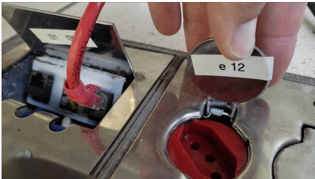
Figura 35E: substituição de tomadas de piso
