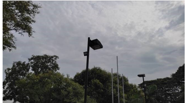
Figura 08E: iluminação externa – refletores e substituição de lâmpadas
