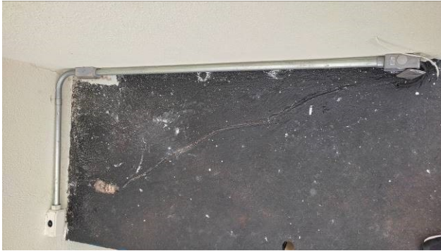
Figura 25E: infraestrutura sobre as marquises
