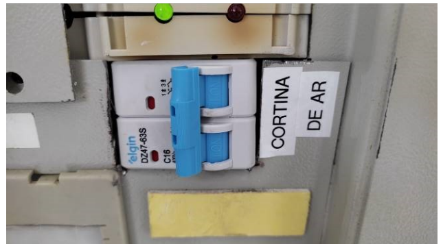
Figura 28E: ponto para futura instalação de cortina de ar
