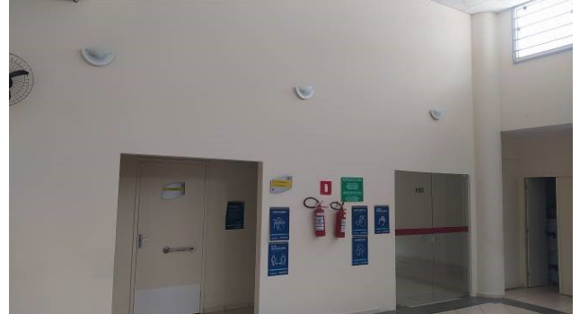
Figura 07C: Recuperação de pano de parede no saguão
