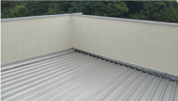
Figura 12C: Pintura das faces internas das platibandas – região da sala de audiência 1 e Gabinete do juiz titular
