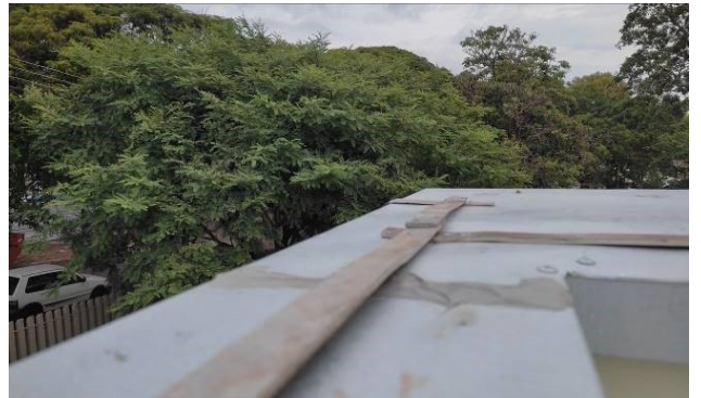
Figura 04E: Reinstalação do SPDA
