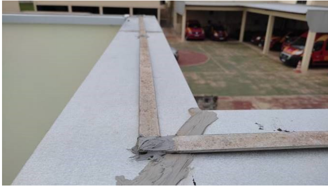
Figura 01E: Reinstalação do SPDA
