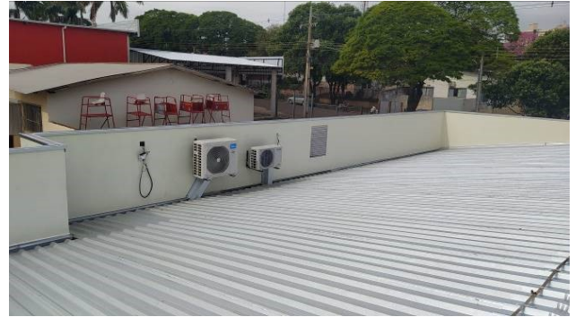
Figura 13C: Pintura das faces internas das platibandas – região da secretaria
