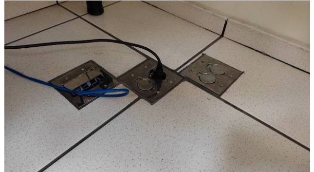
Figura 34E: i substituição de tomadas de piso
