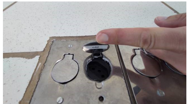
Figura 30E: substituição de tomadas de piso
