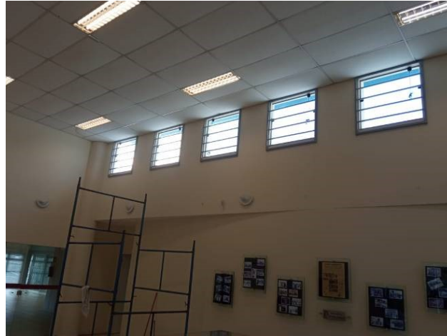
Figura 01C: Andaime sendo utilizado na instalação das grades nas janelas do saguão
