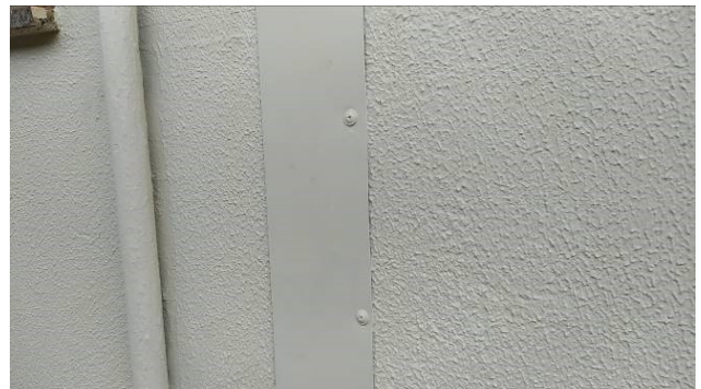
Figura 28C: Detalhe da chapa instalada na junta de dilatação – Parede
