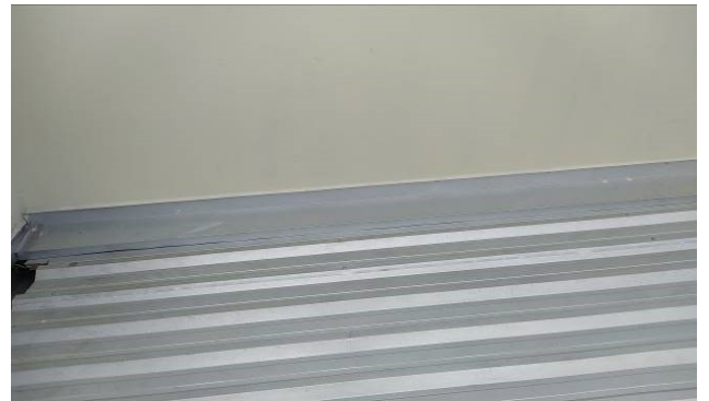
Figura 03C: Rufos/contrarrufos instalados na cobertura – região do arquivo
