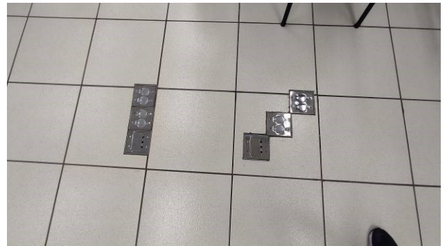
Figura 36E: substituição de tomadas de piso
