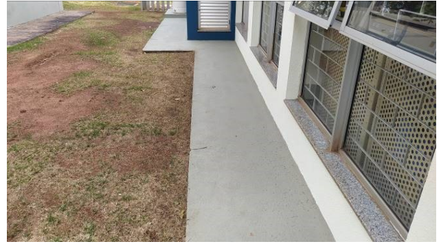
Figura 19C: Pintura das calçadas no perímetro do prédio – região da secretaria
