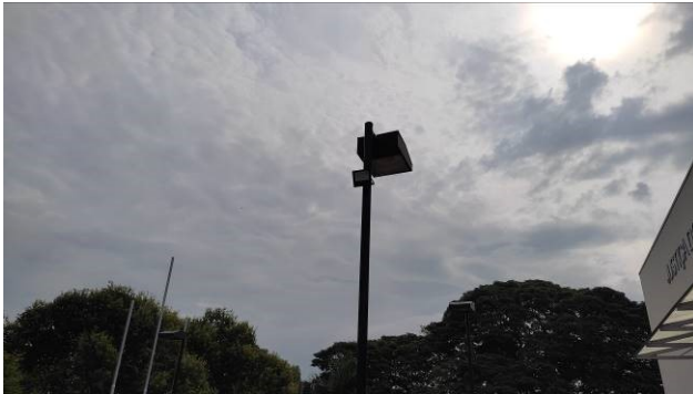
Figura 07E: iluminação externa – refletores e substituição de lâmpadas
