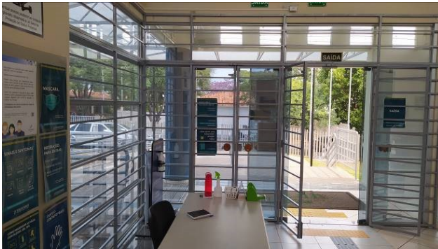
Figura 20C: Grades de proteção da porta de acesso principal, no saguão e vidro fixo lateral
