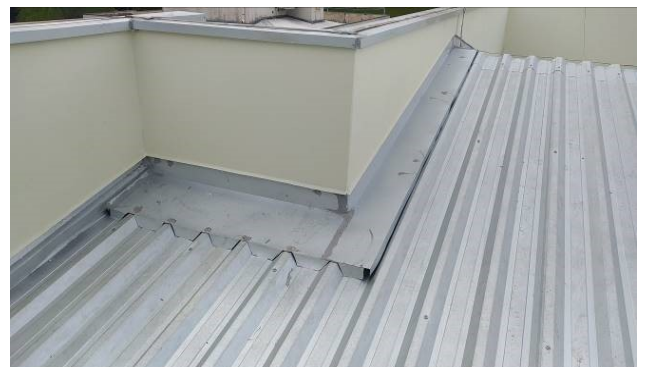
Figura 05C: Rufos/contrarrufos instalados na cobertura – região do saguão dos PABs
