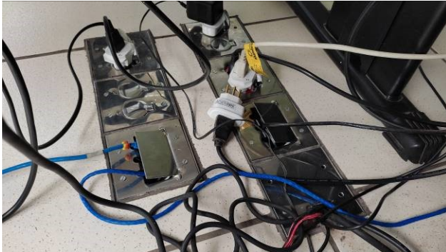
Figura 33E: substituição de tomadas de piso
