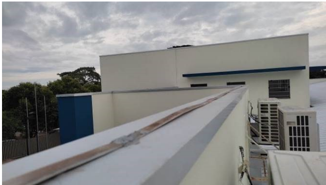
Figura 03E: Reinstalação do SPDA
