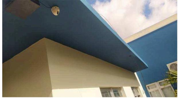
Figura 49C: Face lateral e inferior de marquises, após pintura acrílica super premium na cor Rushville (equivalente da Lukscolor ao Nocturne Blue, da Sherwin Williams) . A tinta utilizada foi a Luksclean
