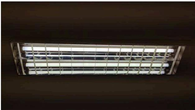
Figura 13E: Lâmpadas tubulares LED
