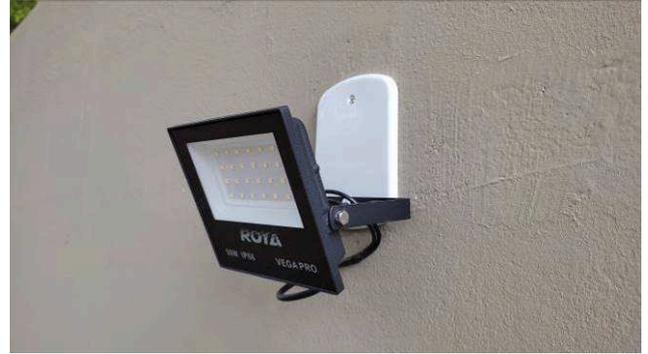
Figura 06E: refletores em LED padrão IP66 para iluminação externa
