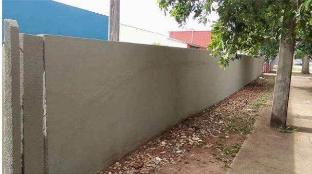
Figura 30C: Muro lateral direito, face externa, após pintura na cor "concreto", usando látex acrílico super premium (Luksclean)
