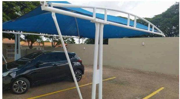
Figura 39C: Cobertura de veículos, após pintura com esmalte sintético na cor "branca"
