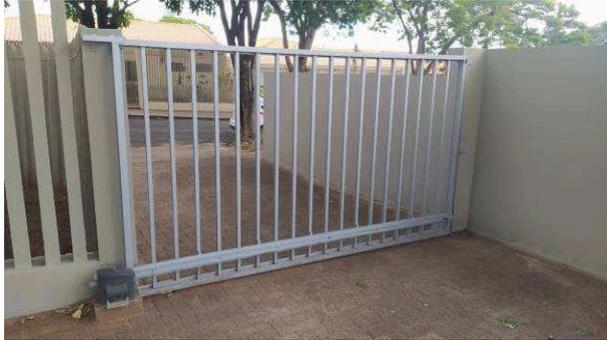
Figura 36C: Portão de veículos do estacionamento privativo, após pintura com esmalte sintético na cor "cinza platina"
