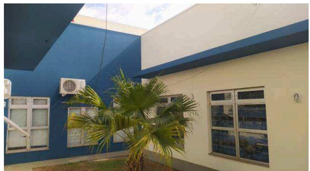
Figura 47C: Fachada dos fundos, após pintura acrílica super premium nas cores Nice (equivalente da Lukscollor ao Doric White da Sherwin Williams) e Rushville (equivalente da Lukscollor ao Nocturne Blue, da Sherwin Williams). A tinta utilizada foi a Luksclean
