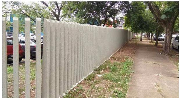
Figura 35C: Muro palito lateral direito, após pintura na cor "concreto", usando látex acrílico super premium (Luksclean)
