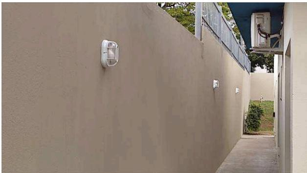
Figura 09E: Novas arandelas tipo tartaruga com lâmpadas bulbo LED
