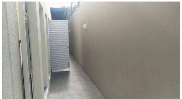
Figura 29C: Muro dos fundos, face interna, após pintura na cor "concreto", usando látex acrílico super premium (Luksclean)
