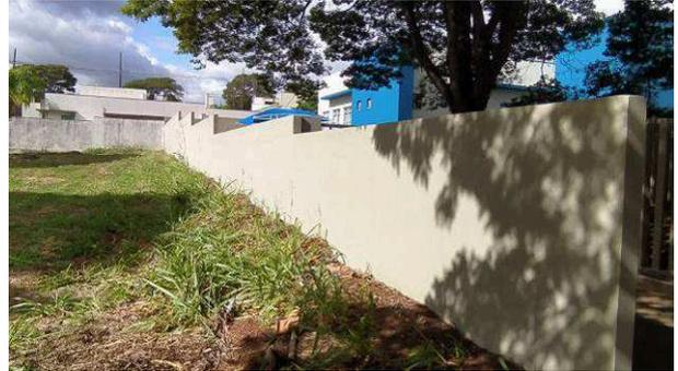
Figura 31C: Muro lateral esquerdo, face externa, após pintura na cor "concreto", usando látex acrílico super premium (Luksclean)
