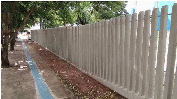
Figura 34C: Muro palito frontal, após pintura na cor "concreto", usando látex acrílico super premium (Luksclean)
