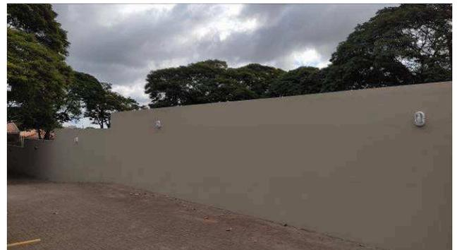
Figura 10E: Novas arandelas tipo tartaruga com lâmpadas bulbo LED
