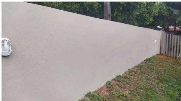
Figura 28C: Muro lateral direito, face interna, após pintura na cor "concreto", usando látex acrílico super premium (Luksclean)
