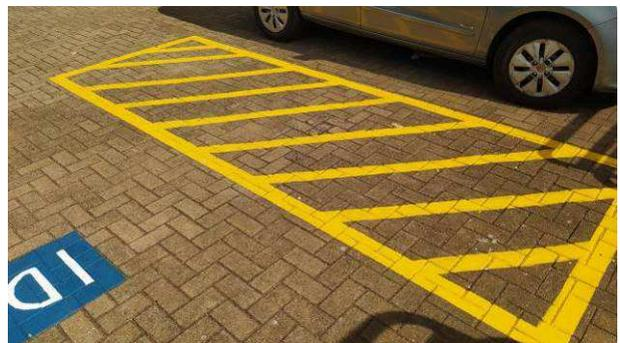
Figura 57C: Demarcação da vaga PNE, com faixa zebra
