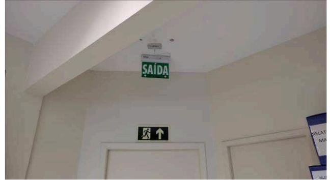
Figura 12E: Balizadores de emergência
