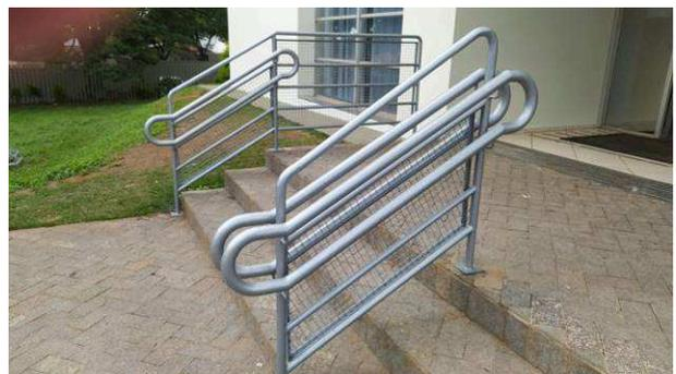
Figura 41C: Guarda-corpo e corrimãos da entrada principal, após pintura com esmalte sintético na cor "cinza platina"
