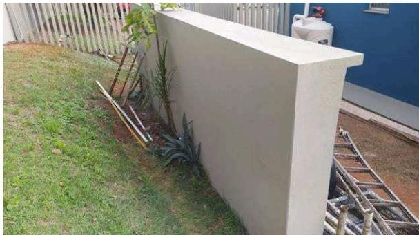
Figura 32C: Mureta da entrada de energia, após pintura na cor "concreto", usando látex acrílico super premium (Luksclean)
