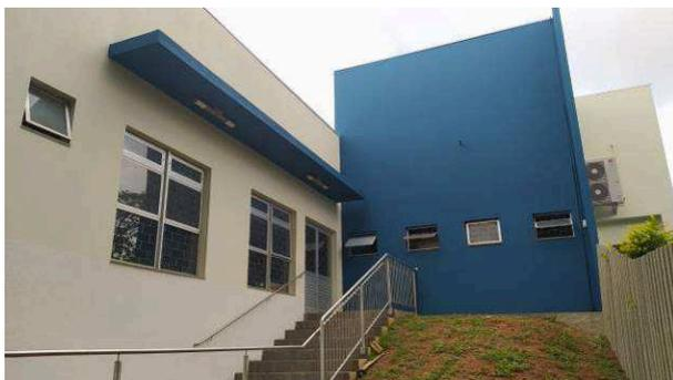
Figura 46C: Fachada lateral esquerda, após pintura acrílica super premium nas cores Nice (equivalente da Lukscollor ao Doric White da Sherwin Williams) e Rushville (equivalente da Lukscollor ao Nocturne Blue, da Sherwin Williams). A tinta utilizada foi a Luksclean
