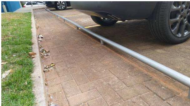
Figura 38C: Bate rodas, após pintura com esmalte sintético na cor "cinza platina"
