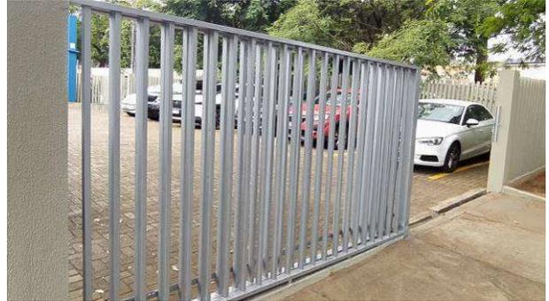
Figura 37C: Portão de veículos do estacionamento público, após pintura com esmalte sintético na cor "cinza platina"
