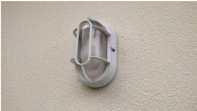
Figura 07E: Novas arandelas tipo tartaruga com lâmpadas bulbo LED
