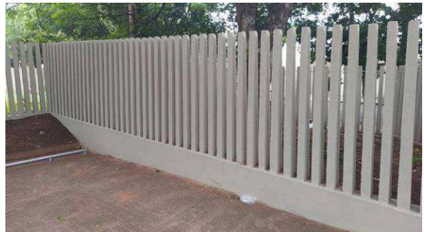
Figura 33C: Muro palito interno (porção esquerda do imóvel), após pintura na cor "concreto", usando látex acrílico super premium (Luksclean)
