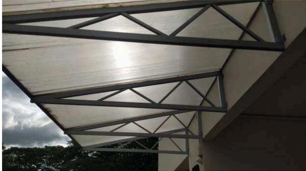
Figura 42C: Estrutura metálica da cobertura, na entrada principal, após aplicação de esmalte sintético na cor "cinza platina"
