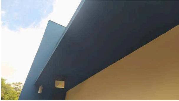
Figura 48C: Face lateral e inferior de marquises, após pintura acrílica super premium na cor Rushville (equivalente da Lukscolor ao Nocturne Blue, da Sherwin Williams) . A tinta utilizada foi a Luksclean
