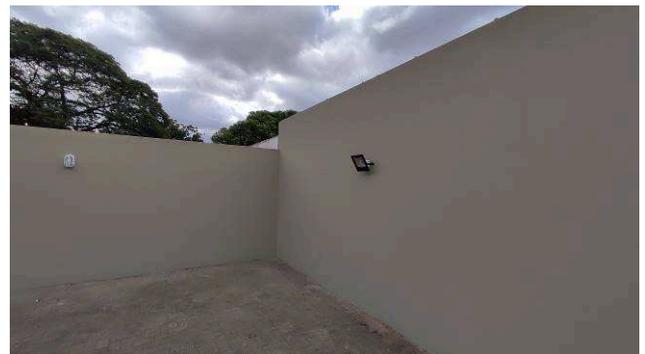
Figura 04E: refletor em LED padrão IP66 para iluminação externa
