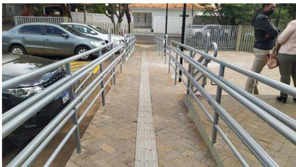
Figura 40C: Guarda-corpo e corrimãos da entrada principal, após pintura com esmalte sintético na cor "cinza platina"
