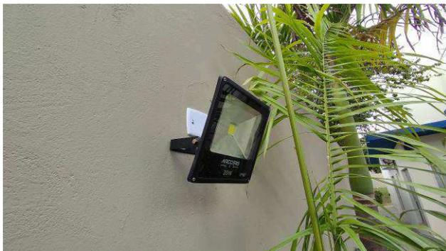
Figura 03E: refletor em LED padrão IP66 para iluminação externa
