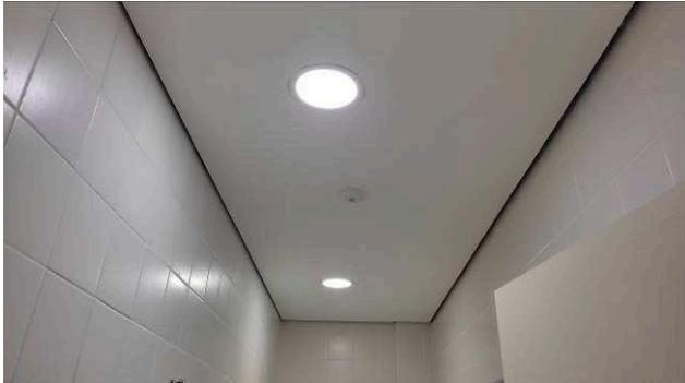
Figura 37E: luminárias e sensores de presença – banheiros PNE
