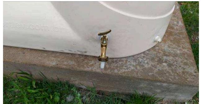
Figura 41C: Torneiras de jardim, instaladas nas cisternas de reuso
