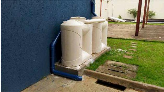
Figura 38C: 2 cisternas de reuso de água da chuva, instaladas lateralmente à escada de incêndio, sobre base em concreto armado
