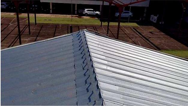
Figura 43E: Sistema de Proteção Contra Descargas Atmosféricas reinstalado – fitas alumínio, captosres, parafusos.
