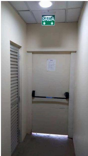
Figura 23C: Barra antipânico instalada em porta corta-fogo localizada na escada enclausurada do bloco da esquerda
