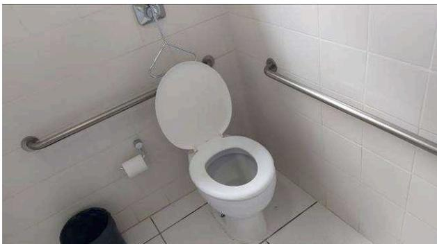
Figura 36C: Vaso sanitário PNE, sem abertura frontal, instalado em banheiro PNE da 1ª Vara
