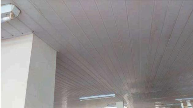
Figura 15C: Refazimento do forro de PVC, com instalação de novas réguas, nos locais outrora removidos para passagem da tubulação de incêndio, no estacionamento dos juízes
