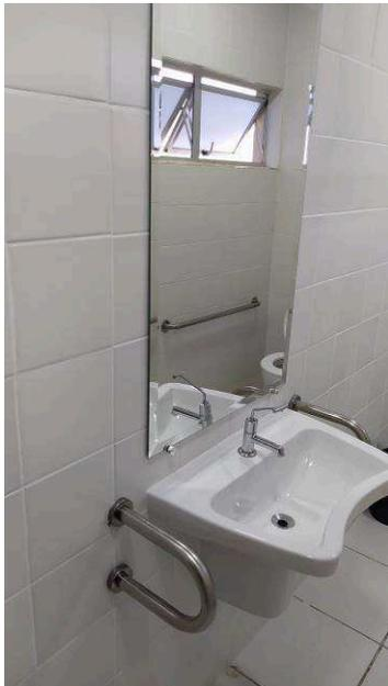
Figura 34C: Conjunto com lavatório, barras de apoio, espelho e torneira, instalados em sanitário PNE do pavimento térreo
