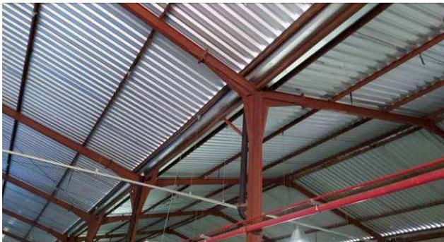
Figura 43C: Calhas em aço galvanizado, instaladas no estacionamento do barracão (ampliação do arquivo)
