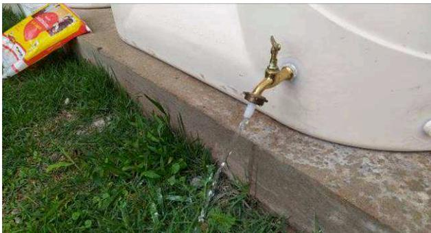
Figura 42C: Realização de teste de funcionamento das torneiras de jardim, instaladas nas cisternas de reuso
