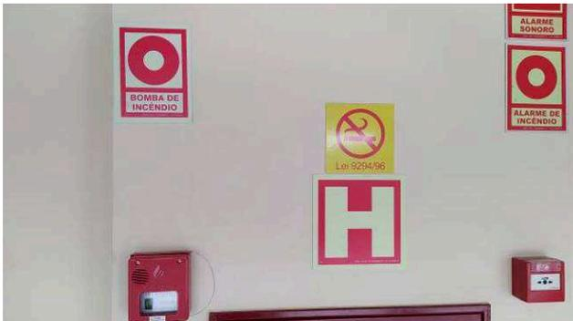
Figura 11C: Detalhe de placas PPC (E7 e outras), instaladas em hidrante do primeiro pavimento
