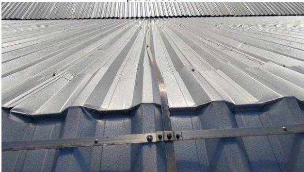
Figura 45E: Sistema de Proteção Contra Descargas Atmosféricas reinstalado – fitas alumínio, captosres, parafusos.
