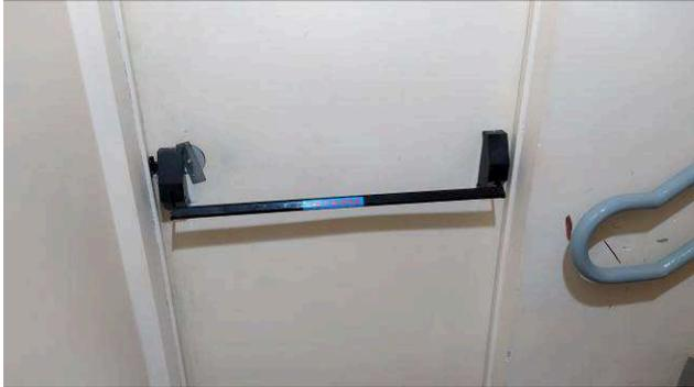
Figura 21C: Barra antipânico instalada em porta corta-fogo localizada na escada de incêndio
