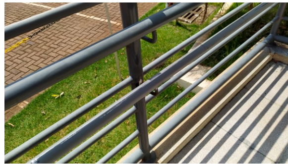
Pintura de corrimãos e guarda-corpos, na rampa PNE do FT de Maringá
