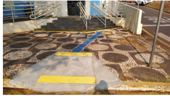
Execução da rampa no passeio público No FT de Umuarama
