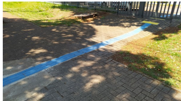
Piso tátil instalado entre o acesso de pedestres e a entrada principal do FT de Maringá
