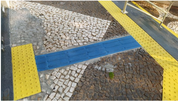
Piso tátil instalado junto à porta de entrada do FT de Umuarama
