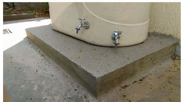
Base de concreto armado, executada em Nova Esperança
