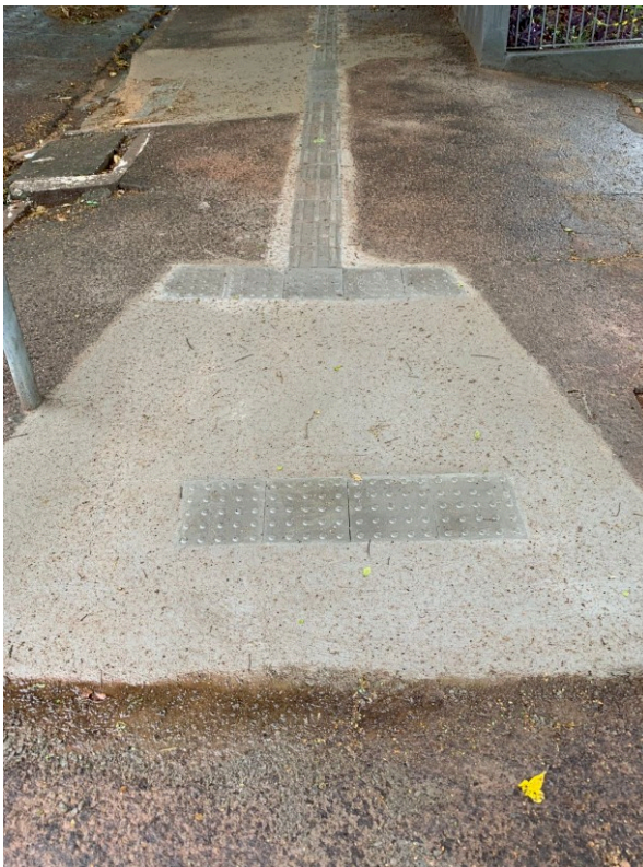
Execução de uma das rampas no passeio público da VT de Nova Esperança
