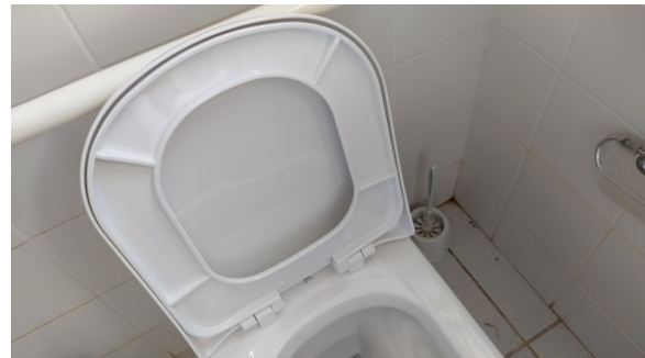
Detalhe do assento instalado em vaso sanitário, em Nova Esperança
