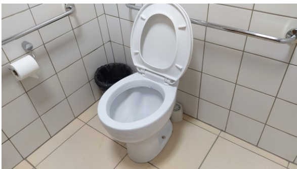
Instalação de vaso sanitário PNE e assento, no FT de Maringá
