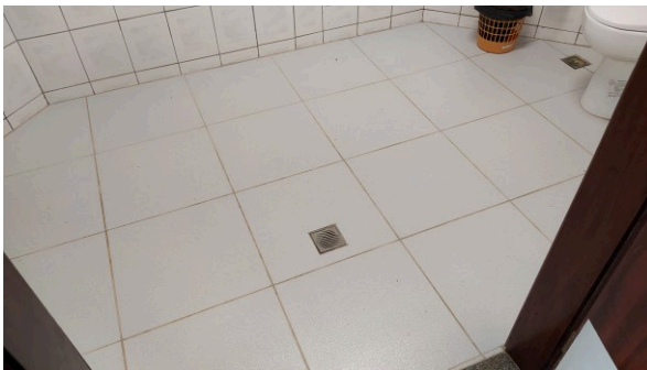
Piso cerâmico instalado no sanitário público PNE do FT de Umuarama
