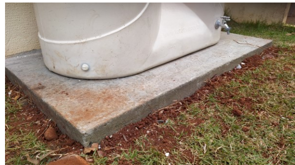
Base de concreto armado, executada em Ivaiporã
