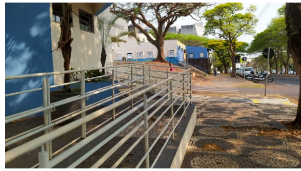
Pintura de corrimãos e guarda-corpos, na rampa PNE do FT de Umuarama
