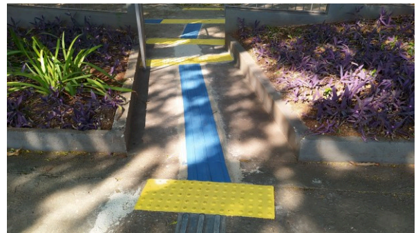
Piso tátil instalado no passeio público de Nova Esperança
