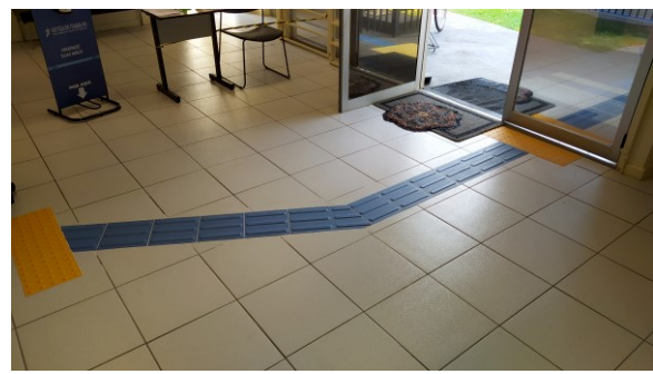
Piso podotátil em porcelanato, instalado na VT de Cianorte
