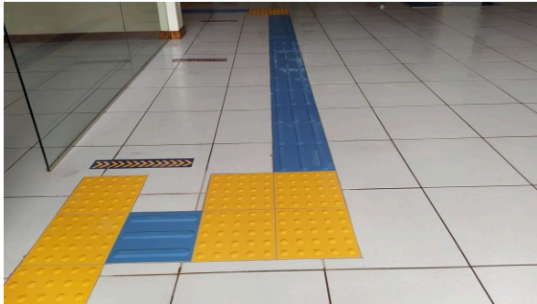
Piso podotátil em porcelanato, instalado na VT de Ivaiporã
