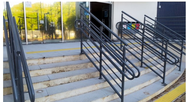
Pintura de corrimãos e guarda-corpos, na escada da entrada principal do FT de Maringá
