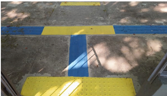
Piso tátil instalado no passeio público de Nova Esperança
