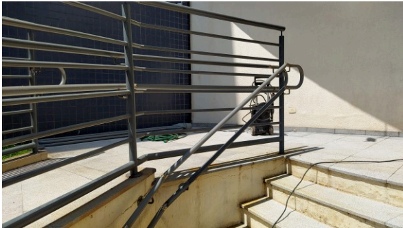
Transformação de corrimão simples em corrimão duplo, na borda da escada de acesso principal ao FT de Maringá
