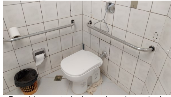
Reposicionamento das barras de apoio para bacia sanitária PNE, no FT de Umuarama
