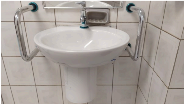
Barras de apoio para lavatório PNE, instaladas no FT de Umuarama
