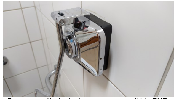
Base para válvula de descarga para sanitário PNE, instalada em sanitário do FT de Maringá
