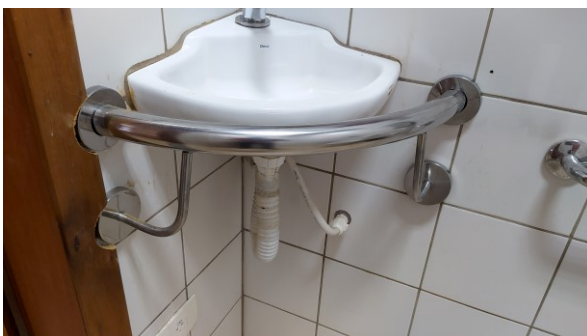
Barras de apoio para lavatório PNE, instaladas no FT de Maringá
