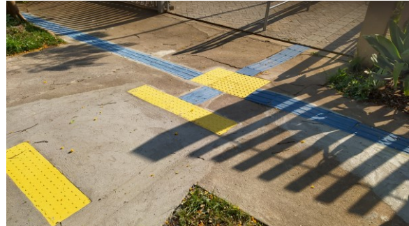
Piso tátil instalado no passeio público de Paranavaí
