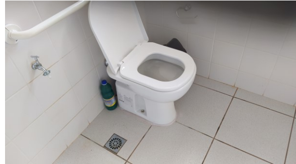
Vaso sanitário PNE, instalado em Nova Esperança
