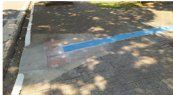
Piso tátil instalado no passeio público de Maringá
