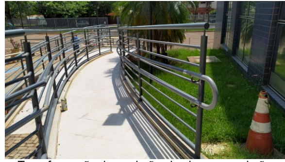
Transformação de corrimão simples em corrimão duplo, na rampa de acesso PNE ao FT de Maringá
