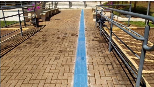
Piso tátil instalado entre o acesso de pedestres e a entrada principal do FT de Maringá
