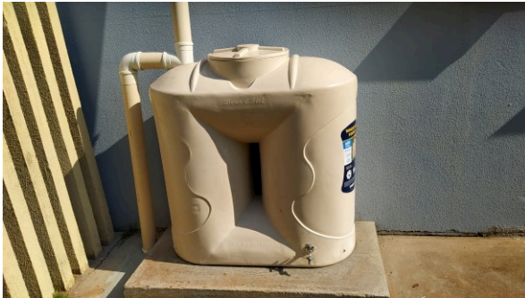
Kit de reserva e aproveitamento de águas pluviais, instalado na VT de Paranavaí
