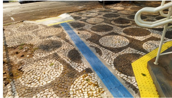
Piso tátil instalado no passeio público do FT de Umuarama
