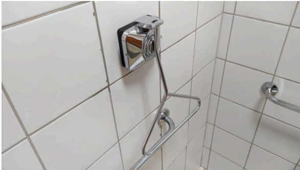
Base para válvula de descarga para sanitário PNE, instalada em sanitário do FT de Maringá
