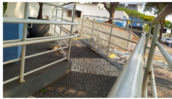
Transformação de corrimão simples em corrimão duplo e correção da altura do guarda-corpo, na rampa de acesso PNE ao FT de Umuarama
