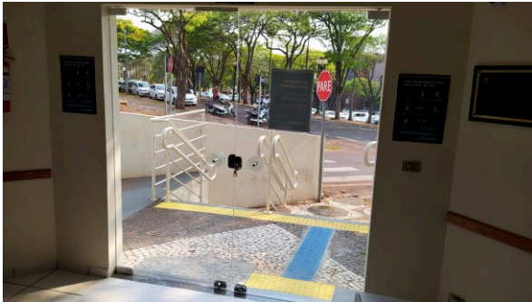
Instalação de Porta de vidro temperado nova no FT de Umuarama
