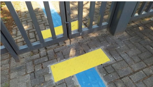
Piso tátil instalado no portão de pedestres do FT de Maringá
