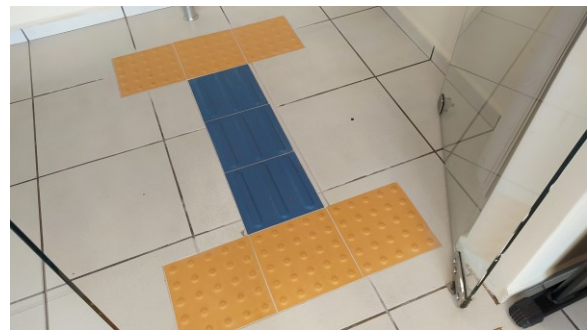
Piso podotátil em porcelanato, instalado na VT de Nova Esperança
