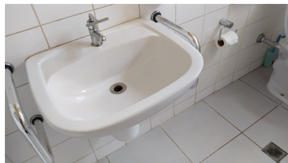
Barras de apoio para lavatório PNE, instaladas na VT de Cianorte
