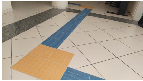
Piso podotátil em porcelanato, instalado na VT de Paranavá
