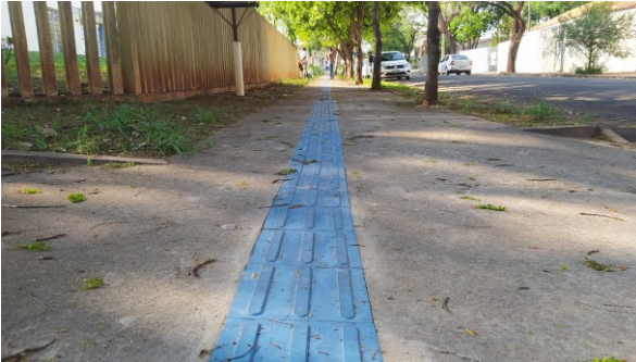
Piso tátil instalado no passeio público de Paranavaí
