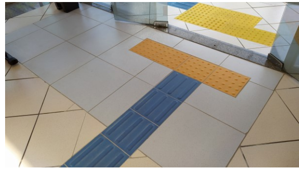
Fechamento do rebaixo para capacho com piso cerâmico na VT de Paranavaí
