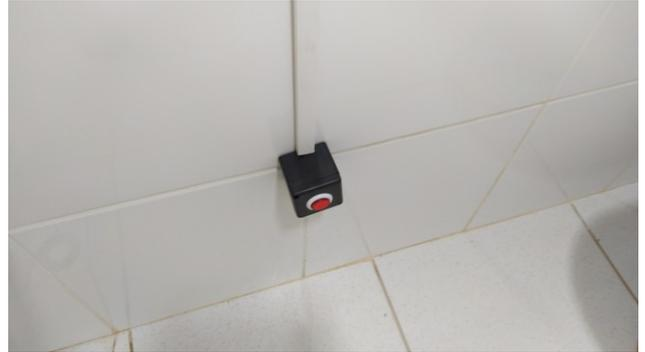
Figura 54C: Botão de acionamento do alarme, instalada dentro do BWC PNE do segundo andar
