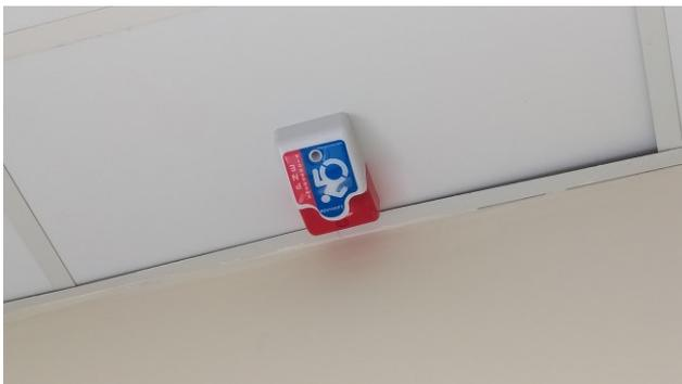
Figura 49C: Alarme audiovisual para PNE, instalado no BWC público do pavimento térreo
