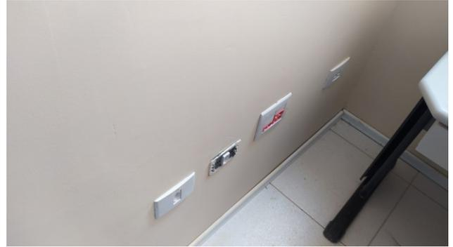
Figura 70C: Caixas 4"x2" e 4"x4" de elétrica e lógica, instaladas na parede falsa da sala dos assistentes
