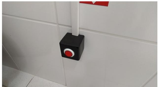
Figura 50C: Botoeira de acionamento do alarme, instalada dentro do BWC PNE do pavimento térreo
