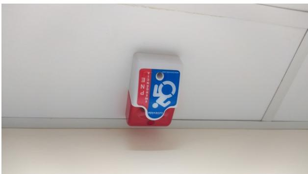
Figura 51C: Alarme audiovisual para PNE, instalado no BWC público do primeiro andar
