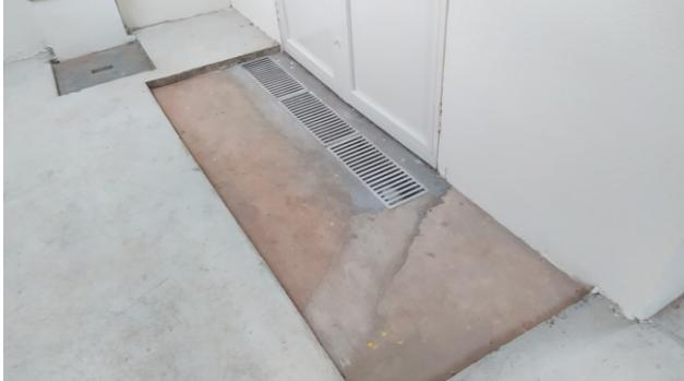
Figura 63C: Canaleta com grelha, instalada junto à porta de entrada da cabine de força
