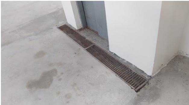
Figura 65C: Canaleta com grelha, instalada junto à porta do elevador
