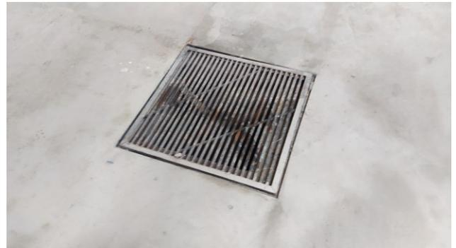
Figura 66C: Grelha em ferro fundido, instalada na tampa das caixas de drenagem pluvial do subsolo
