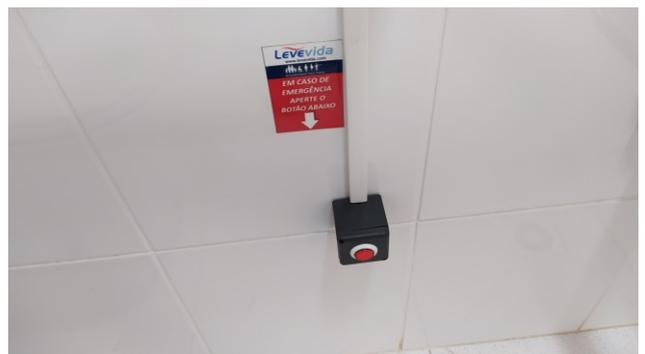
Figura 52C: Botoeira de acionamento do alarme, instalada dentro do BWC PNE do primeiro andar
