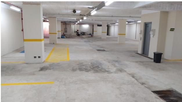
Figura 67C: Grelhas em ferro fundido, instaladas nas tampas das caixas de drenagem pluvial do subsolo
