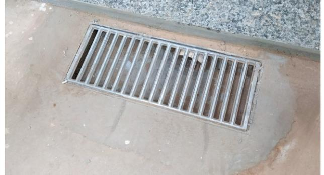
Figura 64C: Canaleta com grelha, instalada na sala do No-break
