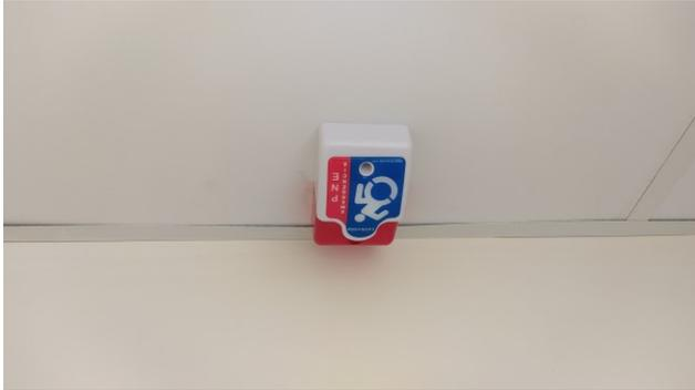
Figura 53C: Alarme audiovisual para PNE, instalado no BWC público do segundo andar
