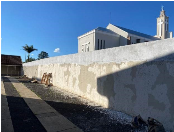
Figura 15C: Muro lateral direito com aumento já rebocado
