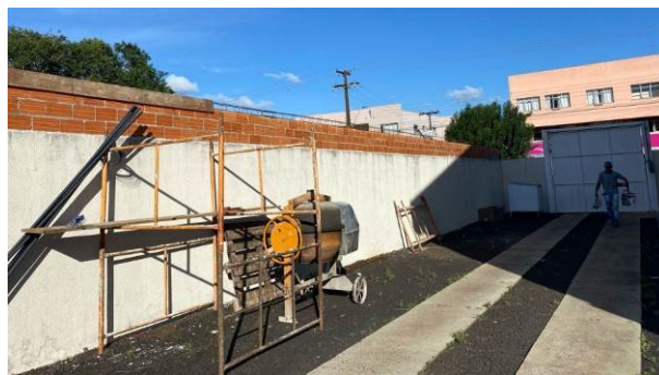
Figura 02C: Utilização de andaime metálico
