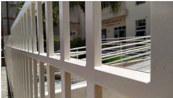
Figura 24C: Pintura do gradil frontal e portões
