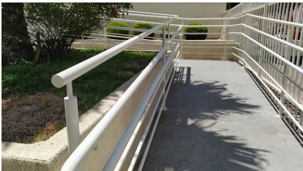
Figura 21C: Pintura do guarda-corpo e corrimãos da rampa de acesso PNE, na parte frontal do imóvel
