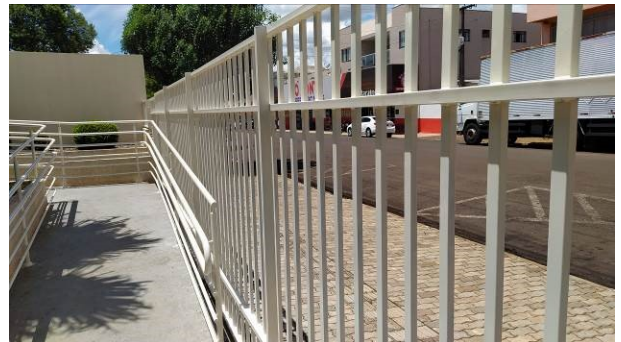
Figura 25C: Pintura do gradil frontal e portões
