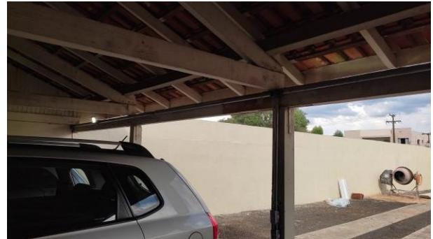
Figura 10E: infraestrutura elétrica e cabeamento parcial - edícula
