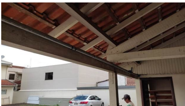
Figura 11E: infraestrutura elétrica e cabeamento parcial - edícula
