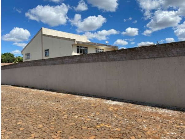
Figura 13C: Execução do chapisco do aumento de altura no muro lateral direito
