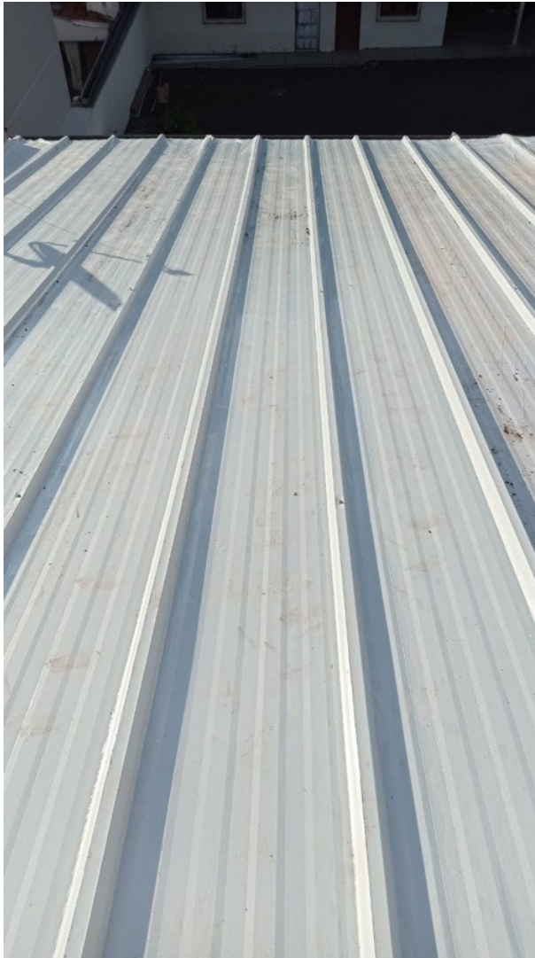
Figura 09C: Telhas instaladas na água posterior do prédio principal
