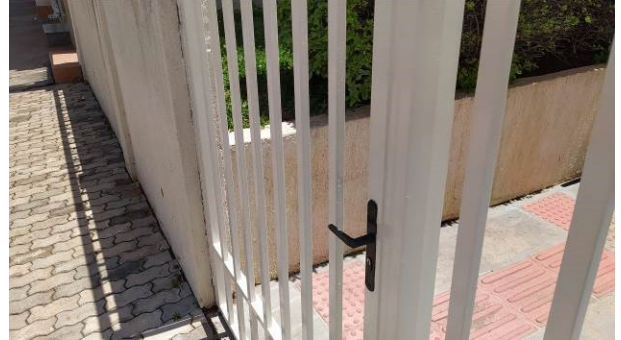
Figura 23C: Pintura do gradil frontal e portões
