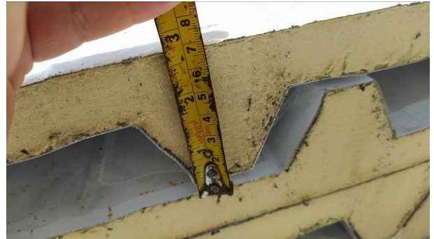
Figura 04C: Aferição da altura da onda da telha termoacústica
