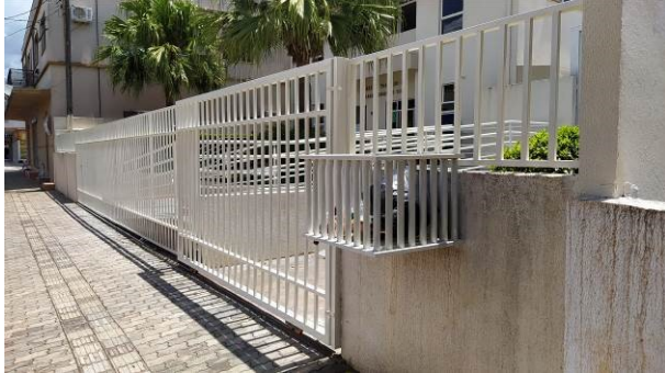
Figura 22C: Pintura do gradil frontal e portões
