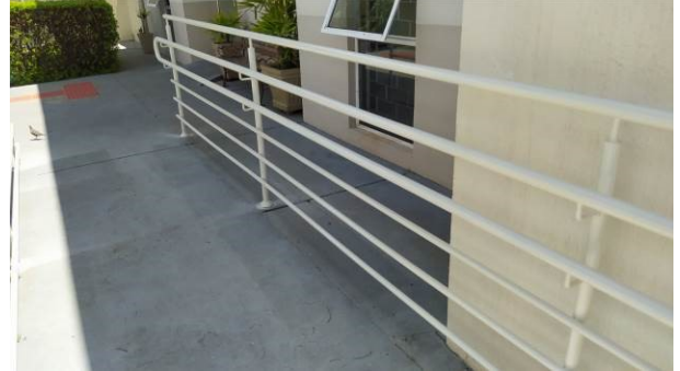
Figura 18C: Pintura do guarda-corpo e corrimãos da rampa de acesso PNE, na parte frontal do imóvel
