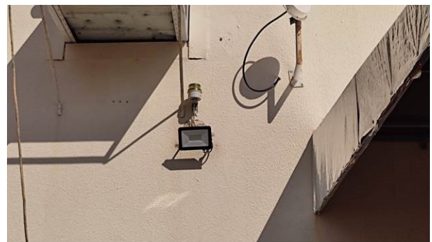
Figura 04E: Refletor 50W LED edificação principal
