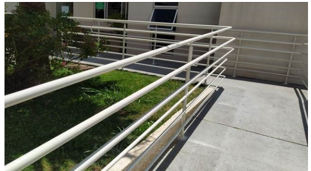
Figura 20C: Pintura do guarda-corpo e corrimãos da rampa de acesso PNE, na parte frontal do imóvel
