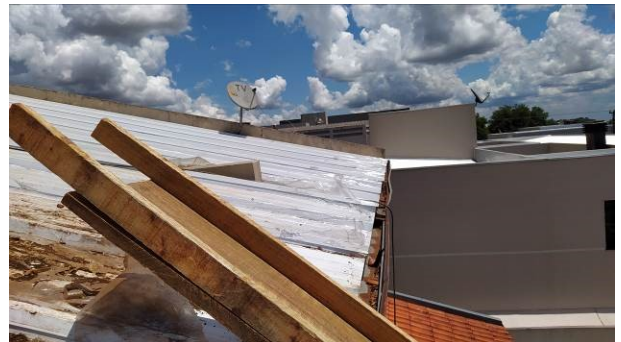
Figura 08C: Telhas instaladas na água posterior do prédio principal
