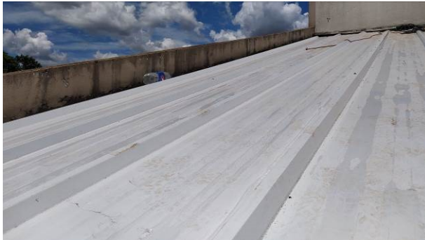
Figura 03C: Instalação de telha termoacústica na água posterior do prédio principal
