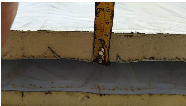
Figura 05C: Aferição da altura de preenchimento da telha termoacústica
