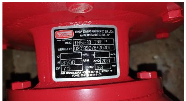
Figura 18E: Bomba hidrantes (plaqueta bomba)
