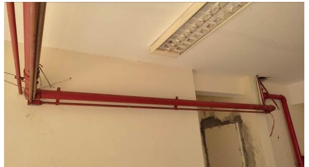
Figura 08E: infraestrutura e cabeamento ampliação sistema SDAI e acionamento da bomba
