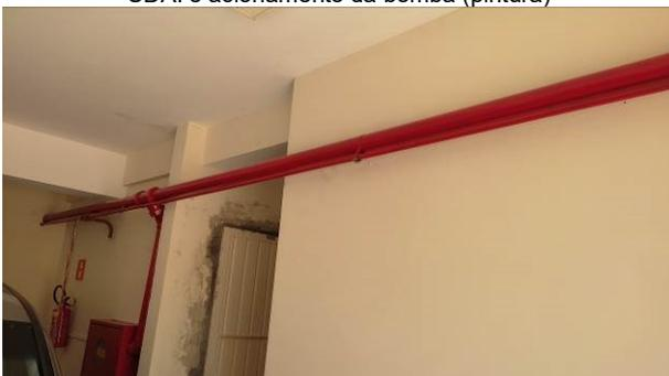
Figura 15E: infraestrutura e cabeamento ampliação sistema SDAI e acionamento da bomba
