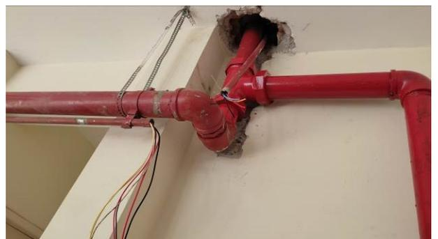
Figura 10E: infraestrutura e cabeamento ampliação sistema SDAI e acionamento da bomba
