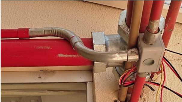
Figura 11E: infraestrutura e cabeamento ampliação sistema SDAI e acionamento da bomba
