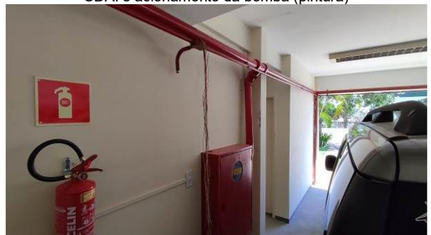
Figura 16E: infraestrutura e cabeamento ampliação sistema SDAI e acionamento da bomba
