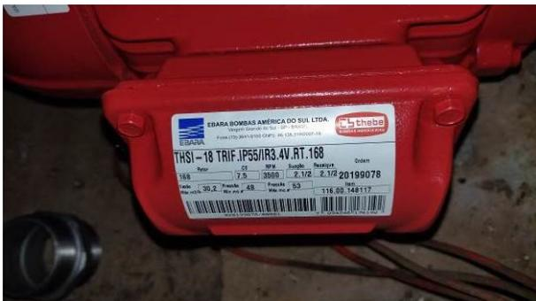
Figura 21E: Bomba hidrantes (identificação geral)
