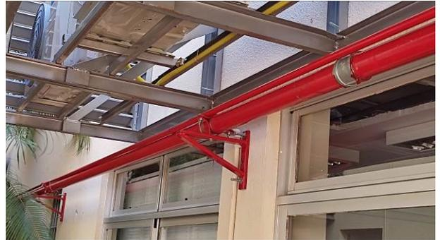
Figura 12E: infraestrutura e cabeamento ampliação sistema SDAI e acionamento da bomba
