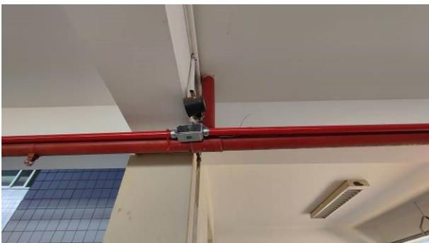
Figura 05E: infraestrutura e cabeamento ampliação sistema SDAI e acionamento da bomba
