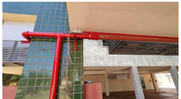
Figura 06E: infraestrutura e cabeamento ampliação sistema SDAI e acionamento da bomba
