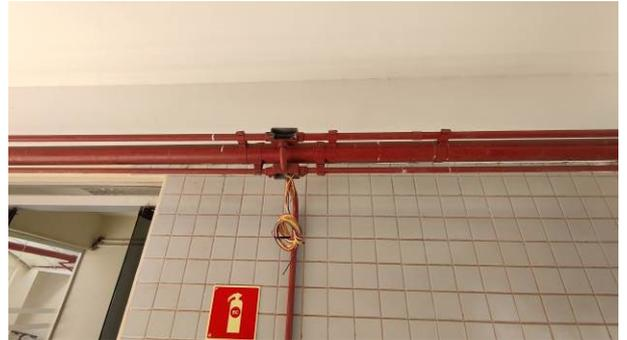
Figura 04E: infraestrutura e cabeamento ampliação sistema SDAI e acionamento da bomba
