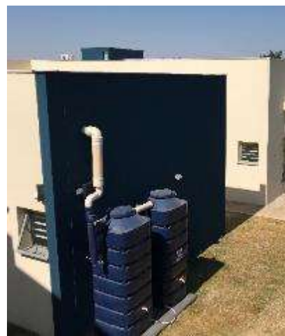
Modelo de tanque de aproveitamento – aproveitar a prumada da calha e modelo
