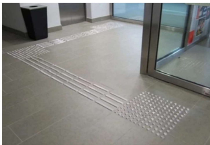
Piso tátil em inox instalado
