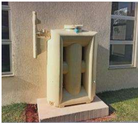
Modelo de tanque de aproveitamento – aproveitar a prumada da calha e modelo
