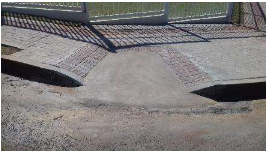
Acesso – guia rebaixada meio fio
