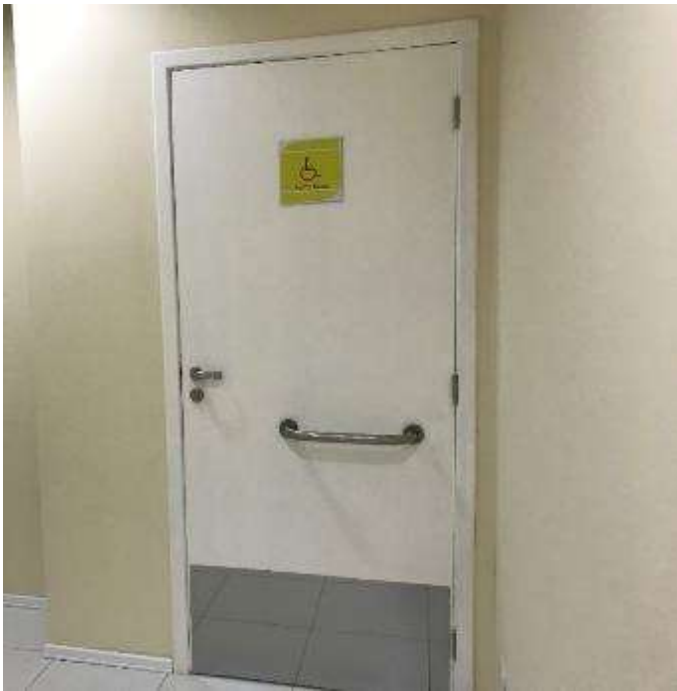
Modelo de porta - Instalações sanitárias PCD
