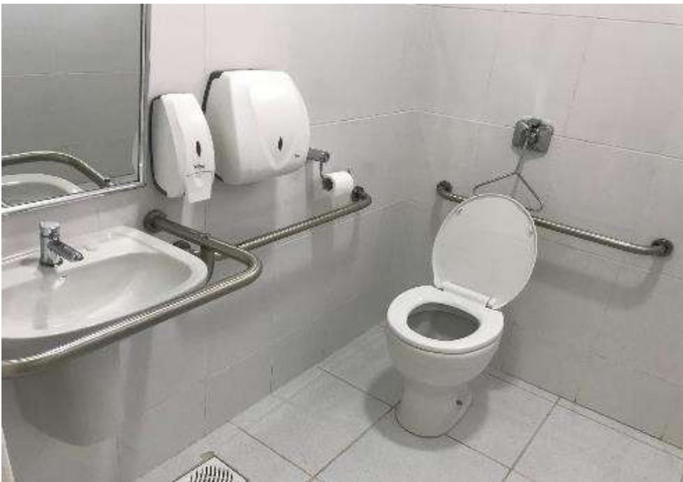
Modelo de Instalações sanitárias PCD
