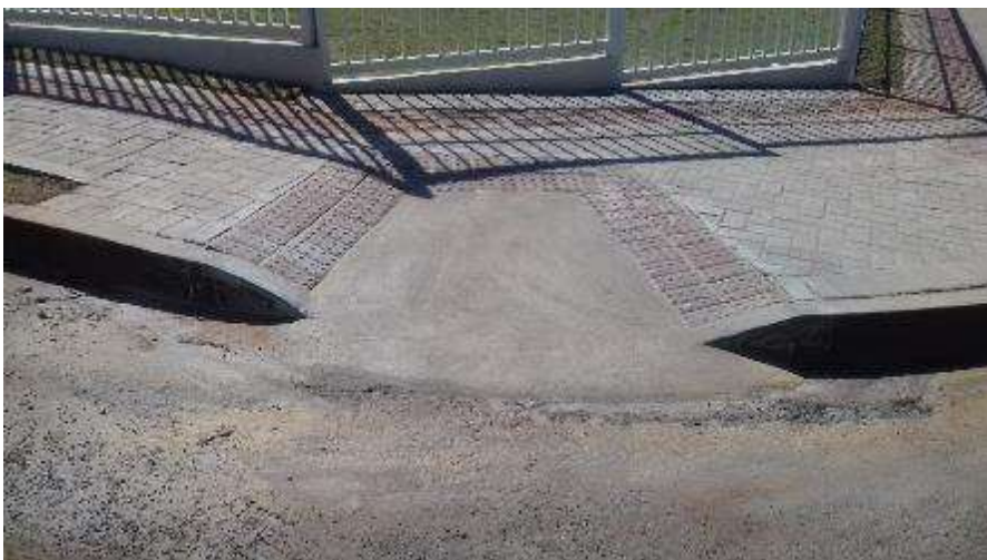
Acesso – guia rebaixada meio fio
