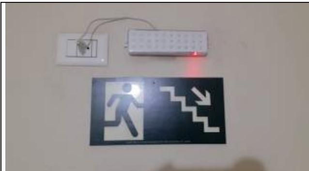
Figura 09: Luminária de emergência
