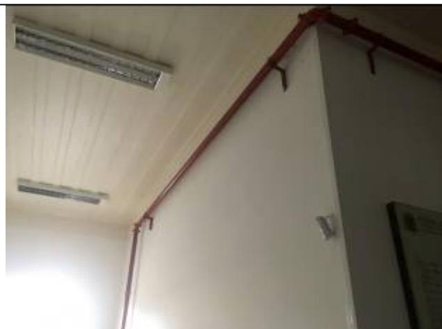
Figura 03: Tubo de aço galvanizado.
