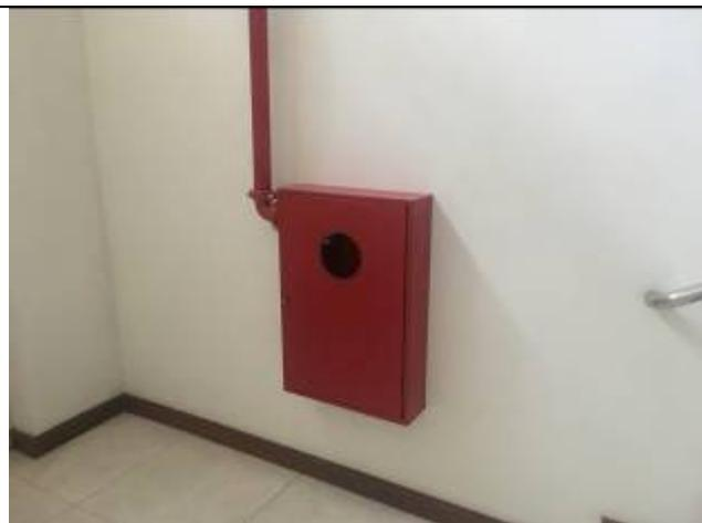
Figura 05: Abrigo de hidrante.
