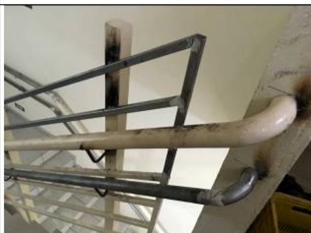
Figura 16: Correção de altura do guarda corpo – escada enclausurada.
