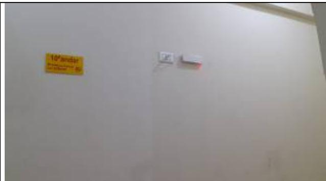
Figura 10: Luminária de emergência.
