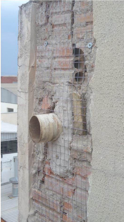
Figura 2a – Reparos em revestimentos externos
