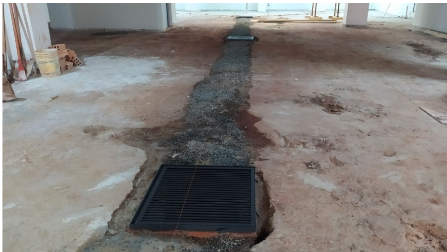
Figura 3 – Realização de serviços no subsolo
