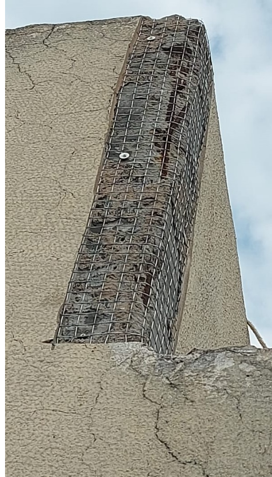
Figura 2b - Reparos em revestimentos externos
