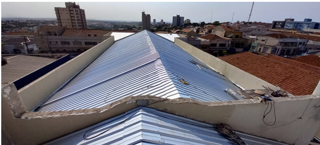
Figura 1 – Execução de serviços na cobertura
