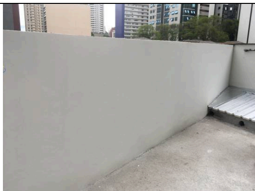
Figura 15: Pintura platibanda.
