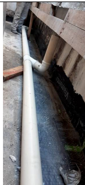
Figura 14: Tubulação águas pluviais.
