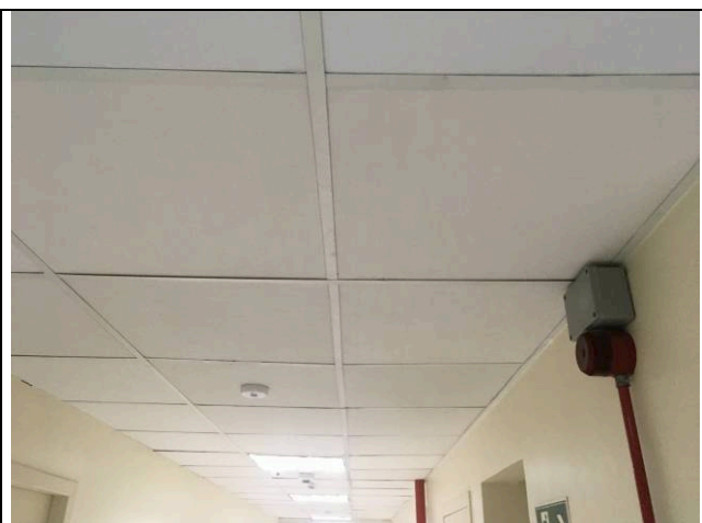
Figura 03: Forro reinstalado.
